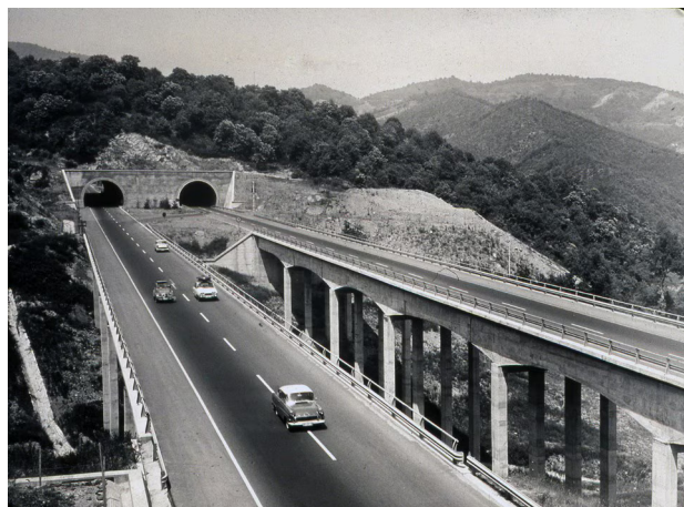
Fig. 1.4 Viaduct and tunnel Massa (Archivio Storico Autostrade per l'Italia, 1962)
