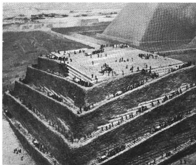
17. Bouwhellingen rondom een piramide. Het model van Dunham (1956) van de piramide van Mycerinus te Gizeh.
