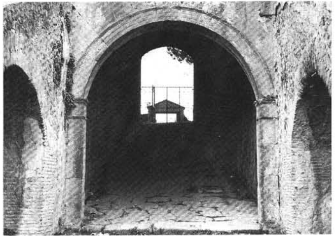
171. Natuurstenen boog bij het amphitheater te Pompeji met een rechthoekige beëindiging aan de bovenzijde. 80 nC.
