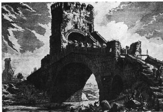
217. De Pons Salarius over de Anio bij Rome. Een voorbeeld van een boogbrug met een steile oprit. Naar een tekening van Piranesi.
