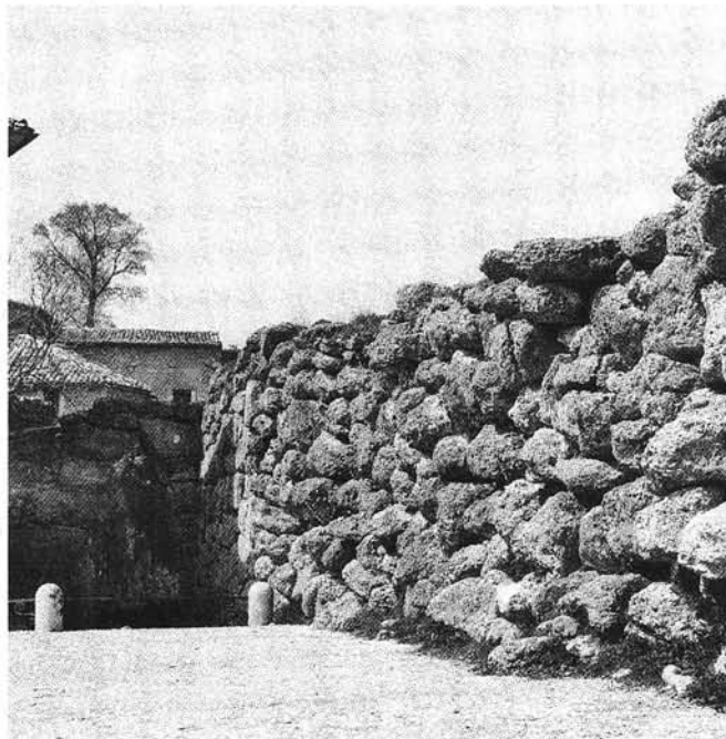
141. Muur van de acropolis van Arpino. 5de eeuw vC. Stapelwerk van ruwe natuursteenblokken.
