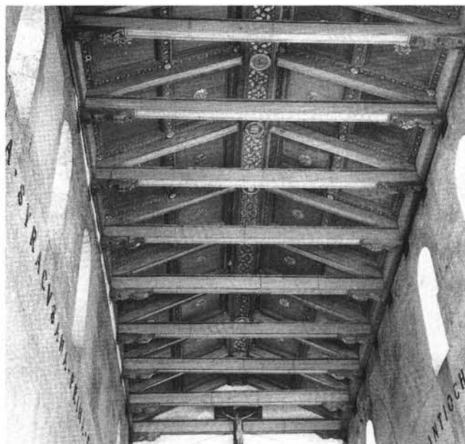
165. De huidige kapconstructie van de kathedraal te Syracuse. Het houten driehoekspant in zijn eenvoudigste vorm, met alleen twee spantbenen en een trekbalke. Overspanning 10 m.
