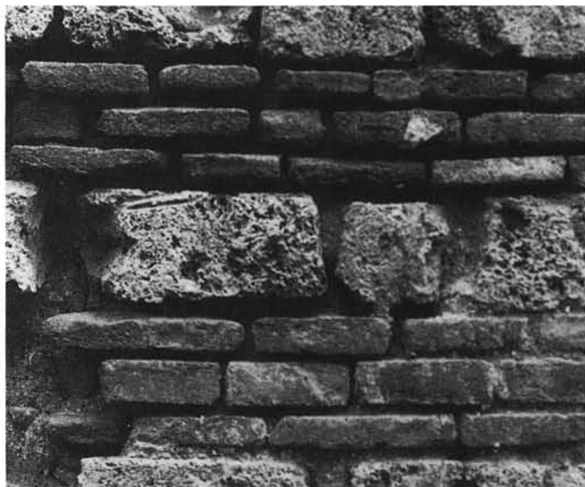
149. Opus mixtum , uit baksteen en tufblokken.
