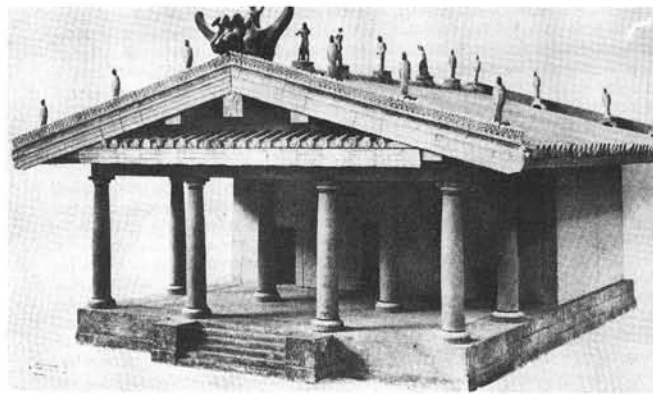
117. De tempel van Juno Sospita te Lanuvium. 5de eeuw vC. Reconstructie van een Etruskische tempel in houtconstructie volgens Vitruvius.
