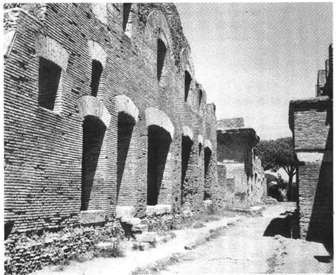
173. Een muur met openingen waarboven segmentbogen van baksteen te Ostia. Begin 2de eeuw nC.
