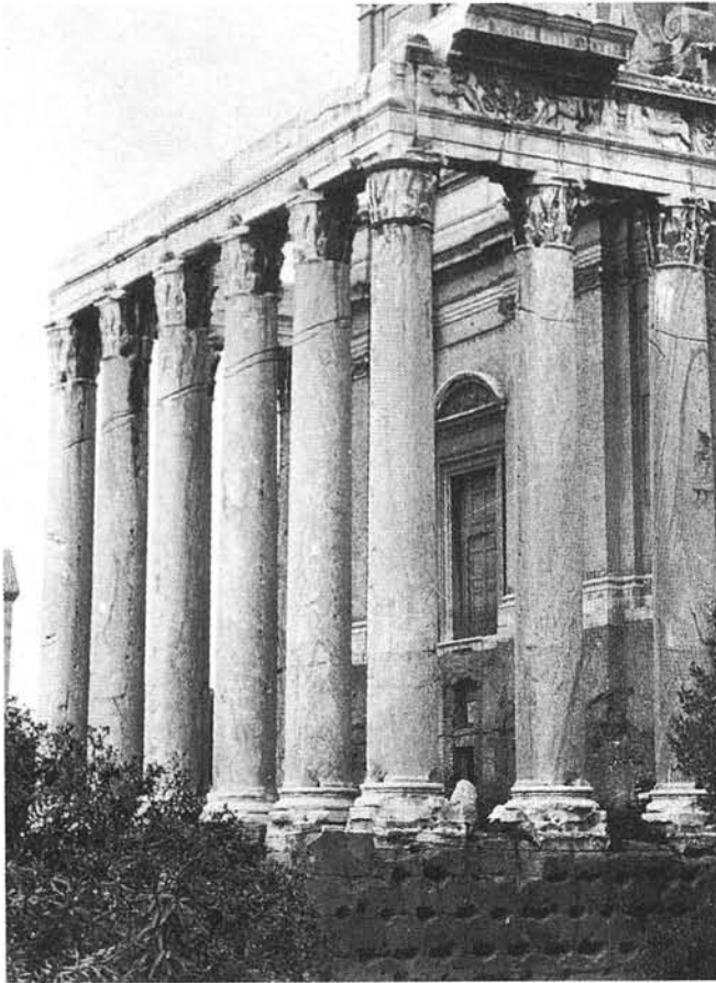
157. De tempel van Antoninus en Faustina te Rome. 140 nC. De zuilen, hoog 14 m, hebben monoliete schachten van fijn marmer.
