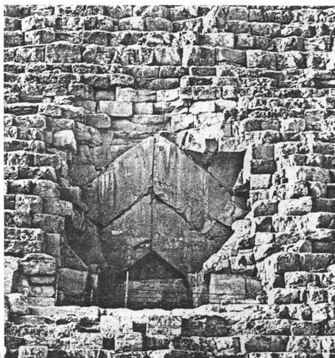
35. Ontlastingsconstructie, bestaande uit schuin geplaatste natuursteenblokken, in de piramide van Cheops te Gizeh. 2600 vC.
