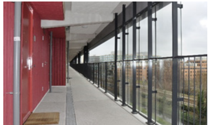
Fig 19. Paulinesymfonie gallery (bouwwereld, 2012)
