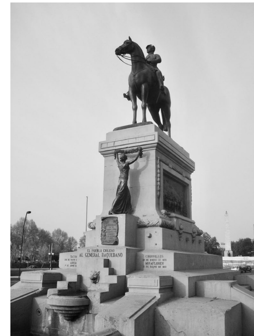
4.00. Monument of General Baquedano, Plaza Italia
