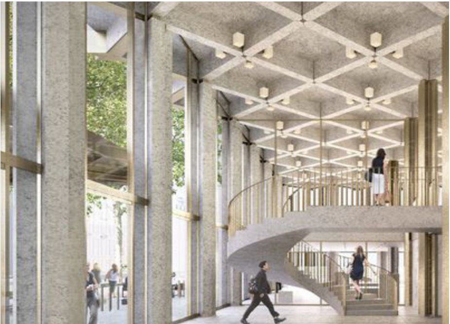
Fig. 259. & Fig. 260. & Fig. 261. Waffle concrete slab
