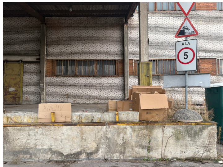
Fig. 15. Paljassaare tee 18, cargo warehouse
