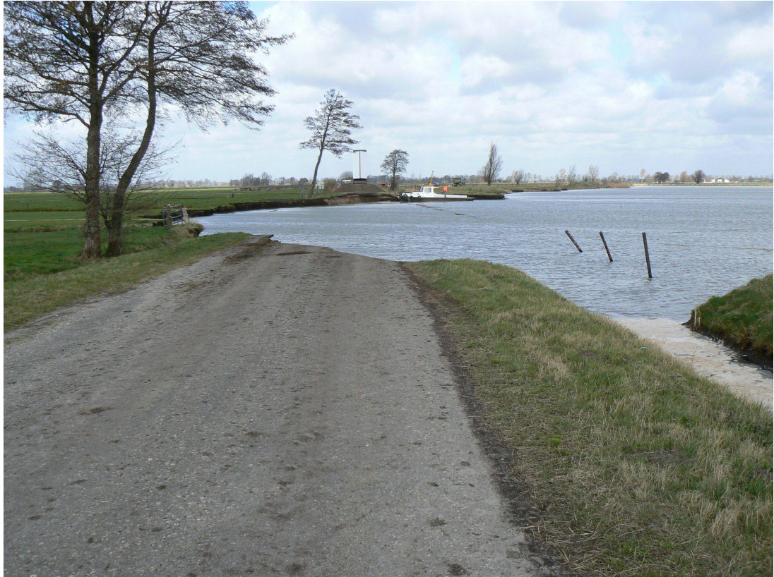
Foto 1 Oeverinscharing zandwinput Hooijdijk, 2008
