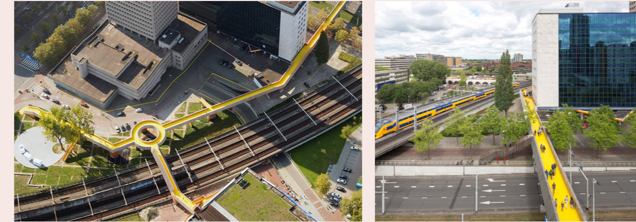
Figure 32: Luchtsingel, Rotterdam (Van Duivenbode, 2022)
