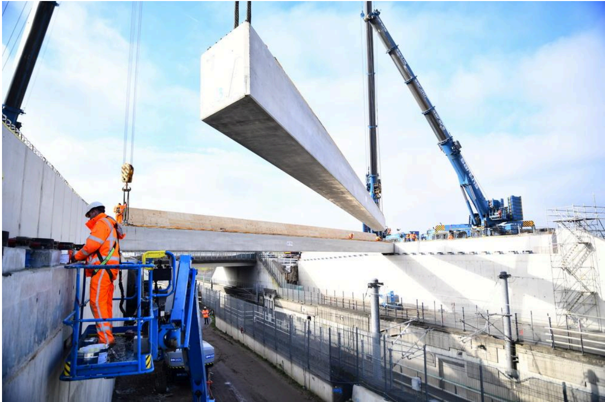
Figuur 1. Plaatsing van liggers bij de bouw van een viaduct (Rijkswaterstaat, 2023e).
