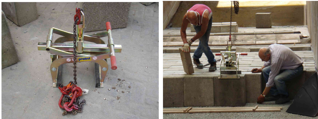
Figuur 3 Plaatsen van blokken
