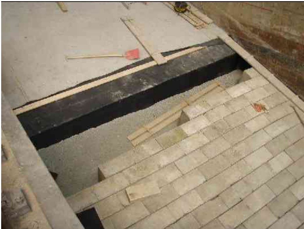
b) Inbouw bloklaag
