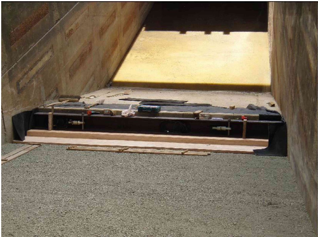
b) Afwerken taludonderkant
