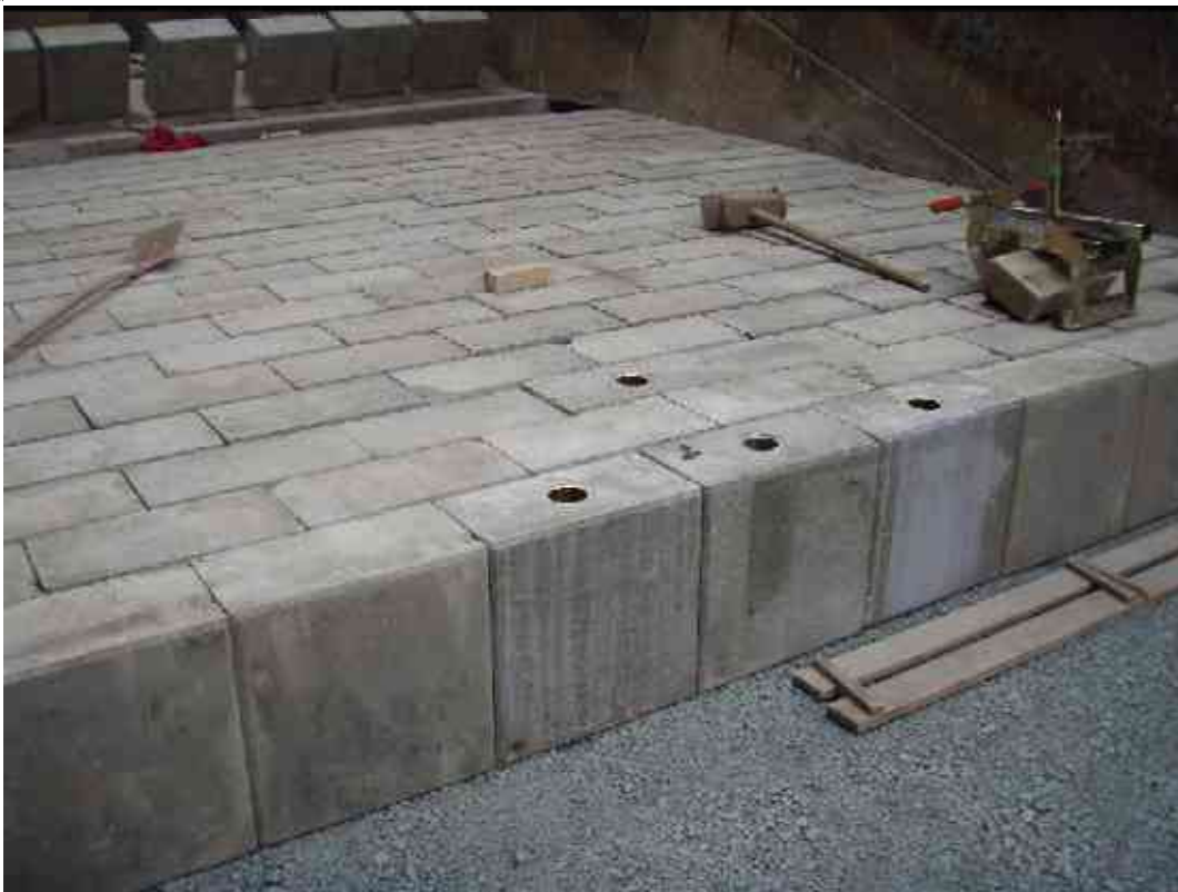
b) Inbouw bloklaag
