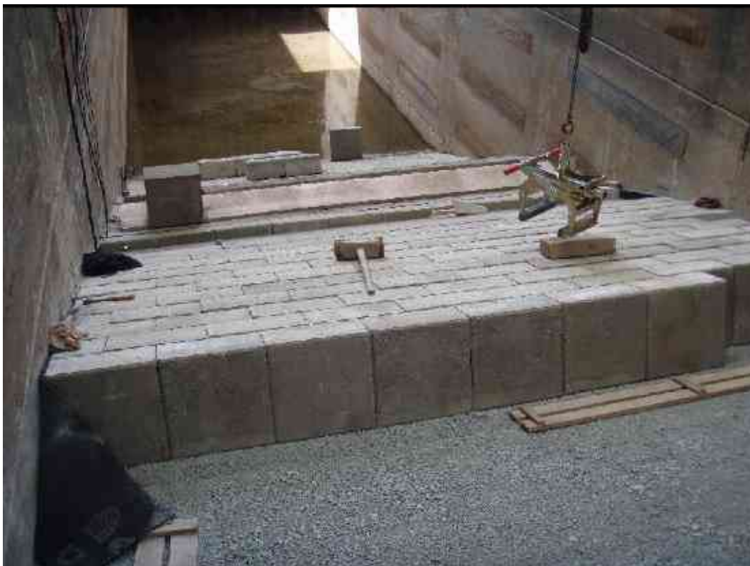
b) Inbouw bloklaag
