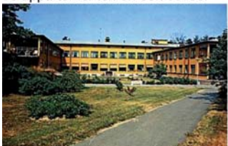
Gebers Housing Project, Zweden Omvang: 32 flatwoningen in 1998 voorzien van scheidingstoiletten
