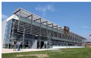
SolarCity Linz, Oostenrijk (2004) Omvang: scheidingstoiletten voor 88 appartementen en een school
