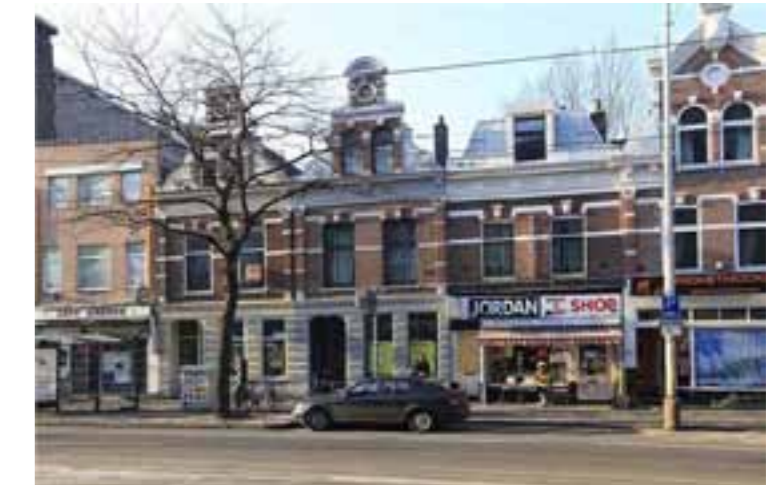
Karakteristieke voor-oorlogse gevels (eigen foto)
