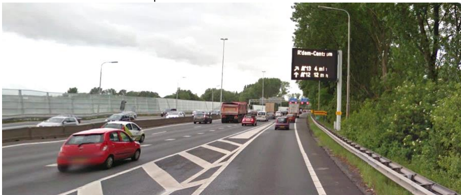
K Bij het convergentiepuntstuk begint op de linkerrijstrook een doorgetrokken lijn.
