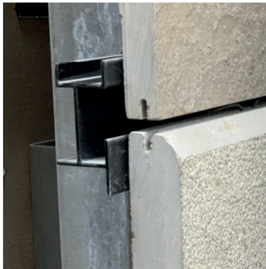
Invisible fixation of the stone( V-CLIP -LABELFAÇADE)
