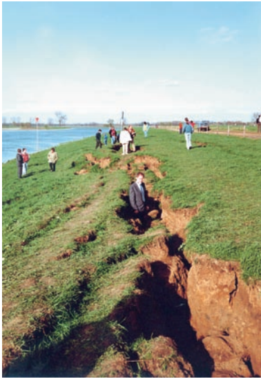
Figuur 8.1 Diepe scheuren in de grond langs de Maas bij Roermond na de aardbeving van 13 april 1992 (foto: KNMI)
