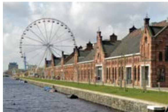
Westergasfabriek in Amsterdam Bron: http://www.deur-automaat.info/vve-beurs-amsterdam/
