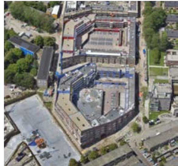
Delftwijk, Haarlem. Van portiekwoning naar stedelijk alzijdig blok. Bron: http://www.delftwater.nl/?p=125 geraadpleegd op: November 2016
