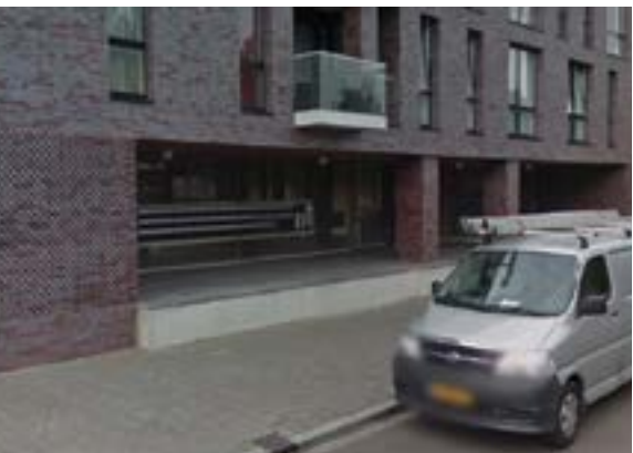
Terug gelegen ingang tussen stoep en gebouw met balkon. Bron: maps.google.nl geraadpleegd op: december 2016
