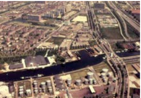
Holtenbroek voor de herstructurering Bron: http://farm3.static.flickr.com/2384/2180557844_2030f997cb_o.jpg geraadpleegd op: november 2016
