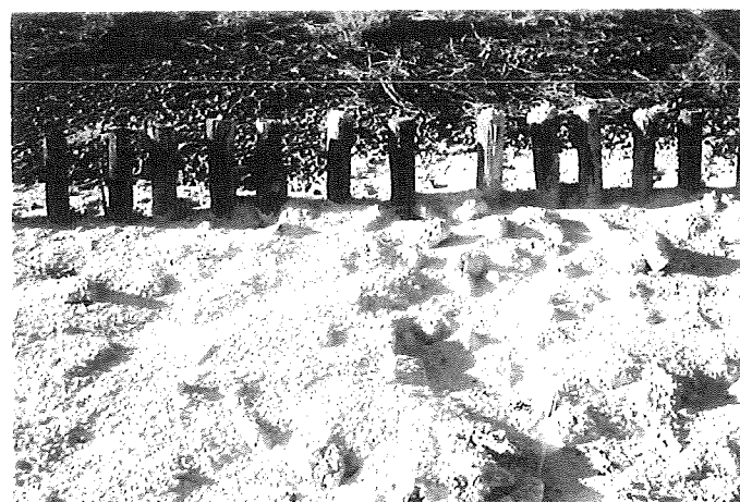
3. Breuksteen 90/180 mm met colloïdaal beton
