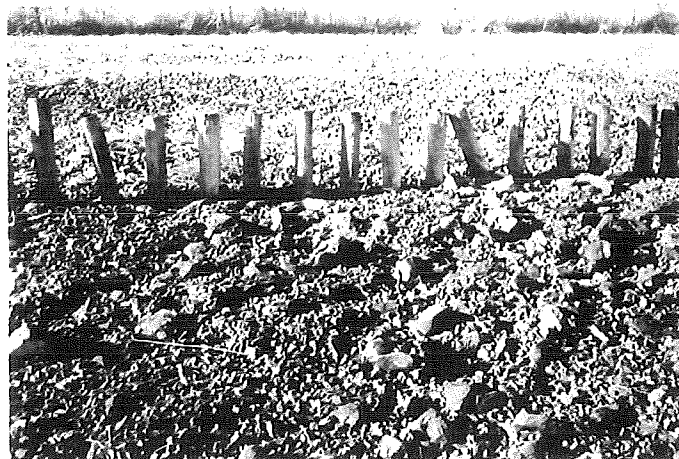
2. Breuksteen 90/ 180 mm met gietasfalt en lavasteen
