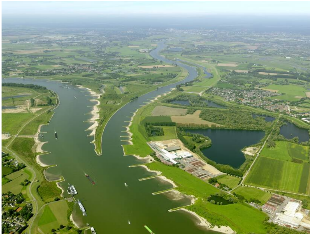
Figure 2.37: The river Waal, normalised with groynes ( Rijkswaterstaat ).
