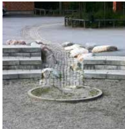
Infiltratiepunt in de wijk met tijdelijke waterberging
