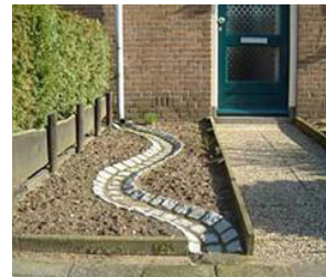
Afkoppelen regenwater naar gescheiden rioel
