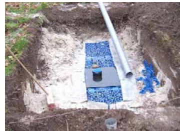
Aanleg infiltratiekragen onder een vijver
