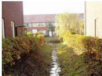
Afkoppelen regenwater naar oppervlakte water
