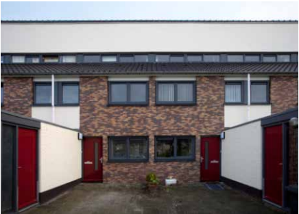
Renovatie Maarssenbroek (Bron: BAM)
