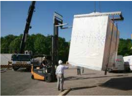
Aanvoer Prefab badkamer/toilet (Bron: Faay)
