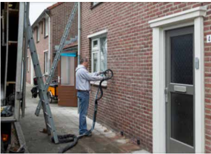
aanbrengen gevelisolatie (Bron: Capar de Haan)
