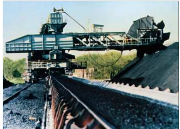
Figuur 2.3: trencher reclaimer
