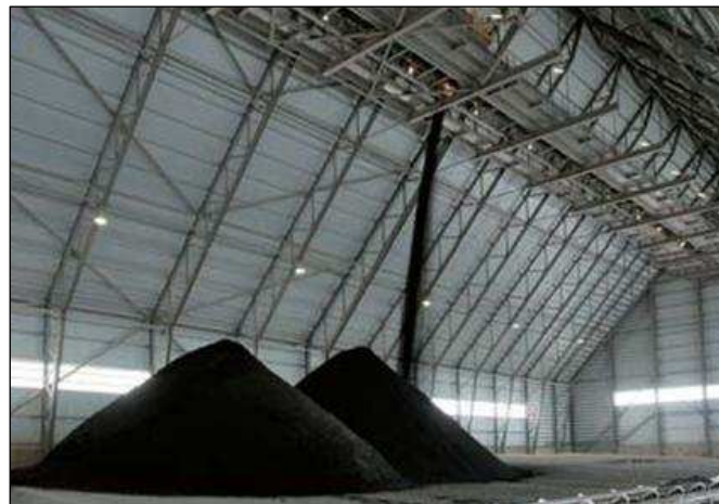
Figuur 1.5: apex stacker bij een afgesloten kolenopslag
