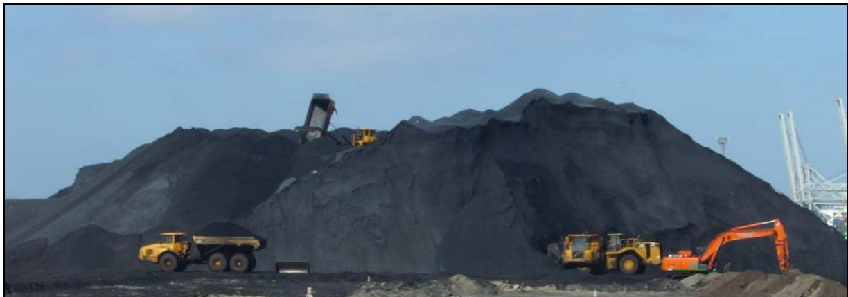
Figuur 4.9: opslag gecreëerd met dumpers en shovels op het werkkterrein van EMO
