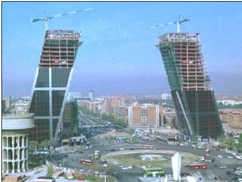
Figuur 4.17 Puerta de Europa in aanbouw
