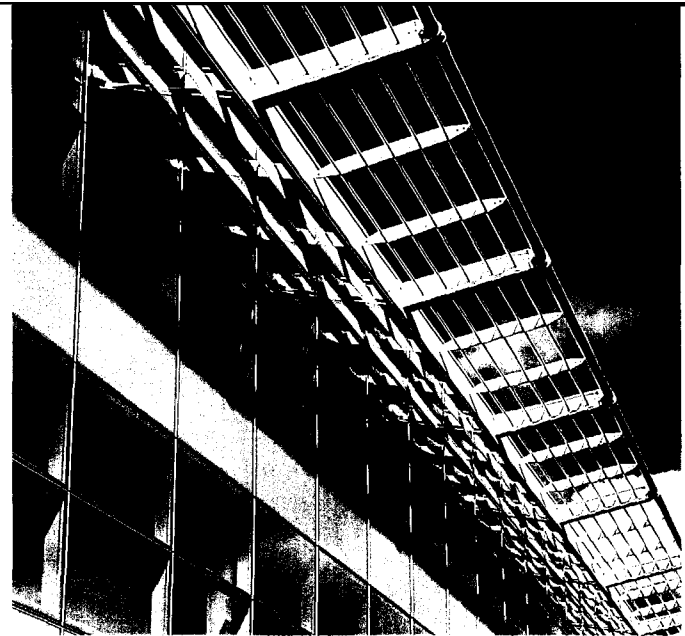
6.33 Isolatiepanelen met gescreende beglazing met een verlopende bedrukkingsgraad, B3-gebouw, Stockley Park, London, 1989. architect: Sir Norman Foster and Partners
