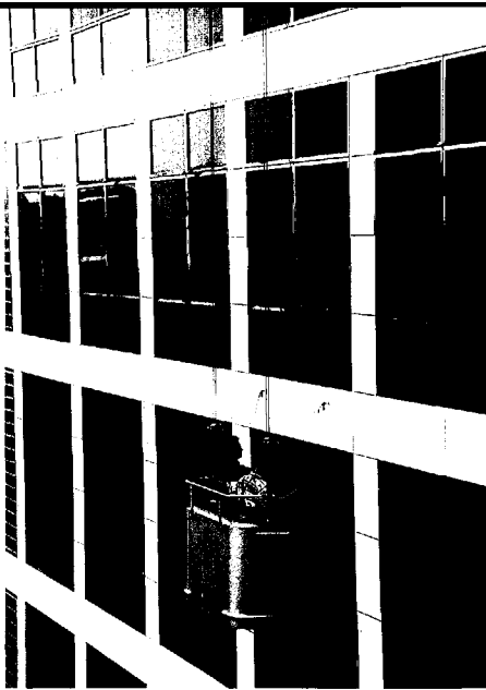
4.4.4 Gondel met kabelverankering aan de gevel, Haagse Poort, Den Haag architect: Rob Ligvoet, Kraaijvanger-Urbis
