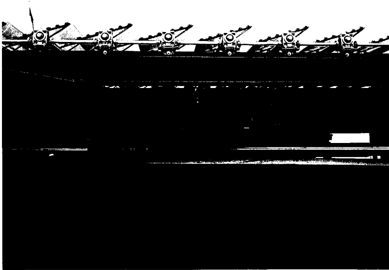
6.70 Retroreflecterende prismalamellen van plexiglas als zon- en lichtregulering boven het glazen dak, Deutscher Bundestag, Bonn. architect: Behnisch und Partners
