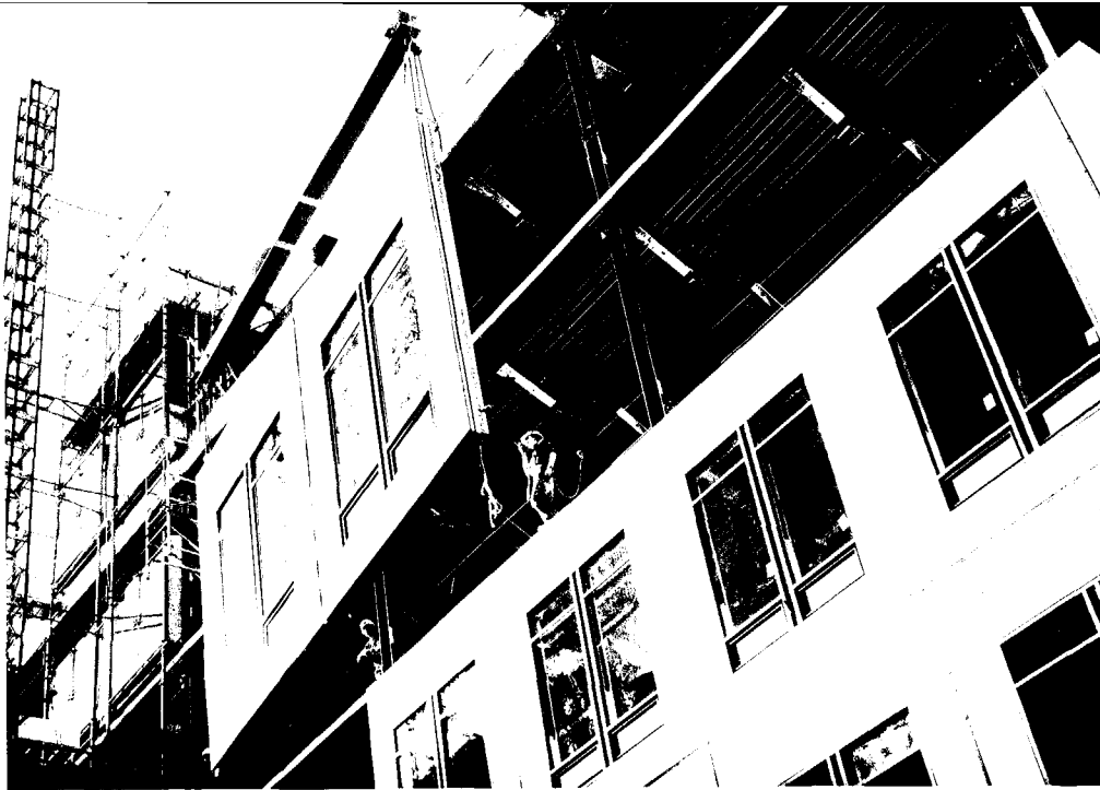
3.34 Montage van prefab-supercomponenten.
