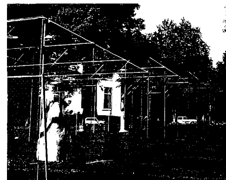
5.18 Glas absorbeert en reflecteert een gedeelte van het opvallende licht. Hierdoor ontstaat ook bij nagenoeg geheel glazen gebouwtjes schaduwvorming. Beeldenpaviljoen, Sonsbeek, 1986. architecten: Benthem Crouwel
