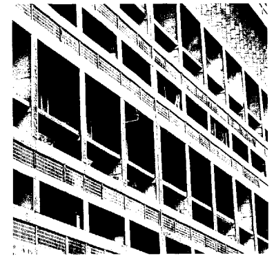
6.2 Woongebouw Unité d'Habitation, Marseille architect: Le Corbusier
