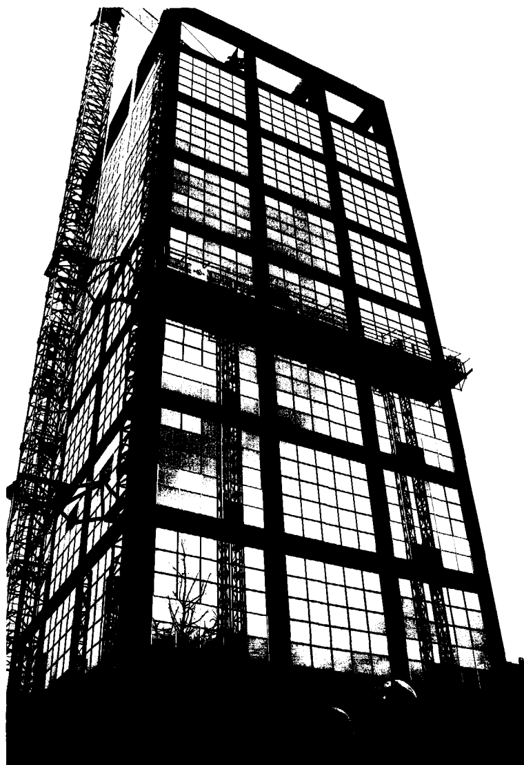
8.9 Kraan en hefsteiger voor verticaal transport en montage. project: Avéro kantoor te Leeuwarden architectenburo Bonnema te Hardegarijp
