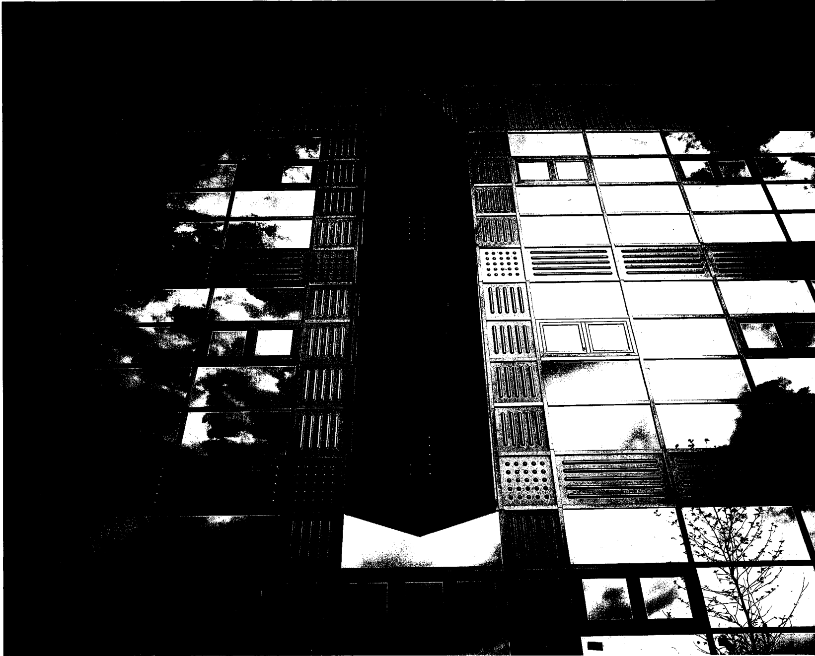
2.15 Plaatwerk door omvormen in vorm gebracht, Sport und Freizeit Immobilien AG, Walterswil (CH), 1988 architect: Ch. Derungs
