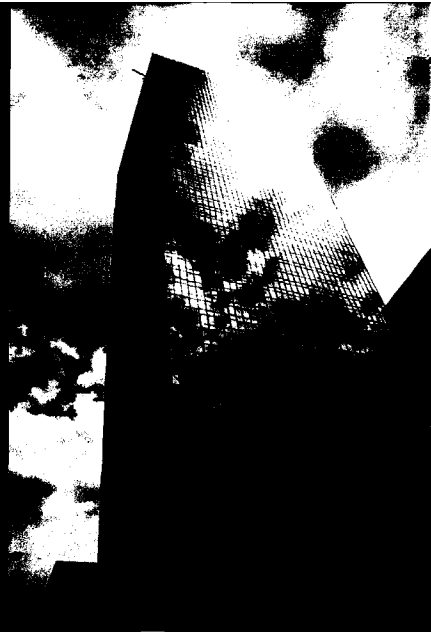
4.4.3 Hoogbouw gevelreiniging. Het gebruik van één type gevelmateriaal en vlakke profilering is gunstig voor het reinigingswerk.
