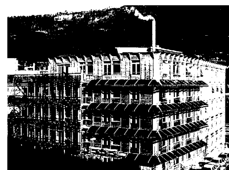
6.65 PV-modules geïntegreerd in een zonwering van een kantoorgebouw, Liestal (CH).
