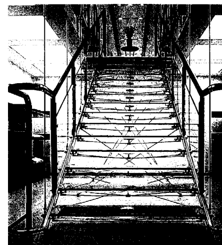
3.94 Glas als constructiemateriaal: 'glazen' trap. architect: E. Jiricna
