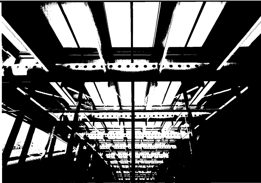
7.1.23 Glasdakconstructie met luchtverwarming.
