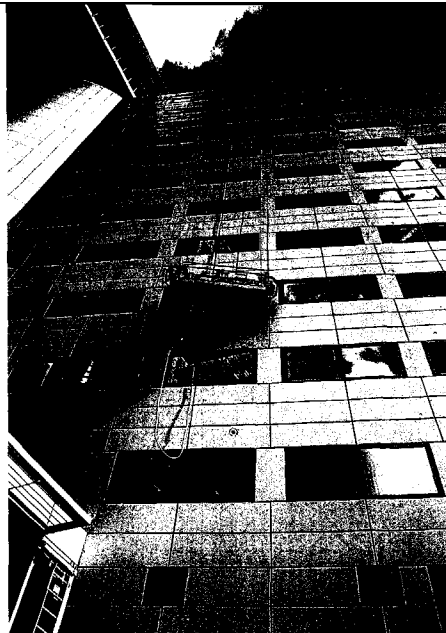
4.4.11 Voor hoge bouwwerken is kabelgeleiding noodzakelijk om het slingeren van gondels te voorkomen, Haagse Arc, Den Haag. architect: T+T Design
