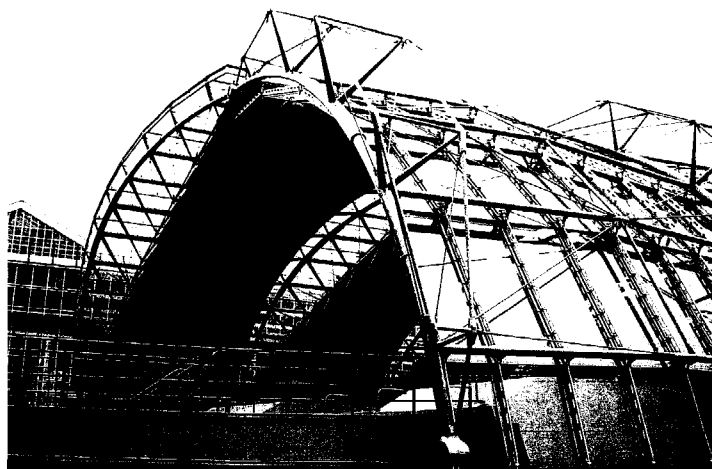
5.89 De stationsoverkapping is dakpansgewijs beglaasd. De afdichting tussen de 10 mm dikke geharde glasbladen wordt gewaarborgd door neopreen-profieltjes, Waterloo International Station, Londen, 1994. architect: Nicholas Grimshaw and Partners
