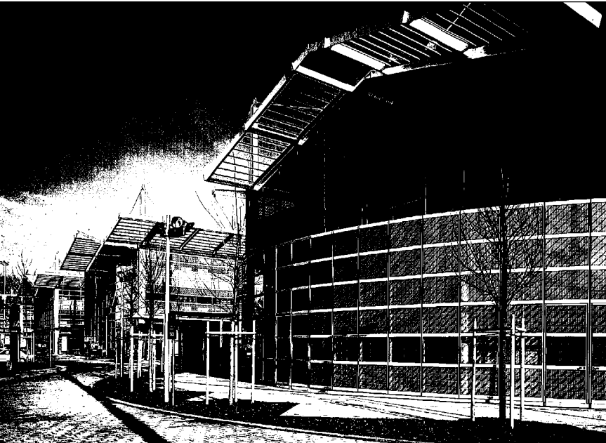
3.15 Zuivere alu-glasfaçade. Gebouw MOC München (D). architect: Murphy/Jahn Chicago
