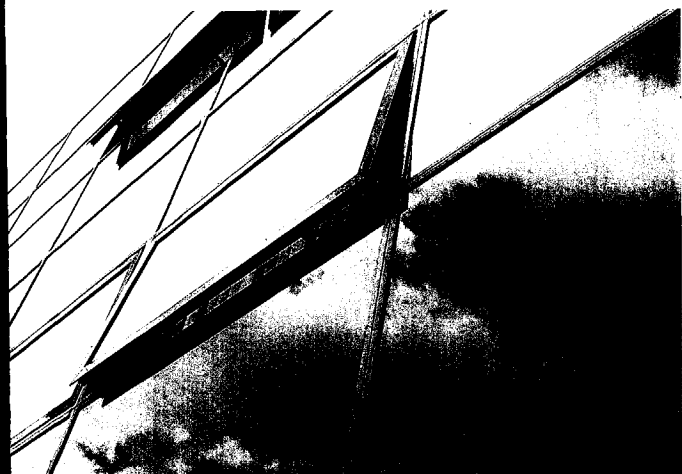
3.50 Rubbergasketsysteem met te openen ramen.
