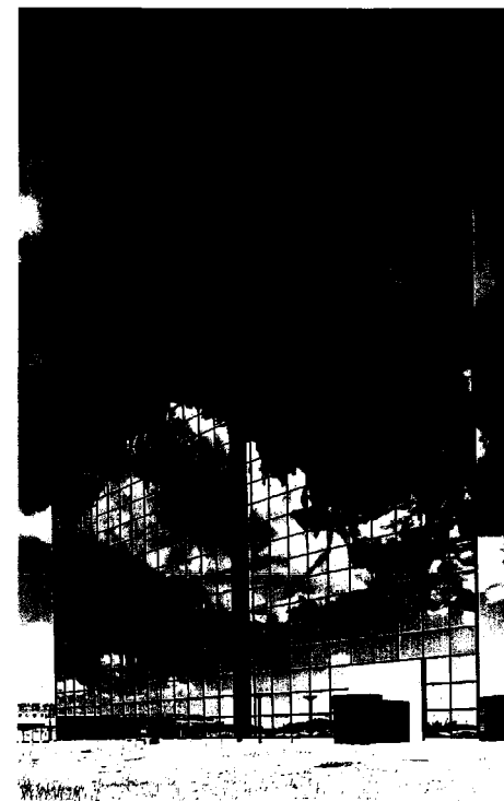
5.4 Reflecterende beglazing in de glasmafakade van het Centerpoint gebouw, Amsterdam. architecten: Witt en Van Well
