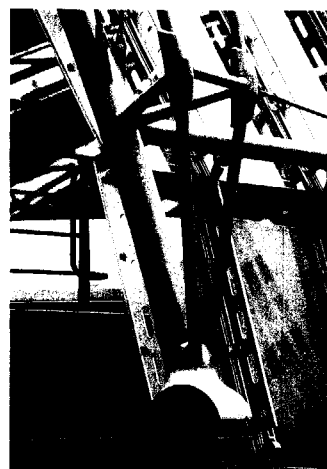
5.89 De stationsoverkapping is dakpansgewijs beglaasd. De afdichting tussen de 10 mm dikke geharde glasbladen wordt gewaarborgd door neopreen-profieltjes, Waterloo International Station, Londen, 1994. architect: Nicholas Grimshaw and Partners
