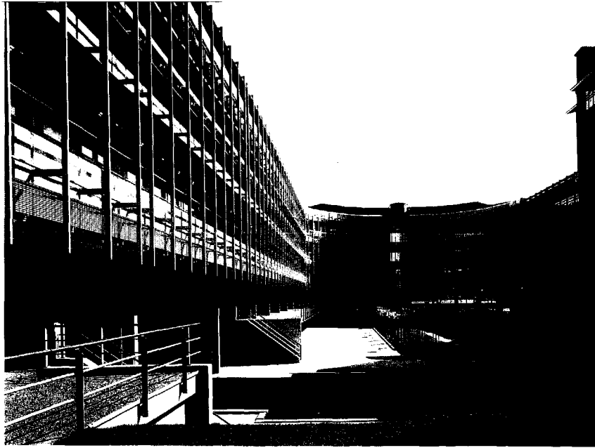
6.40 Kantoren ministerie van Verkeer en Waterstaat, Den Haag. architect: ir. K. v.d. Woeven, i.s.m. ir. K. Rosdorf
