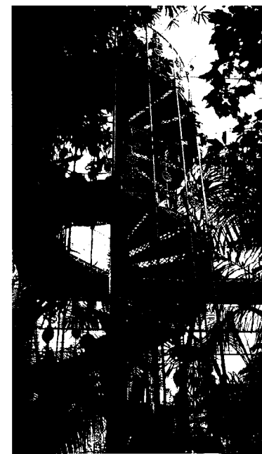
1.6 Gietijzeren spiltrap Palmhuis
