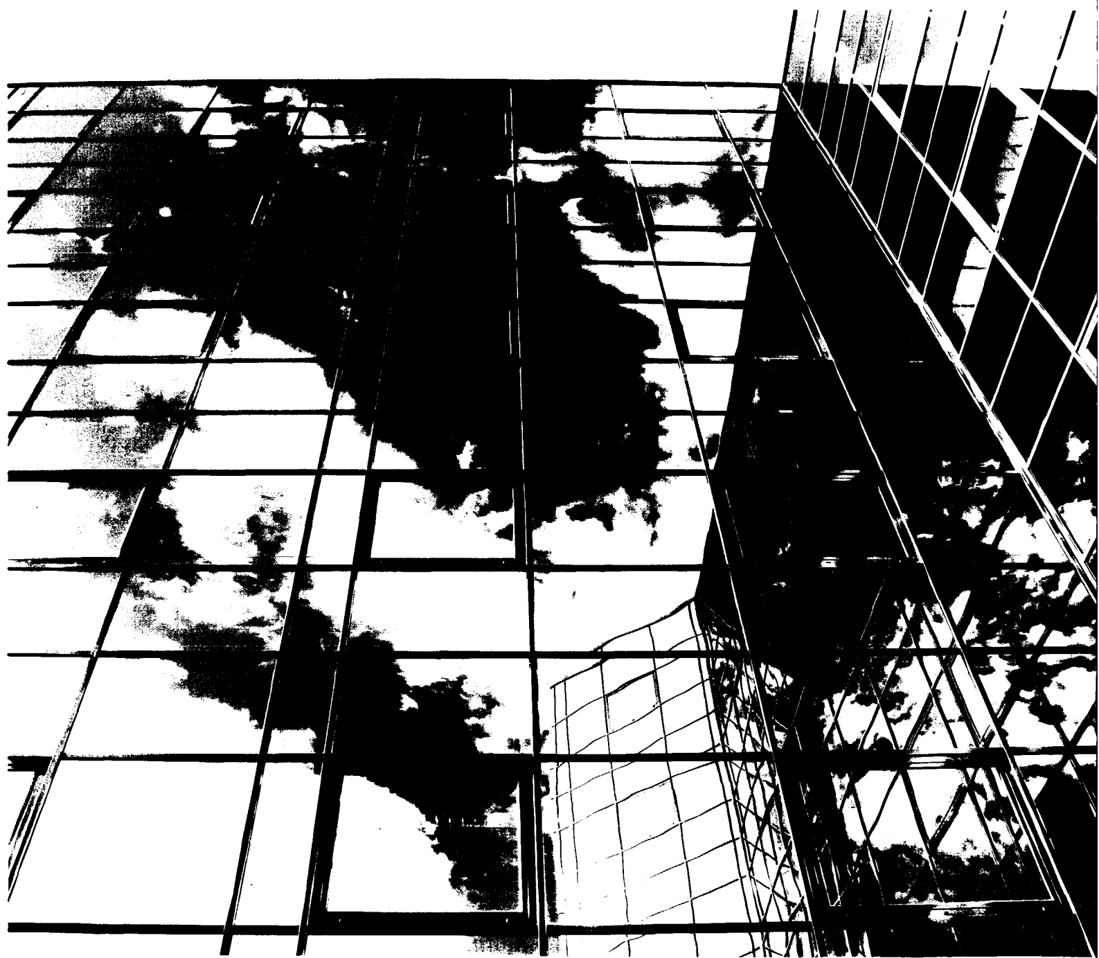
6.30 Kantoorgebouw KPMG, Rotterdam. architect: Schurink BNA
