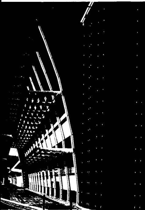
5.74 A+B Het naar voren laten hellen van het gevelvlak heeft een tweeledige functie: zon-beheersing en het beperken van de reflectie van radarstraling, Coördinatie-centrum British Airways, Heathrow, Londen, 1994. architect: Nicholas Grimshaw and Partners
