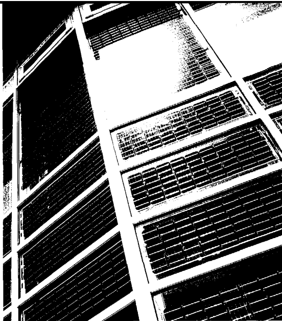
Fotovoltaïsche toepassing: de energiefaçade. project: Umweltzentrum, Cottbus (D) architect: Büro Wanta & Sommer, Cottbus
