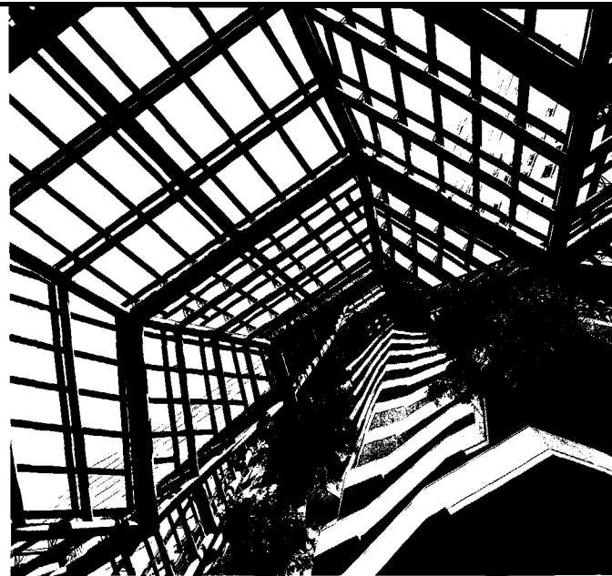
4.4.13 Binnenzijde 'gasvlam'glasfaçade kan met 'kunst en vliegwerk' gereinigd worden, Hoofdkantoor Gasunie, Groningen. architecten: Alberts en van Huut
