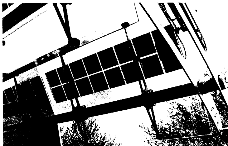
9.11 Multifunctioneel zonreguleringsysteem met geïntegreerde fotovoltaïsche cellen.
