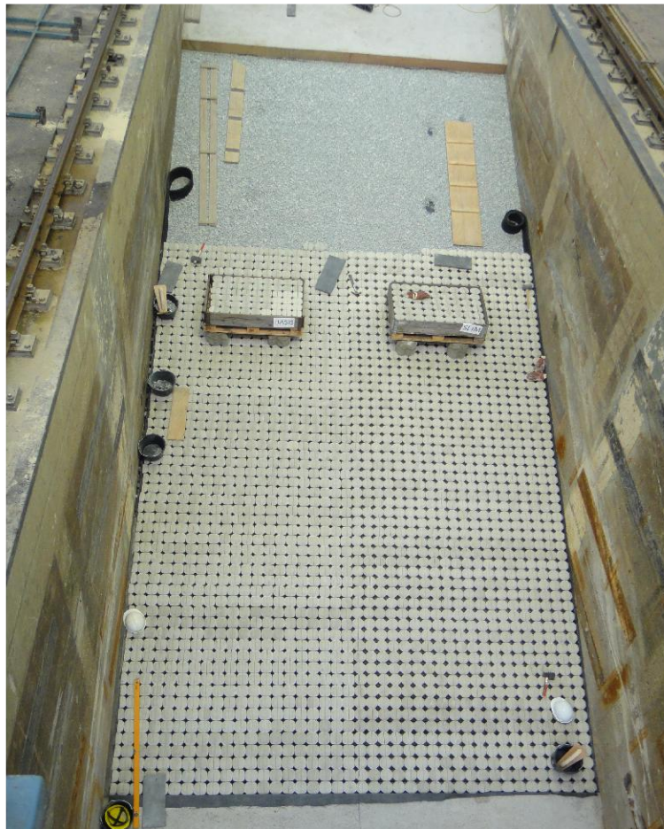
Aanbrengen Hillblock bekleding
