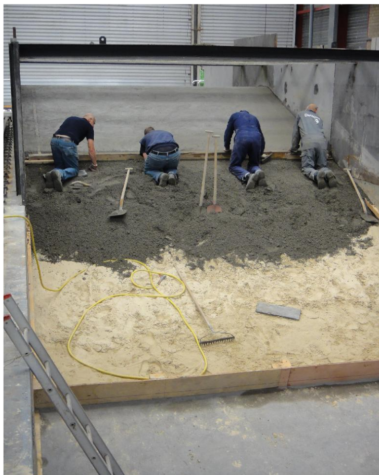
Verdichten zand en aanbrengen betonnen dummysecties
