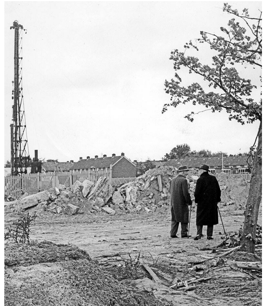
Fig. 2.31 – Sloop en bouwrijp maken voor het winkelcentrum Raadhuisplein nabij dorpscentrum, 1971 (bron: Drachten terug in de Tijd)
