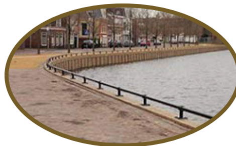
Gemetselde kademuur Doorrijbeveiliging stalen stang
