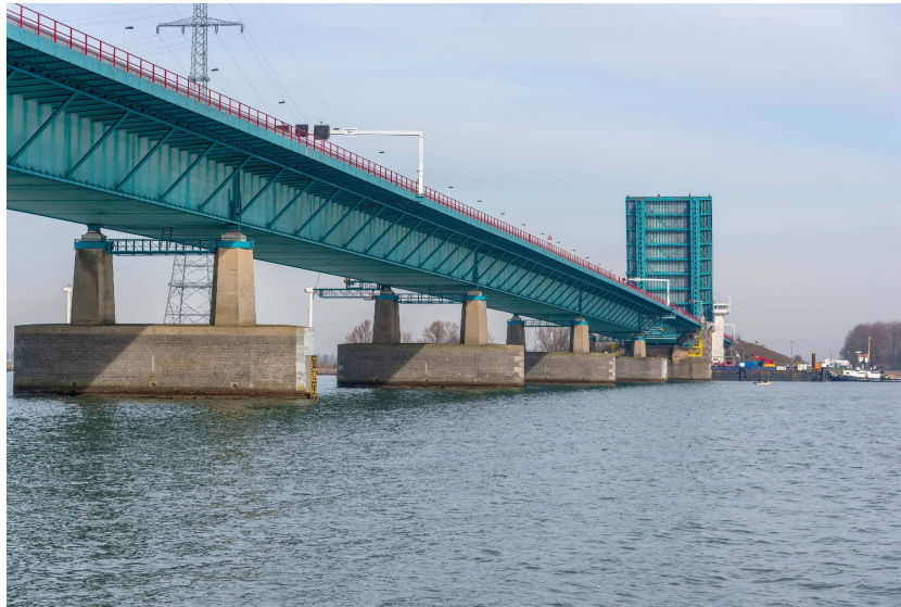
Figure 3.2: Exterior view of the Haringvlietbrug (source: Rijkswaterstaat).
