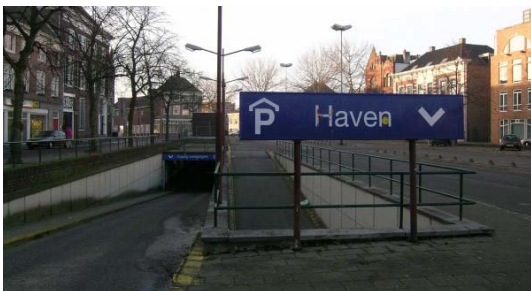
6 Uitgang parkeergarage (nieuwemark.com)
