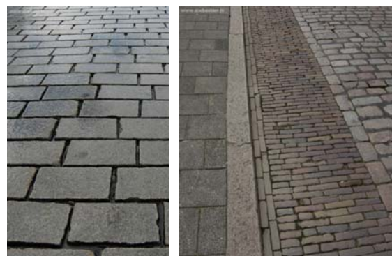
Figuur 6.9: bestrating. (doelbeelden.nl) De natuurstenen bestrating vanuit de binnenstad wordt doorgetrokken. Bij de fietspaden en rijbanen zorgt alternatieve bestrating voor overzichtelijkheid
