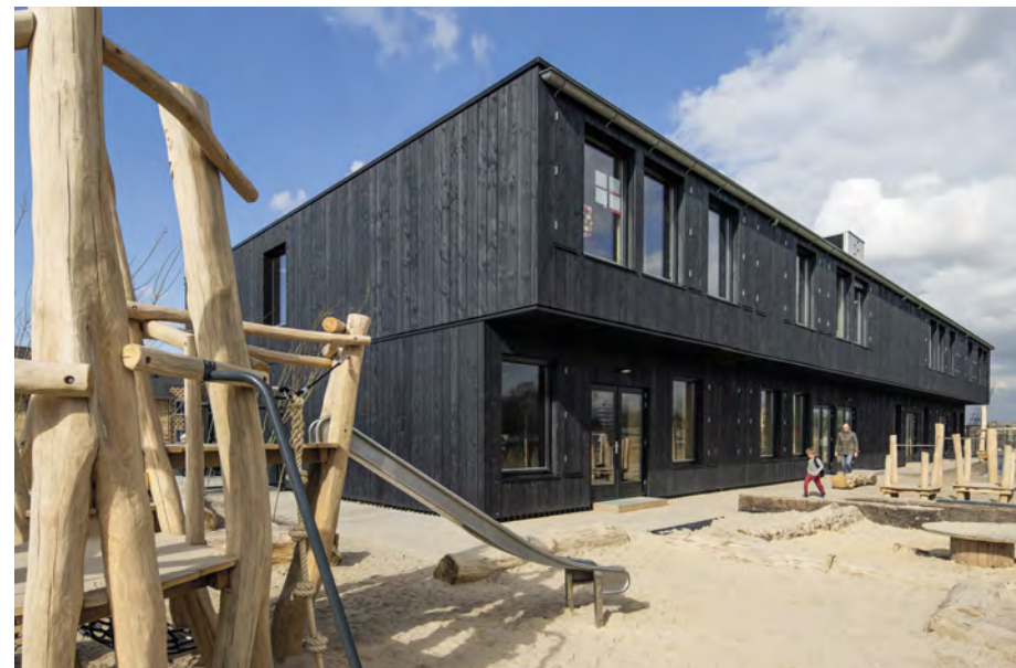
De tijdelijke school Nieuw Amsterdam (SeArch) bestaat uit CLT-modules die over vijf jaar worden gedemonteerd en op een nieuwe locatie opnieuw worden opgebouwd.
