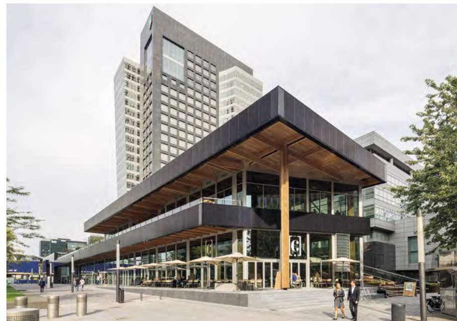
In het Circl paviljoen in Amsterdam (Architecten Cie.) zijn de glulam-balken demontabel en overgedimensioneerd, waardoor bij einde levensduur de balken met commerciële maten vrijkomen. De leverancier (Derix) heeft aangegeven de glulam-balken en CLT panelen terug te willen nemen.
