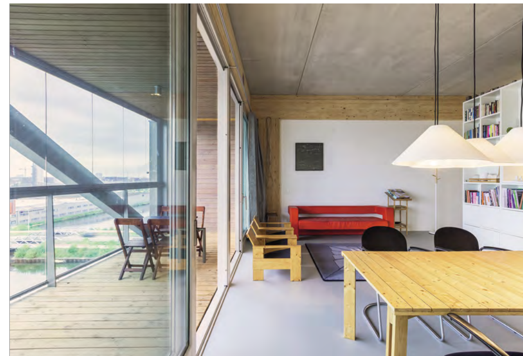
Combinatie van massiefhout en circulair prefab beton (demontabel) in het hybride gebouw Patch 22 in Amsterdam Noord (Frantzen et al).
