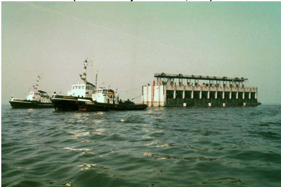
Figure 6.7 Transportation of the caissons using tugs (Beeldbank Rijkswaterstaat, 1983)
