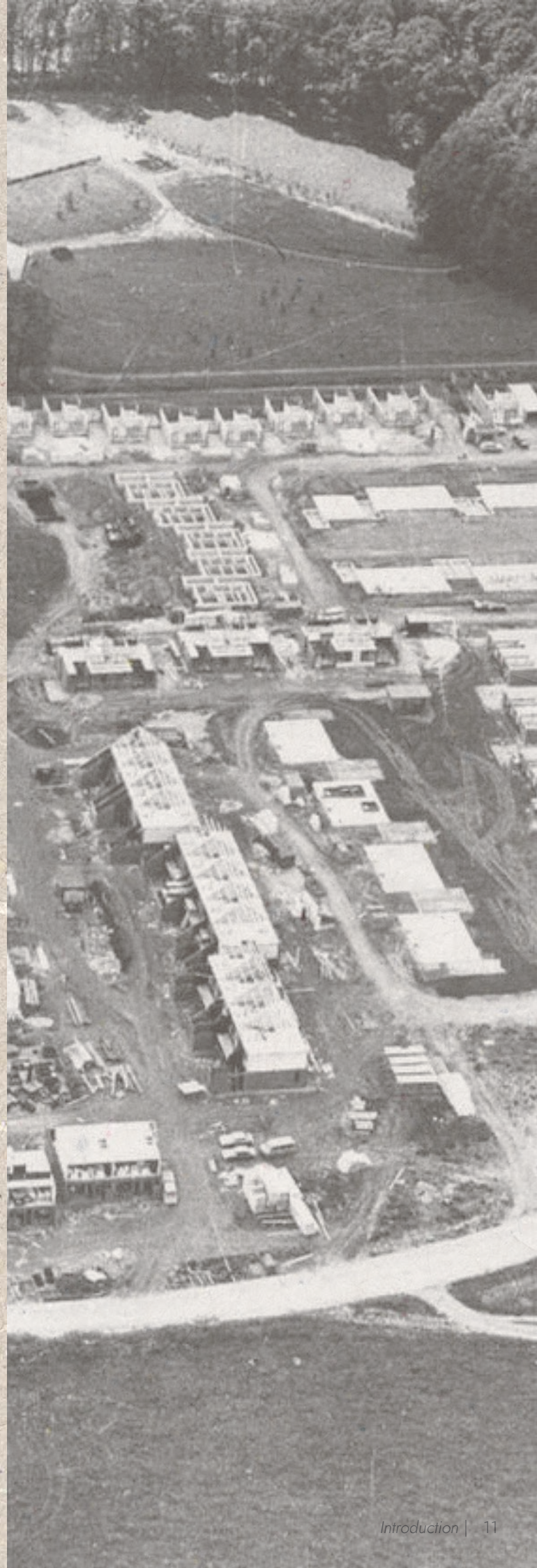
Fig. 1.1: The construction of a Bloemkoolwijk (Rijksdienst voor het Cultureel Erfgoed, n.d.)
