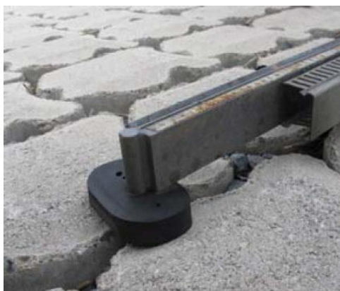
Figuur 2.5 Rubbervoet als steunpunt op het talud voor de gefoonbalk
