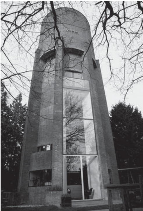
Watertower in Soest (Zecc Architecten, S.D.)
