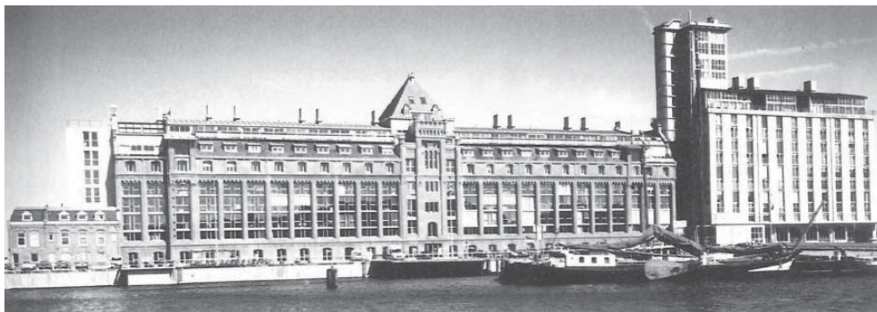
Graansilo's in Amsterdam (Kalk, 2010, p. 54), (Kalk, 2010, p. 59)
