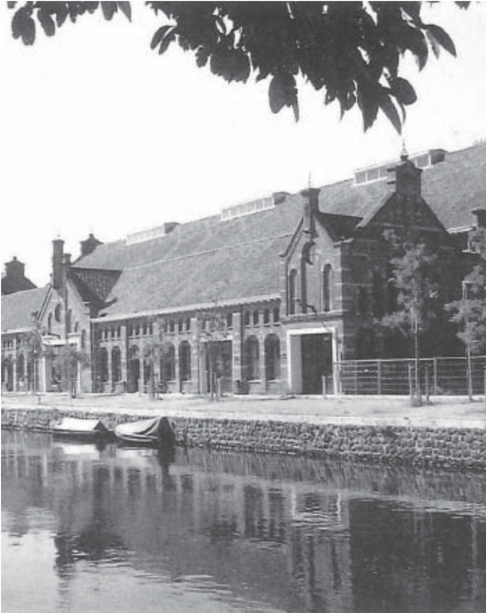
Westergasfabriek in Amsterdam (Kalk, 2010, p. 43)
