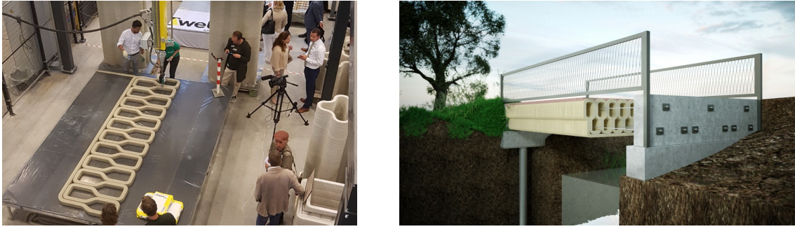
Figure 2.9: 3D printed concrete bridge in Gemert (verkeerinbeeld.nl 2017)
