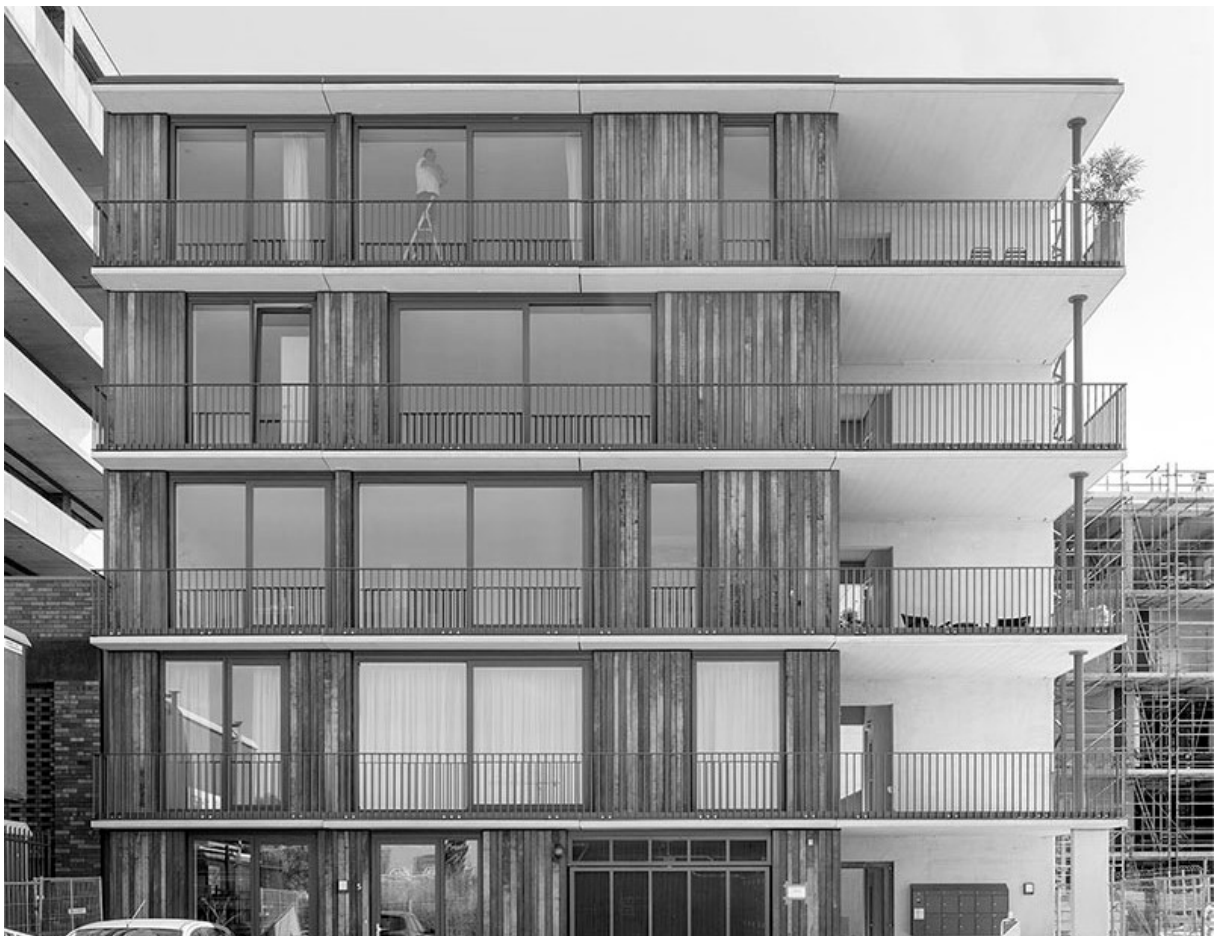
12 Photograph 2: CiWoCo Facade boterbloemstraat (Gaaga, 2019)
