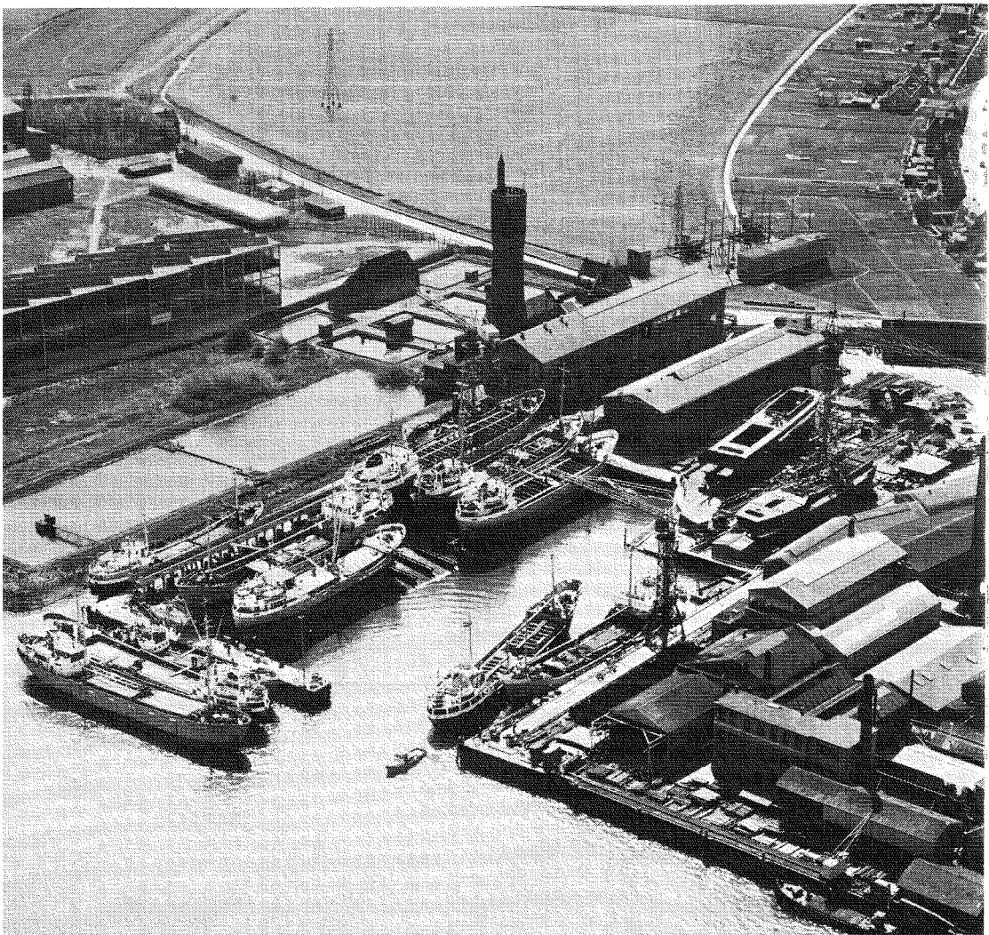
Scheepswerf met twee langshellingen voor nieuwbouw en een dwarshelling voor reparatie
