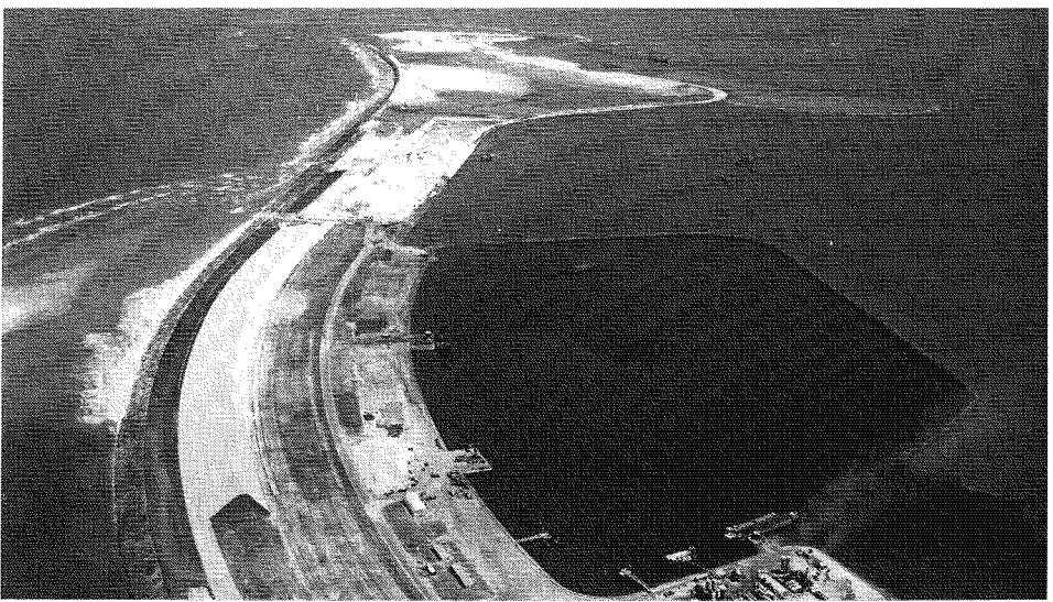
De damvakken in het Brouwershavensche Gat, gezien van zuid naar noord.
