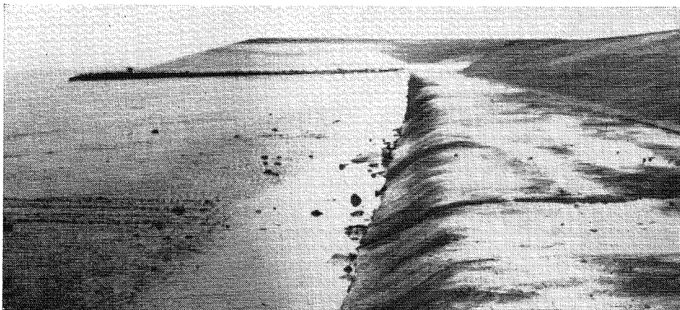
Kraagstuk van asfaltmastiek
