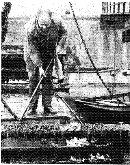
2. De weefsels van de onderwaterproef worden regelmatig schoongemaakt
