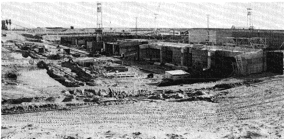
De uitwateringssluizen in aanbouw op het werkeiland voor de afsluiting van de Lauwerszee
