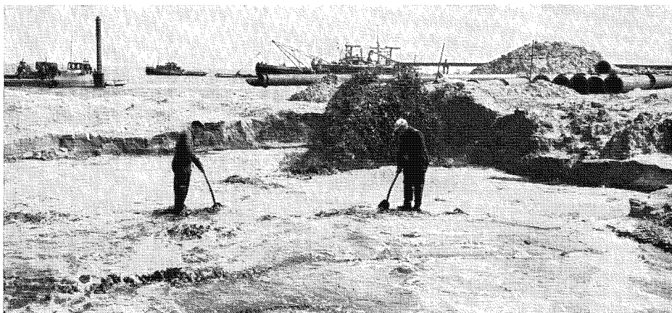
De bouw van een 800 m lang dijkvak ten westen van het werkeiland in de Lauwerszee is dit werkseizoen ter hand genomen.
