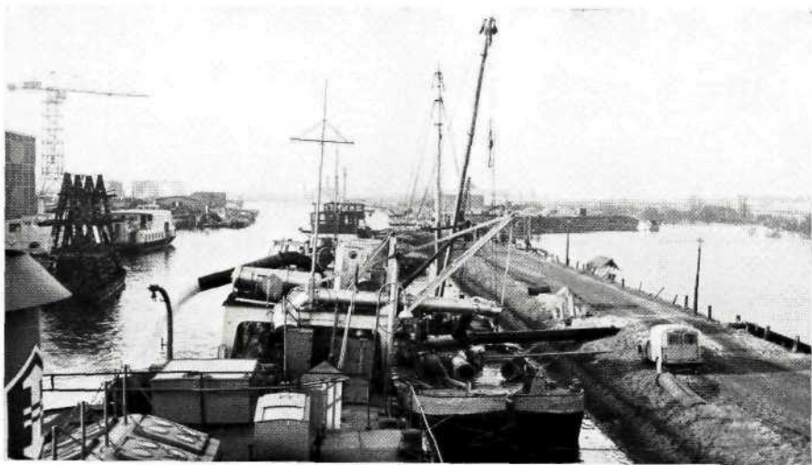
8. Het leegpompen van het overstroomde tuindorp door in het Cornelis Douweskanaal liggende pompen
