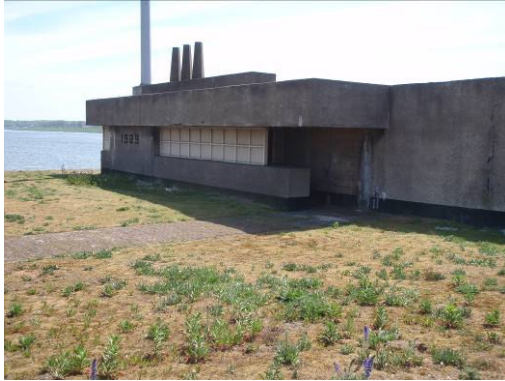
Fotonr. 65: gebouw binnensluishoofd noord
