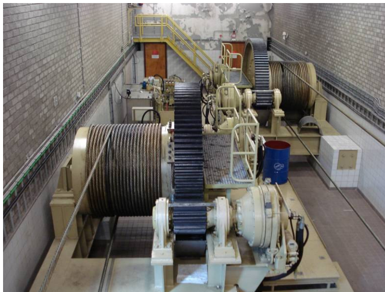
Fotonr. 3: Aandrijving- en bewegingswerk, roldeur
