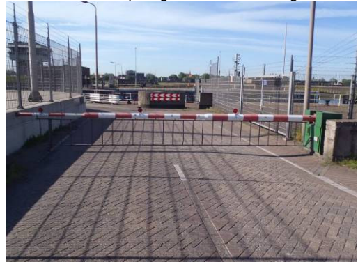
Fotonr. 36: ontbrekende reflecterende stroken
