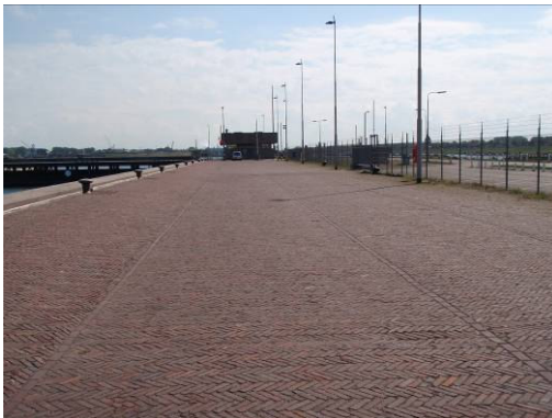
Fotonr. 181: spoorvorming verharding
