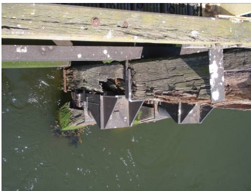
Fotonr. 137: insnoering en houtrot remmingwerk
