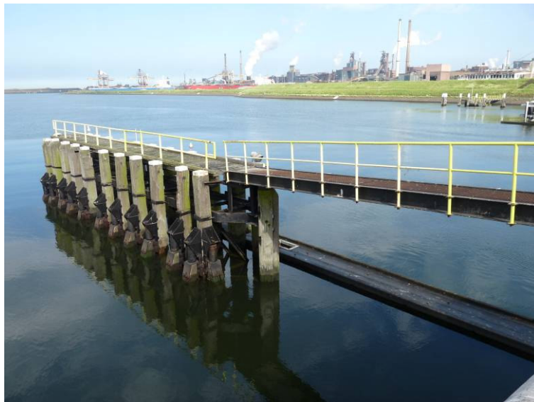
Fotonr. 136: Houten remming en geleidewerk
