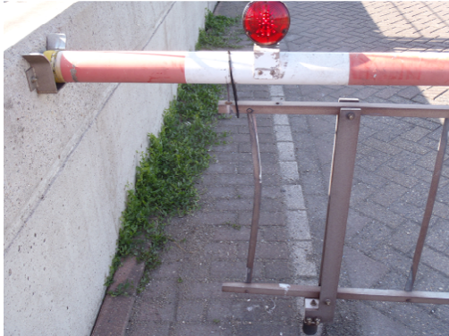
Fotonr. 39: rok provisorisch bevestigd -1-N/W zijde
