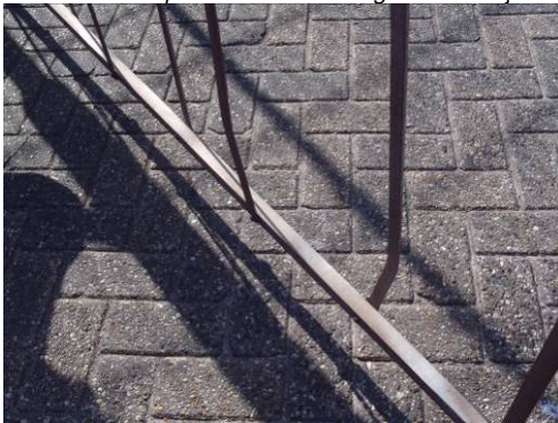
Fotonr. 41: rok vervormd – NW-zijde
