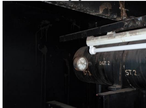
Fotonr. 146: glas voor meter is stuk
