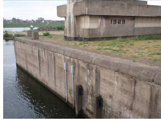
Fotonr. 66: gebouw binnensluishoofd zuid
