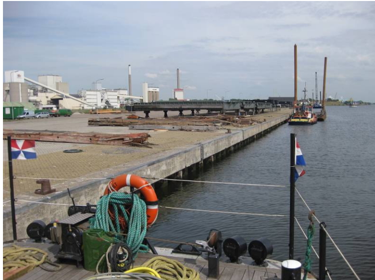
Fotonr. 108: Kerende constructie
