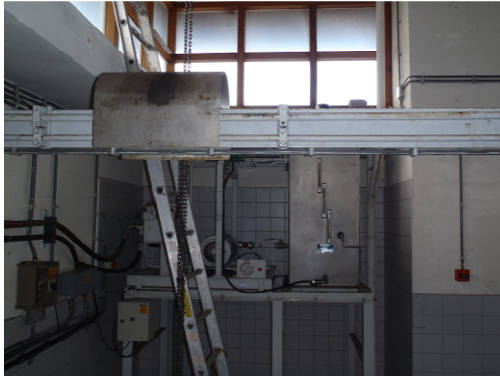
Fotonr. 19: ontbrekende bout bij support - overzicht
