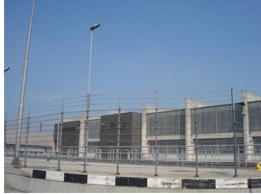
Fotonr. 72: loods ten behoeve van onderhoud roldeur buitenhoofd oost
