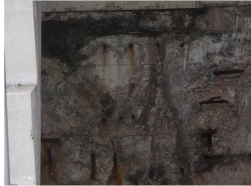
Fotonr. 159: beugel t.b.v. ladder kolkwand
