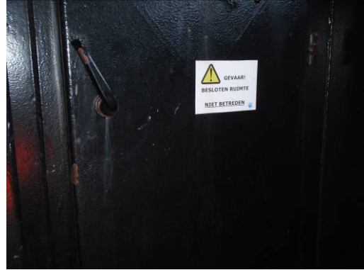
Fotonr. 144: deur is niet gangbaar
