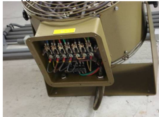
Fotonr. 190: Ontbrekend deksel.
