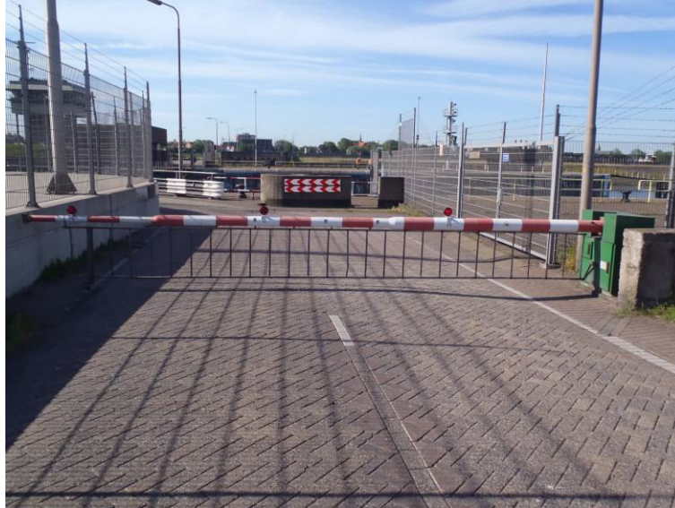
Fotonr. 32: Afsluitboominstallatie
