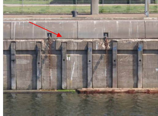
Fotonr. 170: uitstekende beton
