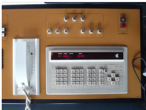
Fotonr. 63: bedieningspaneel CCTV
