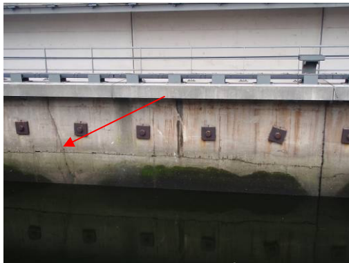
Fotonr. 154: scheur in beton
