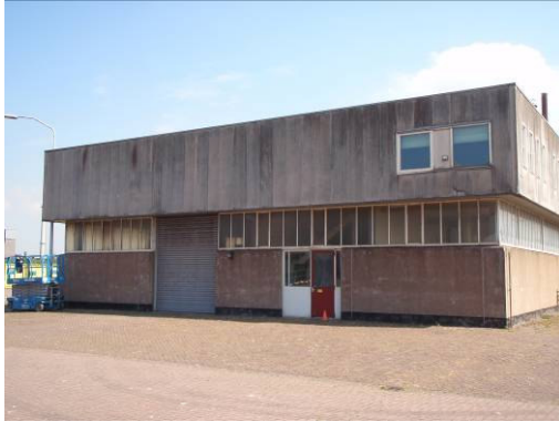
Fotonr. 83: Gebouw buiten gebruik (asbest)
