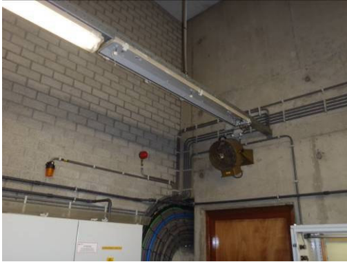
Fotonr. 53: Verwijderd binnenwerk
