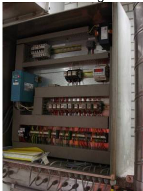
Fotonr. 189: Een insteekrelais verwijderd
