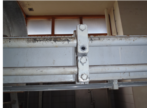
Fotonr. 20: ontbrekende bout bij support - detail
