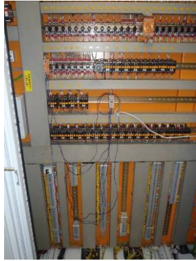
Fotonr. 46: Uitbreiding provisorisch aangebracht
