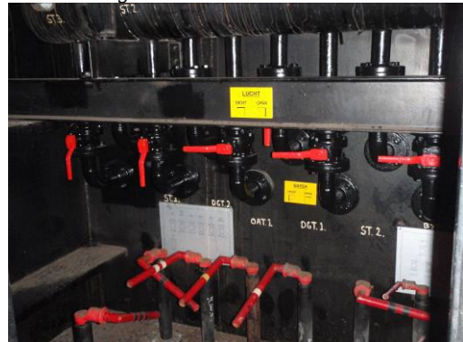
Fotonr. 148: kleppen staan gedeeltelijk open en gedeeltelijk dicht
