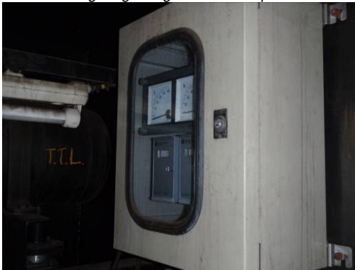
Fotonr. 145: glas voor meter is stuk
