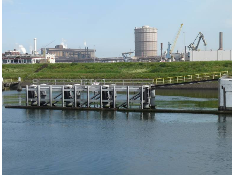
Fotonr. 135: Stalen remming- en geleidewerk
