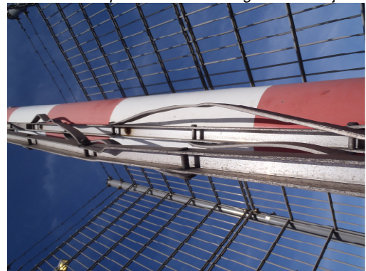
Fotonr. 42: rok vervormd – Z/O(W zijde)
