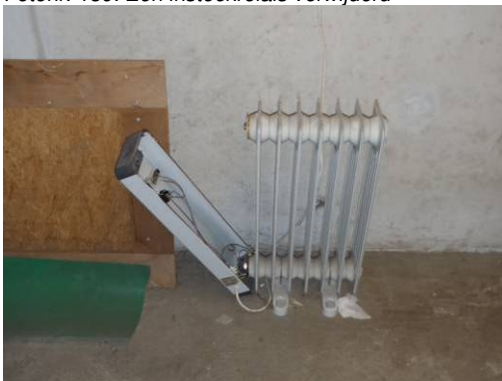
Fotonr. 191: Losse bediening, kachel brand wel
