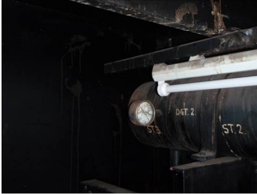
Fotonr. 149: verlichting werkt niet
