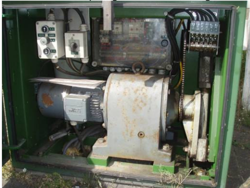
Fotonr. 35: lichte speling onderste krukaslager – Z/W
