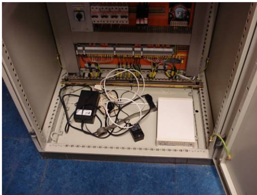
Fotonr. 94: losse niet gebruikte apparatuur
