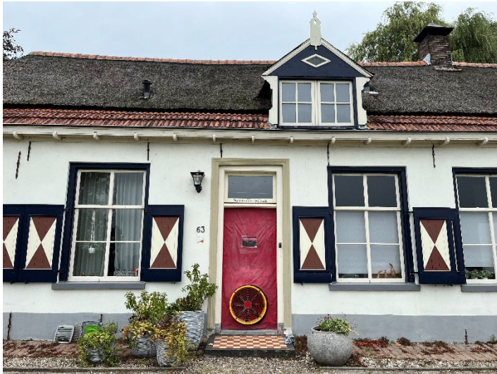
Figuur 5: Meetopstelling blower door in deurkozijn.
