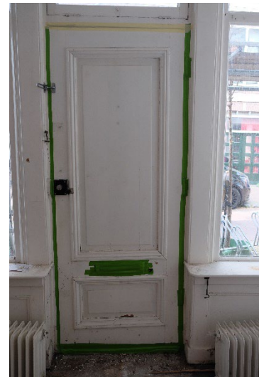
Figuur 8: Afplakken luchtlekken rondom buitendeur en brievenbus.
