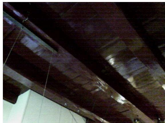
Figuur 23: Luchtlekken door kieren tussen de planken van de verdiepingsvloer.
