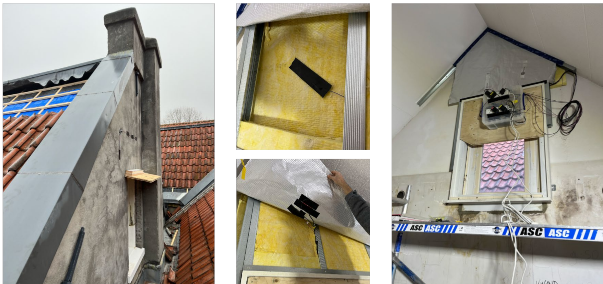
Figuur 7: Tijdens de renovatiefase werden temperatuur- en RV-sensoren ingebouwd op verschillende posities in de wand om het hygrothermisch gedrag van de nageïsoleerde wanden op te volgen.
