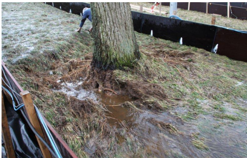
Figuur 3.8 Boom op binnentalud (matige invloed)
