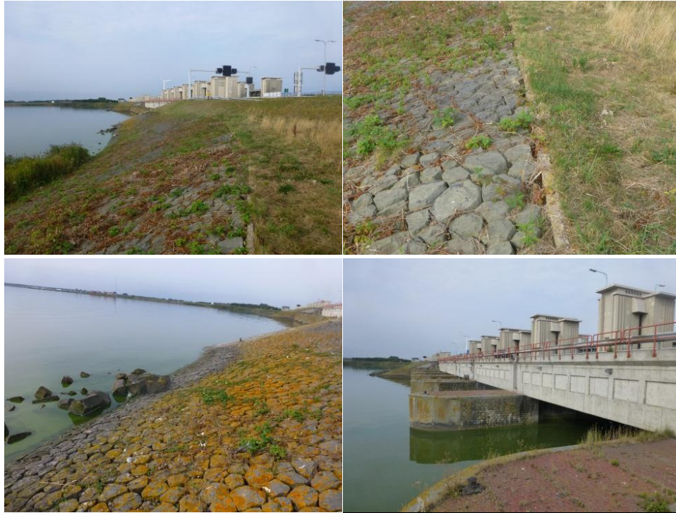
Figure C- 2. Afsluitdijk inner slope and Stevin Sluizen
