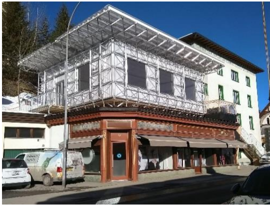
Figure 5.8. The exterior of the ICEhouse in Davos (Hakvoort, 2019).
