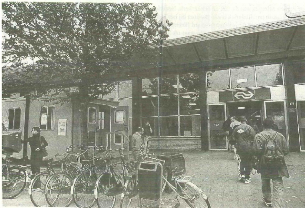
De noordzijde van het station krijgt een volwaardige entree.
