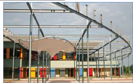
Figuur 22. Stalen constructie.
