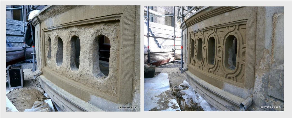
Fig. 3: Mortelrestauratie van een balkon (Kneuterdijk, Den Haag).
