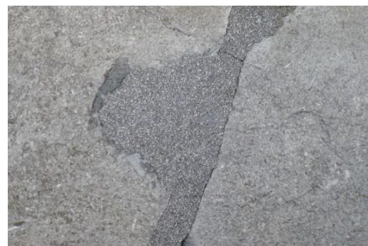
Fig. 16: Voorgevel van de Sint-Nicolaaskerk in Amsterdam met mortelreparaties
