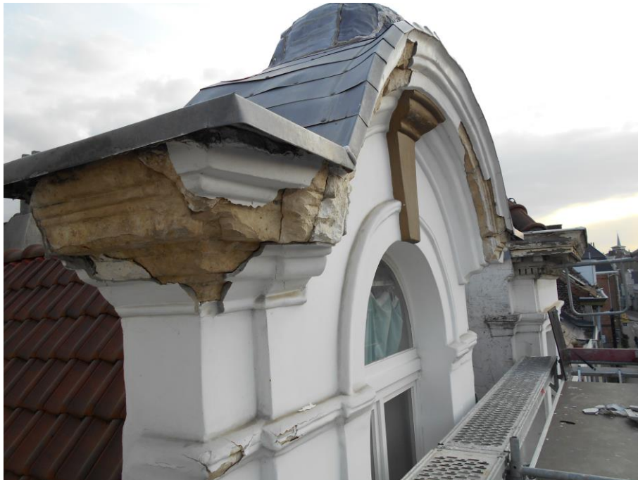
Fig. 1: Steenherstel van Avesnessteen door overpleistering met cementmortel. Loskomen van de mortel en verwerking van de steen achter de mortel
