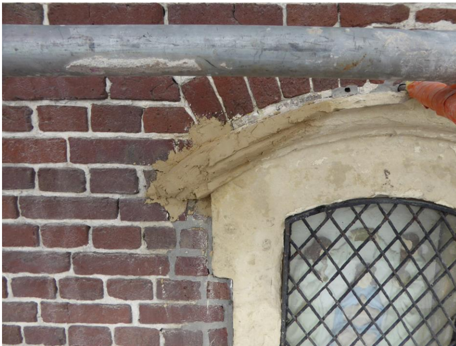
Fig. 12: Lacune tijdens het aanzetten van de mortel
