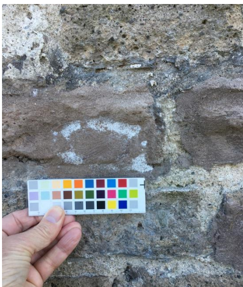
Fig. 2: Toepassing van steenreparatiemortel op tufsteen: kleur en textuur wijken duidelijk af van de ondergrond
