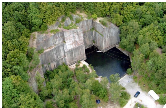
Fig. 5: Luchtfoto van de groeve Beauchâteau (Senzeilles, 2004) © Pierres et Marbres de Wallonie
