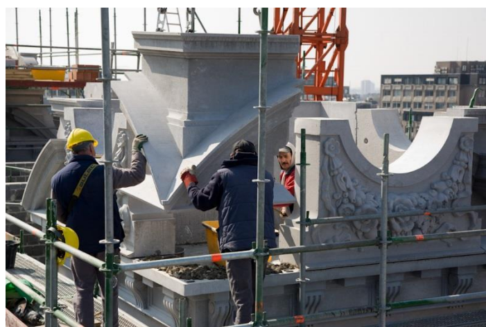
Fig. 2: Centraal station Antwerpen: montage van de elementen in kunststeen 14
