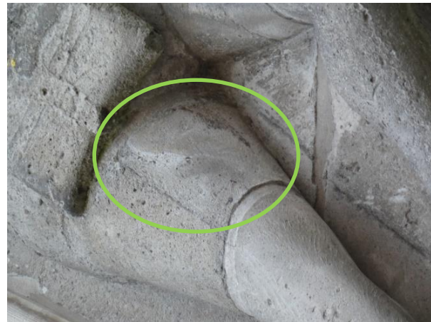
Fig. 8: Reparaties van authentiek tufsteen reliëfblok t.b.v. IBACH Voltränkung procedé
