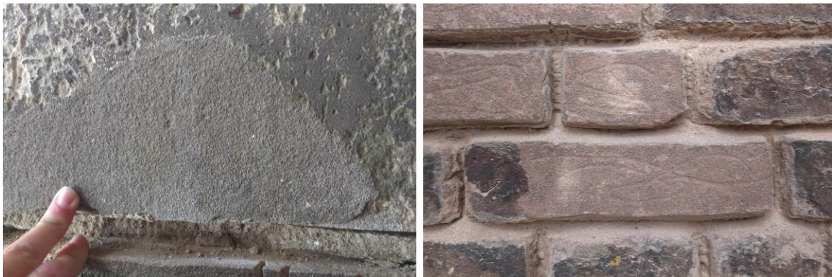
Fig. 1: Steenreparatiemortels aangebracht op natuursteen en baksteen (Oude Kerk te Delft)
