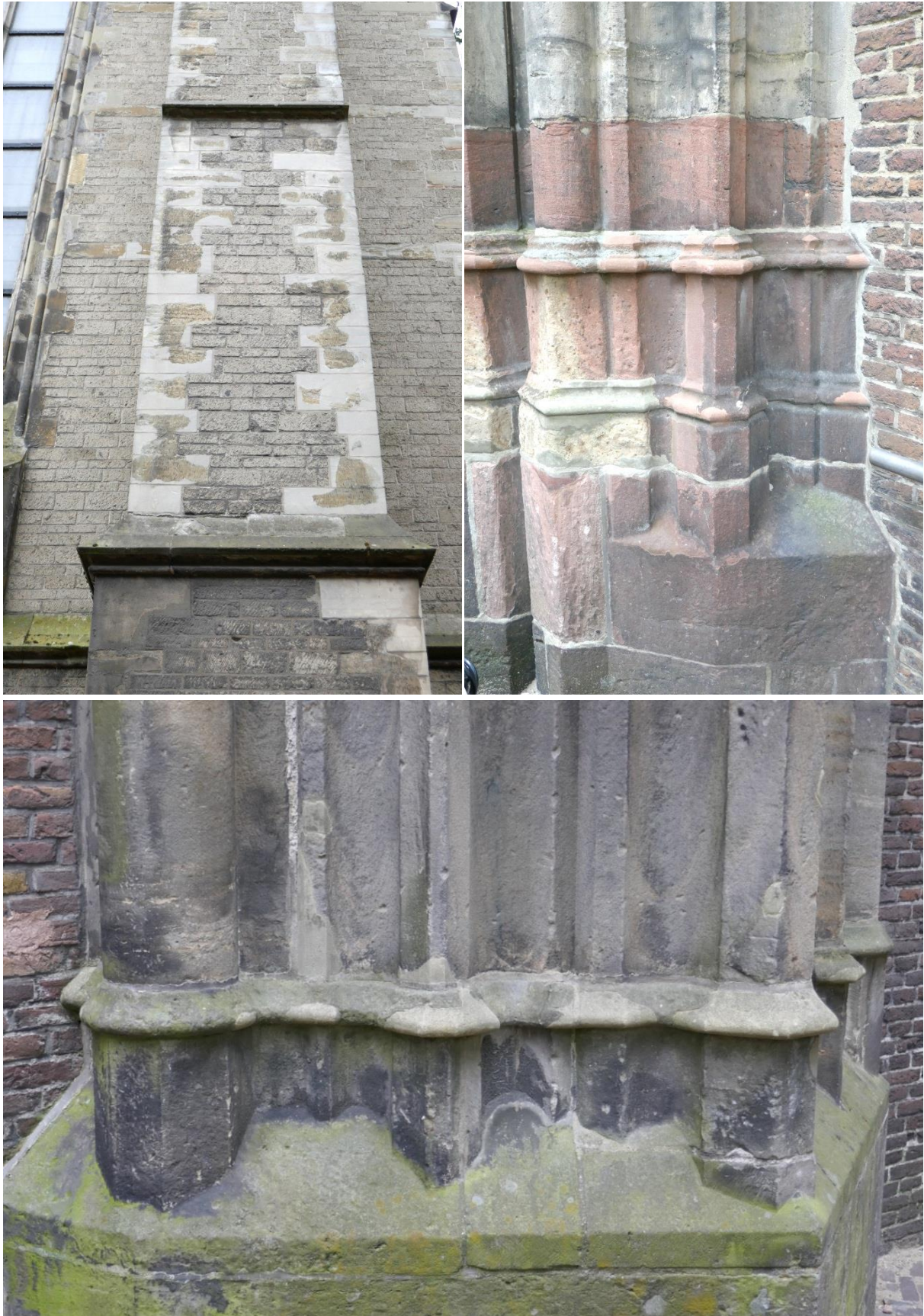
Basement van rode zandsteen en hoekblokken van ledesteen hersteld met reparatiemortel
