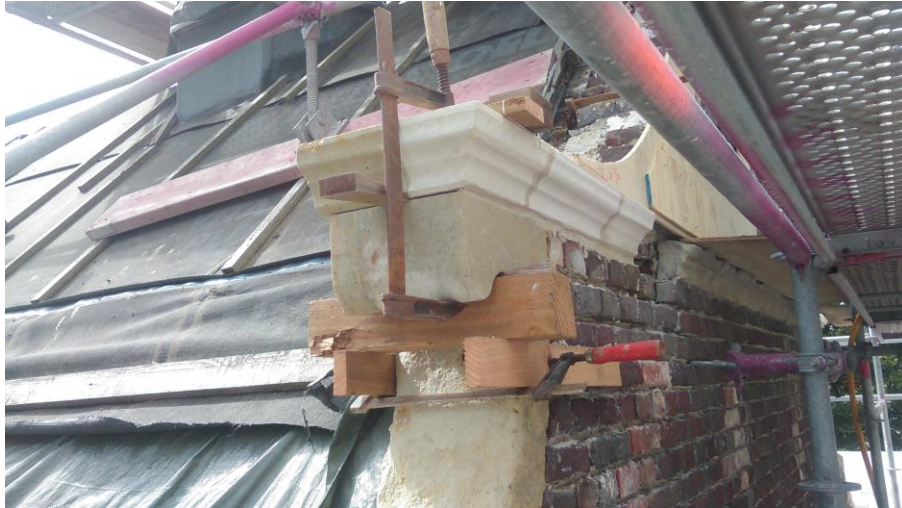
Fig. 6: Steenvervanging van de bovenste waterlijst met gerecupereerde Ledesteen
