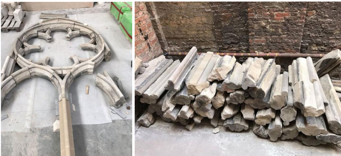
Fig. 4: Sint-Antonius-a-Paduakerk te Antwerpen: Testen op de natuursteen / uitgenomen monelen en negblokken die niet herbruikt kunnen worden. Delen die wel herbruikt konden worden, werden gesorteerd en terug geplaatst © Steenmeijer Architecten BVBA
