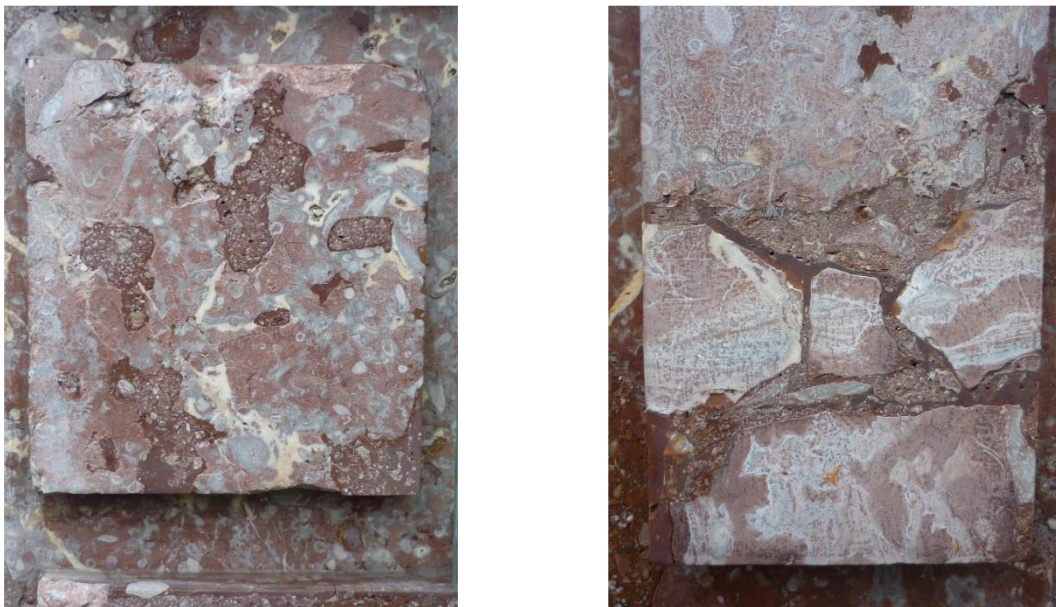
Fig. 3: Links: Kunsthars met marmerfragmenten toegepast als herstelmortel Rechts: Grotere fragmenten marmer in kunsthars
