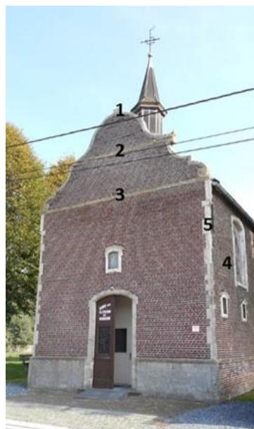
Fig. 2: Voorgevel van de kapel voor restauratie met aanduiding van de te restaureren elementen: opgevel (1), de bovenste waterlijst (2), de onderste waterlijst (3) de raamomlijstingen en de 15 statiekapelletjes (4) en de hoekblokken (5)
