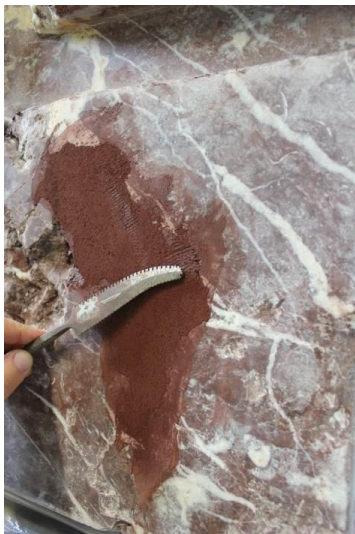
Fig. 9: Afschrappen van de lederharde mortel met behulp van een getande spatel
