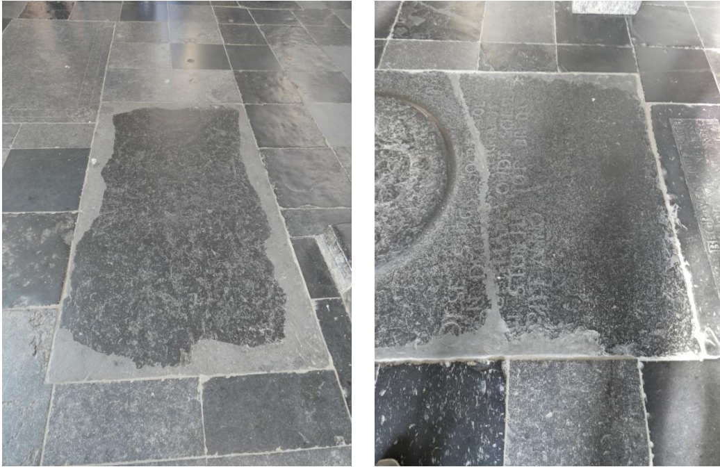
Fig. 15 en 16: Reparatie van zerken van Doornikse steen De randen van de steen schilferen af waardoor de verwerking van de stenen sneller toeneemt
