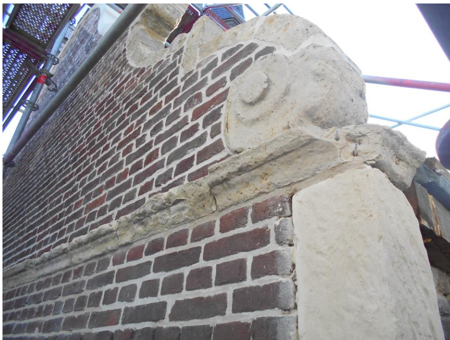
Fig. 7: Onderste waterlijst voor restauratiebehandeling
