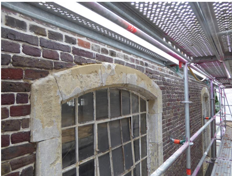
Fig. 10: Raamomlijsting na aanvulling met kalkmortel. De mortel is nog niet uitgedroogd waardoor de kleur nog te donker is
