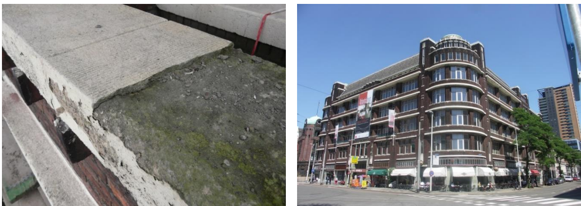
'Borstweringen' die over de volledige breedte zijn afgewerkt met mortel.
