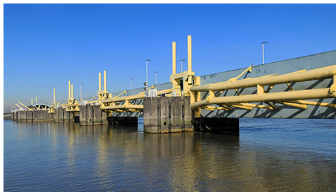
(c) Emssperrwerk, DE (ref: Frank Vincentz)
