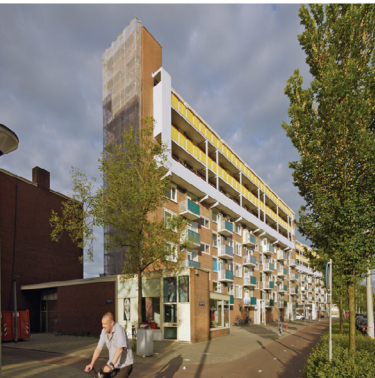
Knijptijzerpanden renovation Source: https://www.bna.nl/project/renovatie-knijptijzerpanden/
