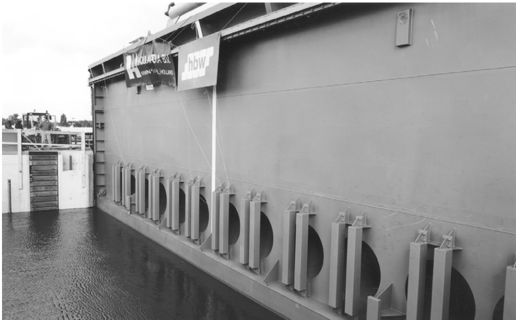
Foto 6.13 Breekbalken achter de ronde openingen van de glijdeur van Nieuwe Oranjesluis te Amsterdam
