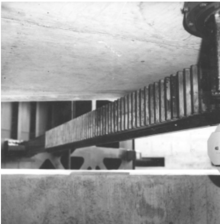
Foto 7.16 Rechte heugelstang voor deurbeweging van Koopvaardersschutsluis te Den Helder
