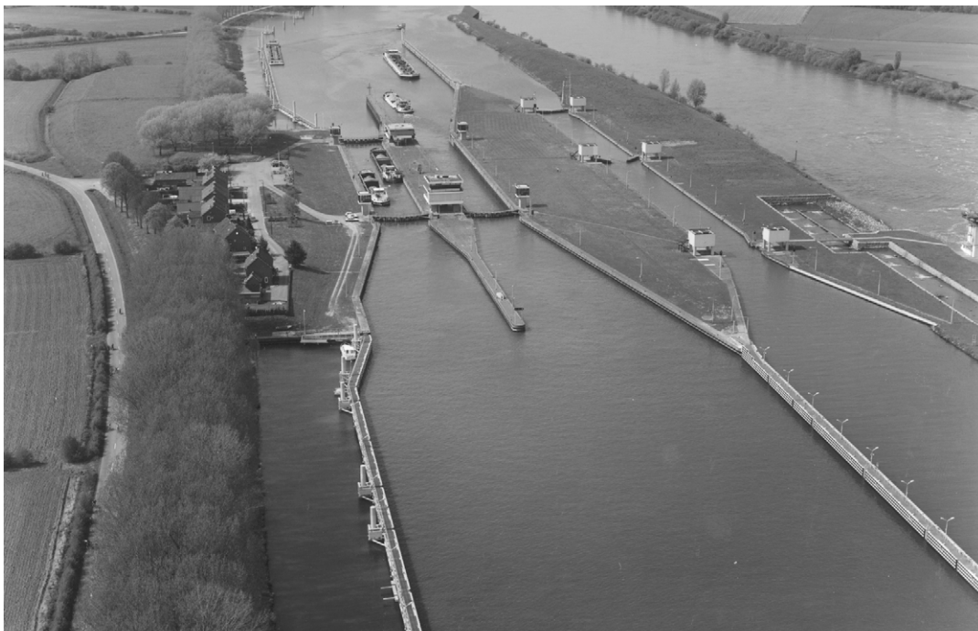
Foto 15.3 Sluiscomplex te Sambeek aan de Maas met dichte fuiken en open remmingwerken
