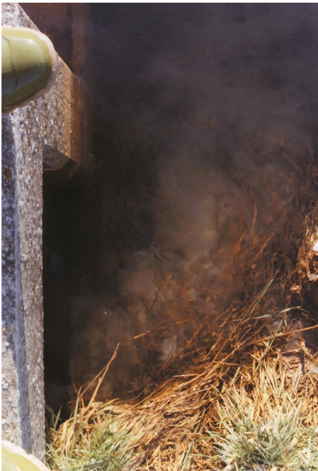
Foto 10.1 Zandmeevoerende wel bij de aansluiting van het achterloopsheidscherm van een sluis aan de benedenstroomse zijde. De keermiddelen bevinden zich in gesloten stand.
