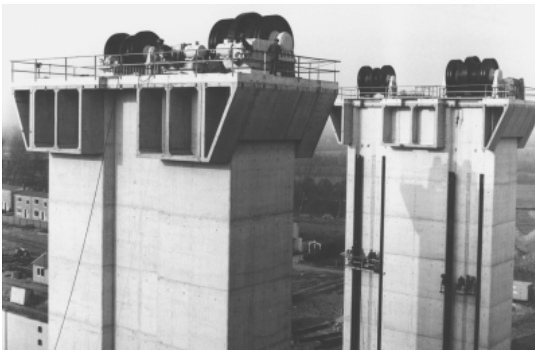
Foto 7.31 Bewegingswerk van hefdeur van nieuwe sluis te Wijk bij Duurstede
