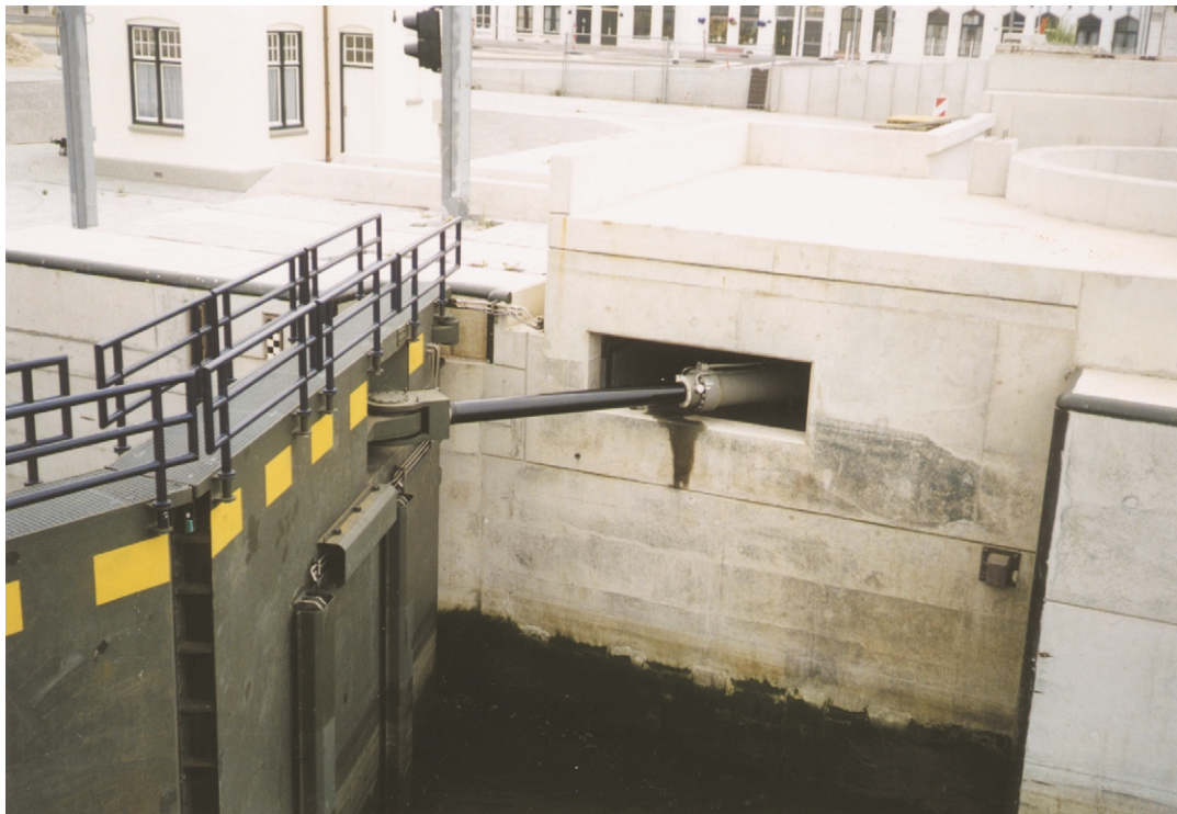
Foto 23.11 Deurbewegingswerk Kleine Sluis
