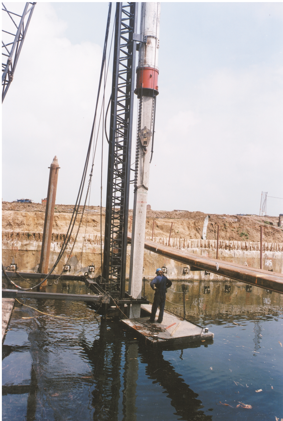
Foto 13.1 Heien van trekpalen voor onderwaterbetonvloer van Tweede sluis te Lith. Op achtergrond de met groutankers verankerde diepwand als kolkwand.
