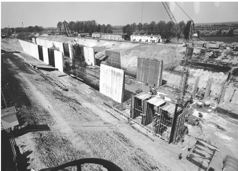
Foto 13.3 Open bouwput voor bouw sluis Wijk bij Duurstede
