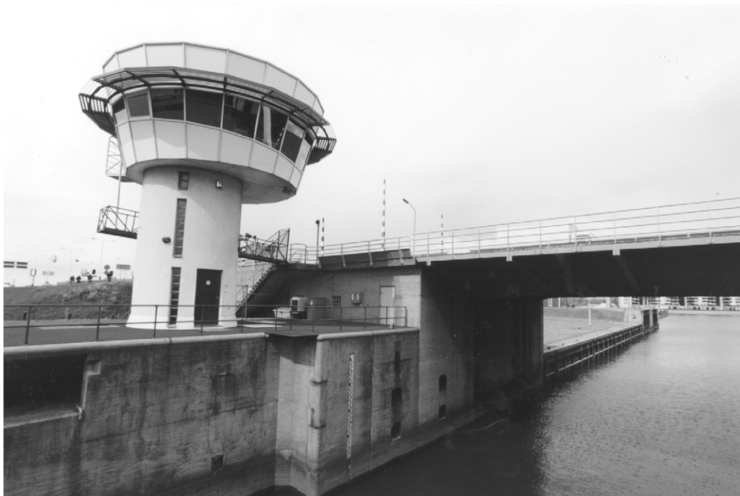
Foto 17.9 Bedieningsgebouw van schutsluis Krimpen a/d IJssel naast stormvloedkering
