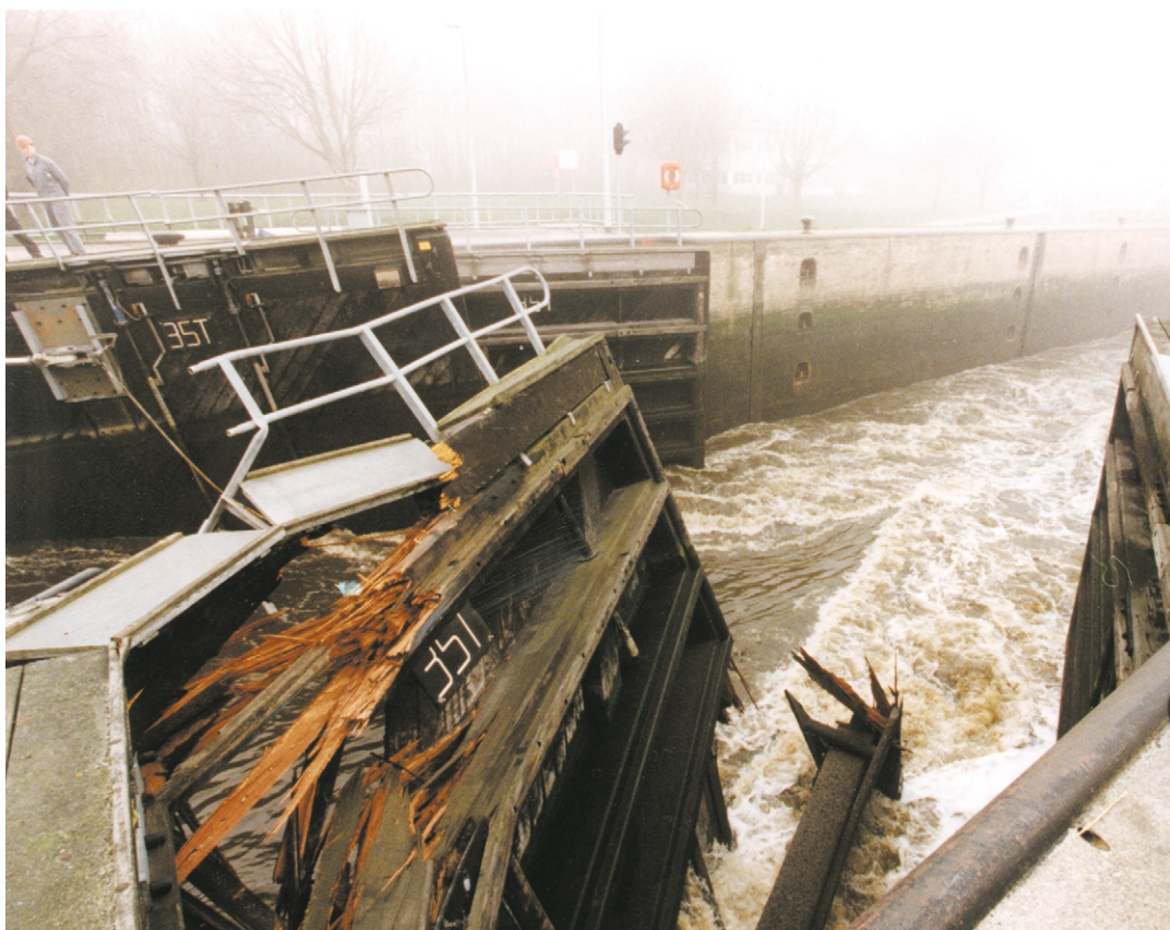
Foto 11.1 Om het leegstromen van het Eemskanaal te stoppen werd geprobeerd de ebdeuren van de zeesluis te Farnsum te sluiten. Ze sloten echter niet precies gelijk, hielden het water niet en braken uit hun ophanging (zie Appendix 11.2)
