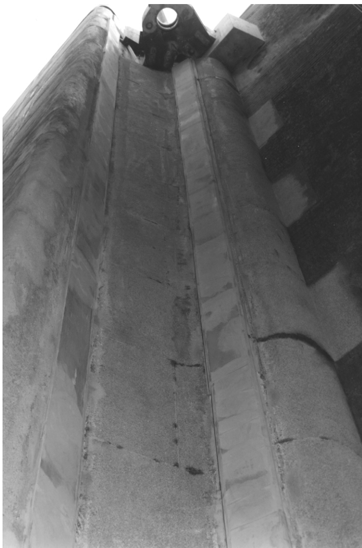
Foto 20.22 Nieuwe verticale aanslagvlakken van kunstharsmortel, Middensluis te IJmuiden
