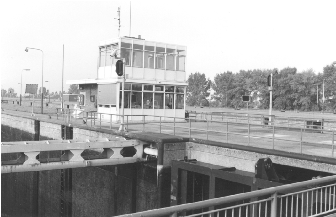
Foto 17.4 Aanvaarbalk van sluizen te Born en Maasbracht
