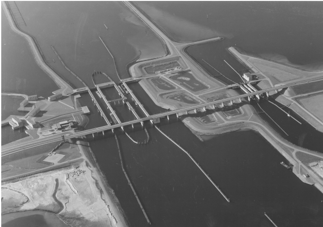
Foto 21.9 Overzicht Krammersluizencomplex met 2 duwvaart- en 2 jachtensluizen
