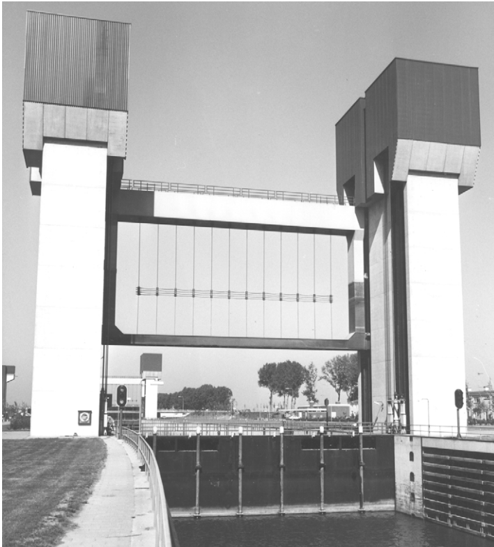
Foto 17.5 Vangnet als opvangconstructie van sluis te Wijk bij Duurstede
