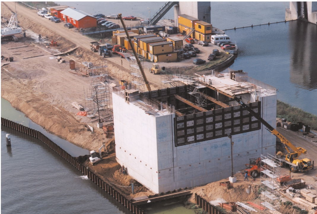
Foto 23.15 Bovenhoofd met drempel, uitgevoerd als caisson
