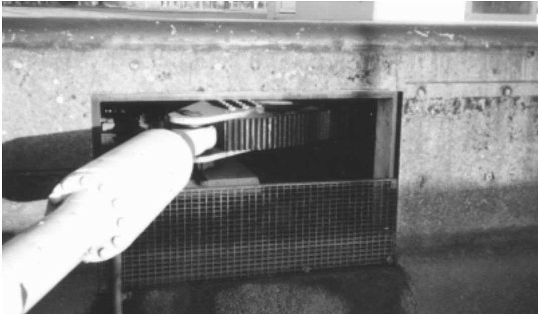
Foto 7.14 Deurbewegingswerk door middel van Panamawiel, sluis te Oosterhout
