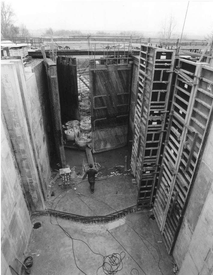
Foto 20.12 Vernieuwen sluishoofd Dalemse Sluis (1998)
