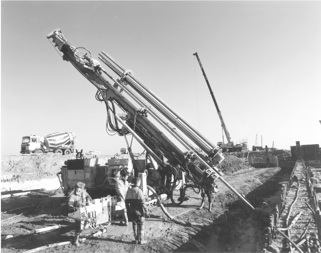
Foto 14.6 Aanbrengen groutankers voor verankering diepwanden van kolk van Tweede sluis te Lith
