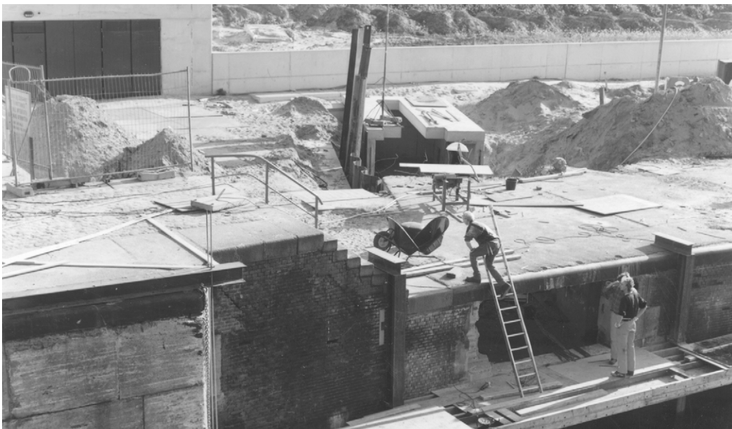
Foto 20.24 Bouw nieuwe kelders voor de deurbewegingswerken, Middensluis te IJmuiden
