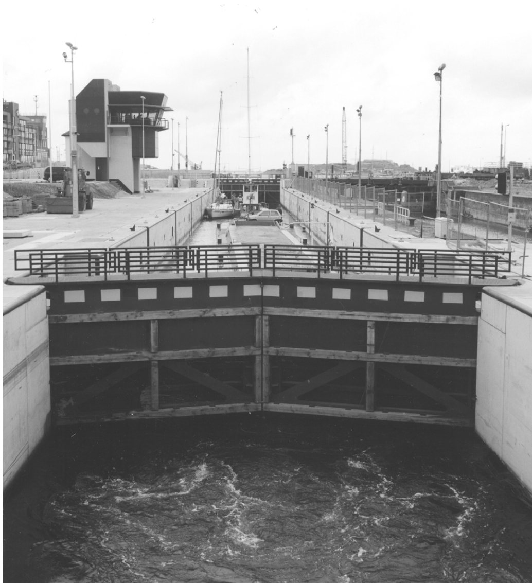
Foto 6.6 Stroombeeld tijdens ledigen d.m.v. deuropeningen van Kleine Sluis te IJmuiden
