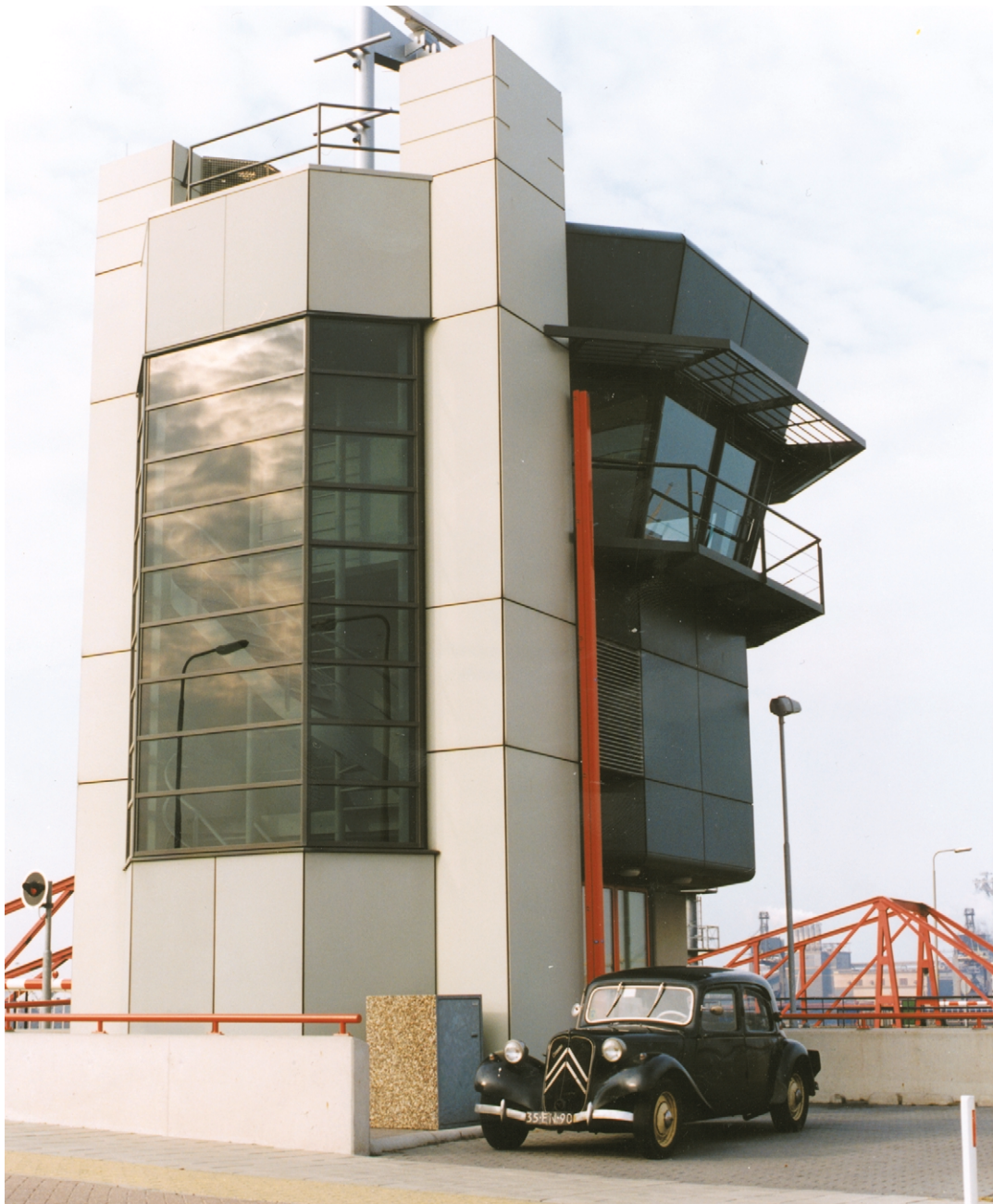
Foto 17.1 Bedieningsgebouw van Middensluis te IJmuiden
