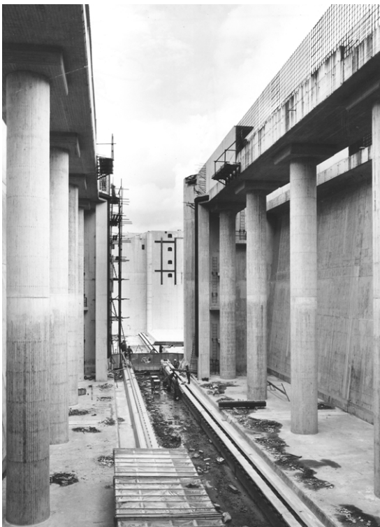
Foto 8.4 Deurkas van roldeur van zeesluis te Terneuzen
