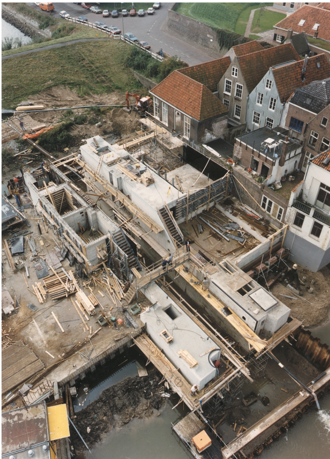
Foto 20.1 Reconstructie Sluis te Gorinchem
