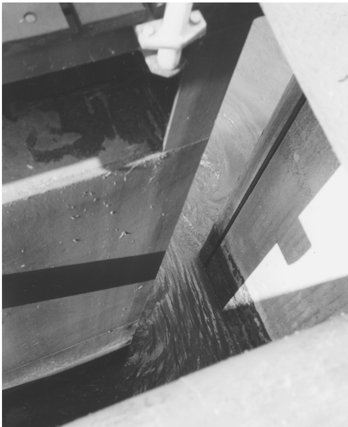
Foto 11.3 Strooming rondom de deurtip bij einde openen puntdeuren (Volkeraksluizen)
