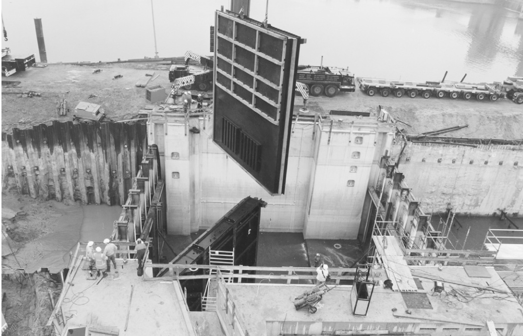
Foto 8.2 Benedenhoofd met puntdeuren van Tweede Sluis te Lith
