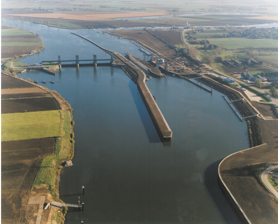
Foto 23.19 Nieuwe situatie stuw- en sluiscomplex te Lith, kijkrichting stroomopwaarts
