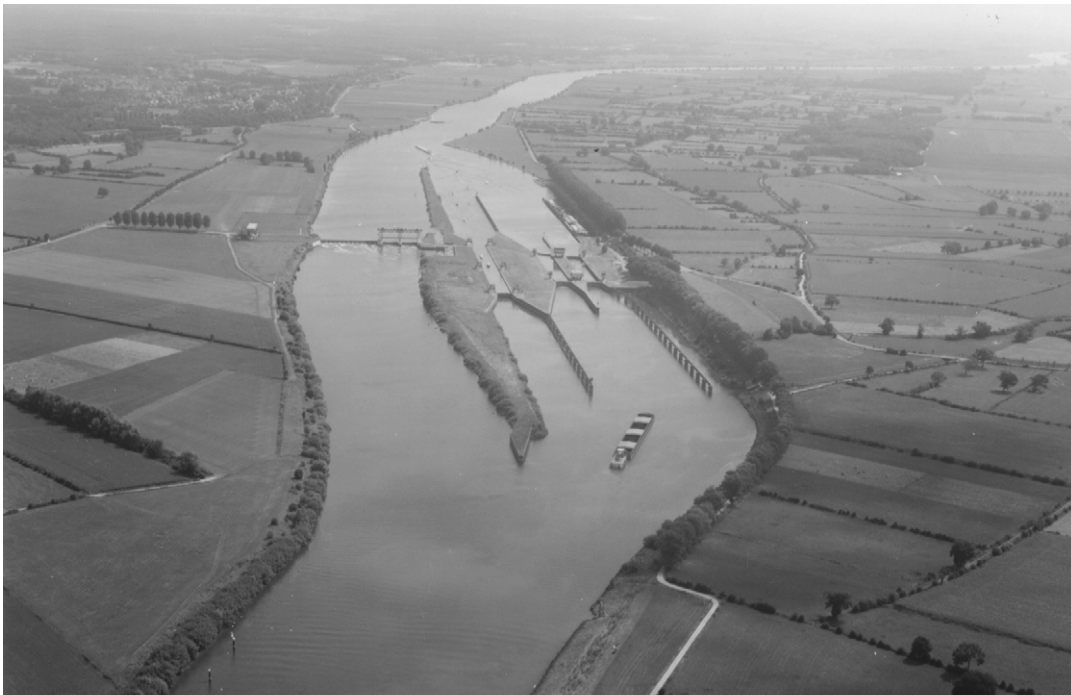
Foto 5.7 Layout van sluiscomplex te Sambeek aan de Maas met stuw (links) en 3 schutsluizen
