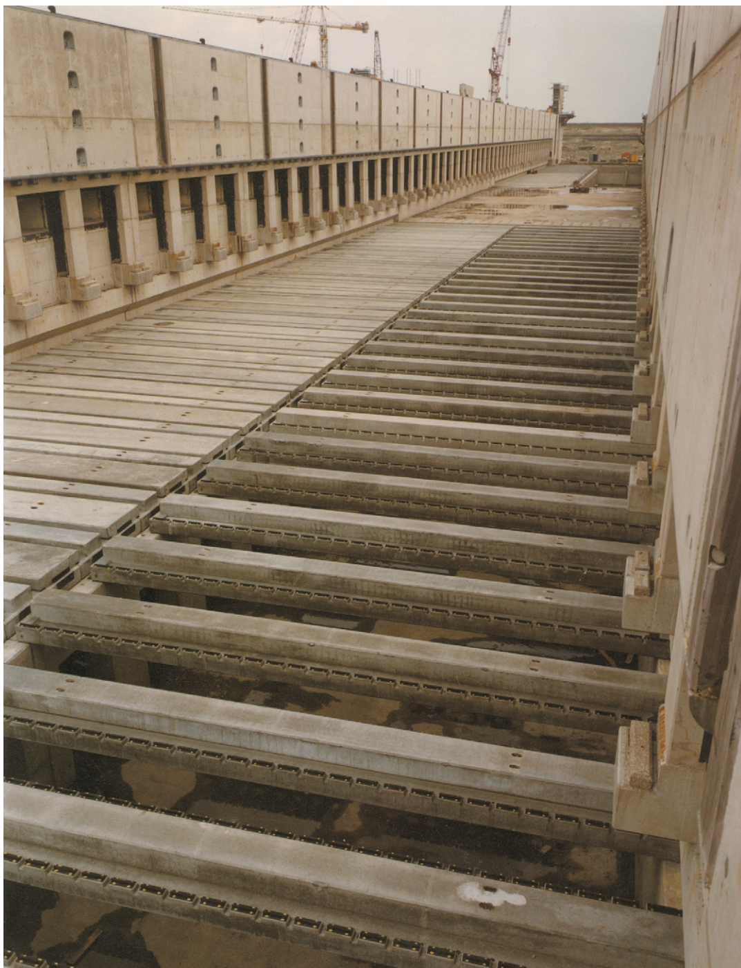
Foto 21.1 Krammersluizen in aanbouw, zichtbaar zijn de geperforeerde kolkvloer (sommige balken ontbreken) en de wandopeningen (wandschuiven en remmingwerken ontbreken)
