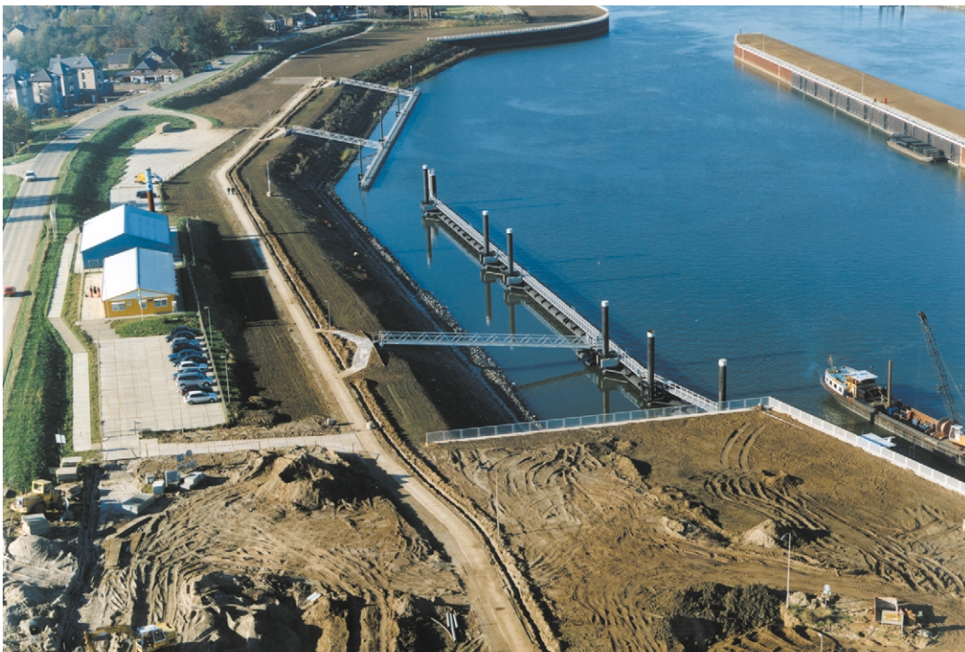
Foto 23.21 Benedenstroomse voorhaven sluiscomplex te Lith met opstelplaatsen beroepsvaart en recreatiesteiger
