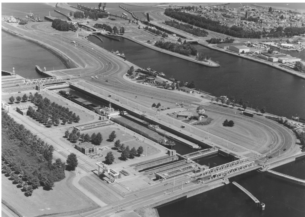
Foto 21.8 Zeesluis Terneuzen op voorgrond, rechtsonder binnenhoofd met aansluitend kanaaldeel met zoutput, bij buitenhoofd werkend luchtbellenscherm
