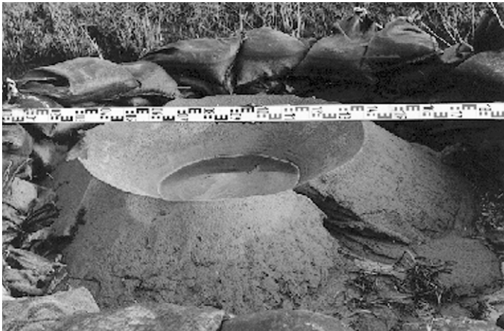
Foto 10.2 Zandmeevoerende wel op maaiveld achter een dijk (Heesselt; 1995)
