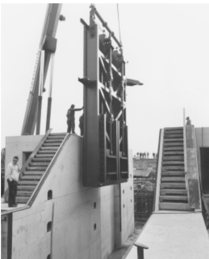
Foto 7.4 Enkele draaideur van Sluis te Gorinchem (1987)
