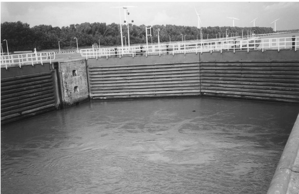
Foto 6.5 Stroombeeld tijdens vullen d.m.v. deuropeningen van duwvaartsluizen in de Volkerak
