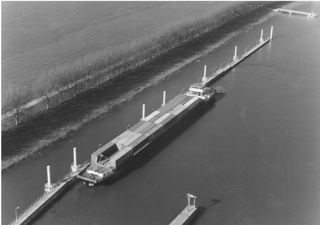
Foto 15.2 Drijvend remmingwerk sluiscomplex Belfeld aan de Maas met beschermopaal
