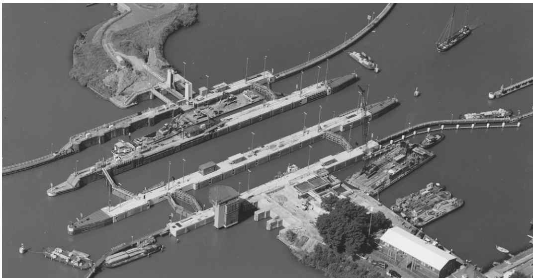
Foto 20.11 Reconstructie oude Oranjesluizencomplex (1999)
