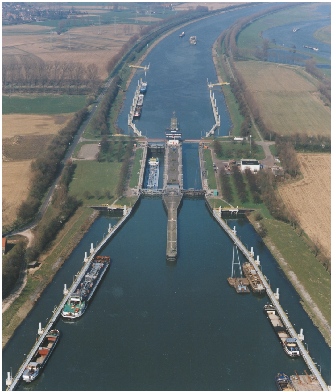
Foto 15.1 Sluiscomplex te Heel met drijvende remming- en geleidewerken
