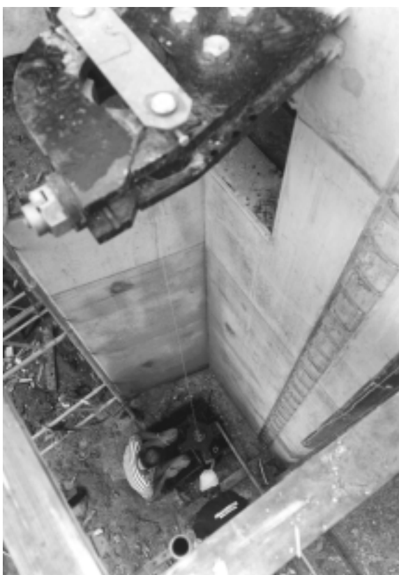
Foto 7.13 Stellen van taats van enkele draaideur van sluis te Gorinchem (1987)
