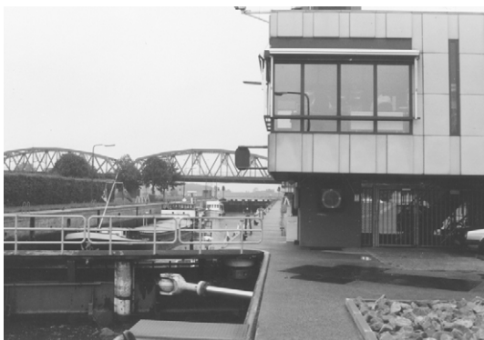
Foto 18.18 Bedieningsgebouw van Sluis Grave
