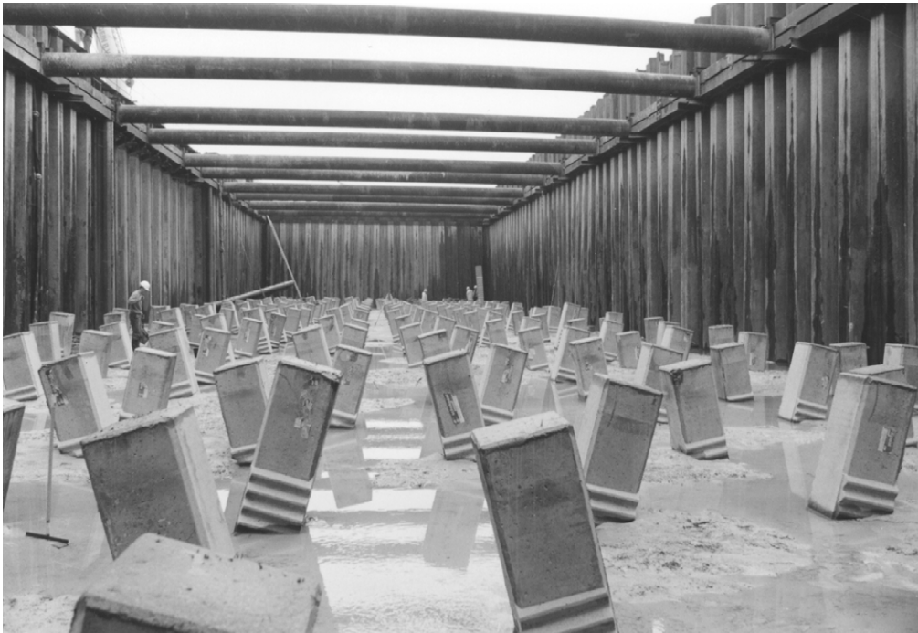
Foto 13.5 Damwandkuip voor sluishoofd van Nieuwe Oranjesluis met onderwaterbetonvloer en trekpalen
