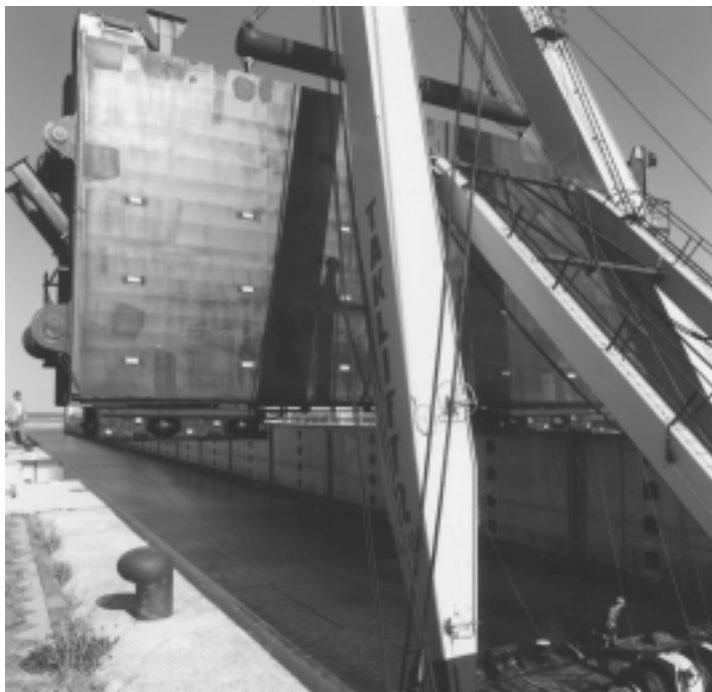
Foto 7.5 Roldeur van Krammersluizen tijdens plaatsing (1985)
