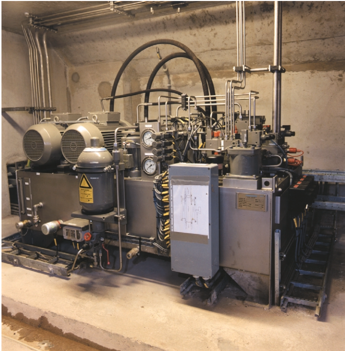
Foto 23.29 Hydraulische pompunit
