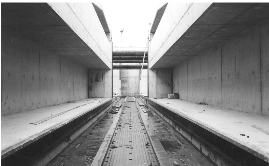
Foto 8.6 Deurkas van glijdeur van Nieuwe Oranjesluis te Amsterdam
