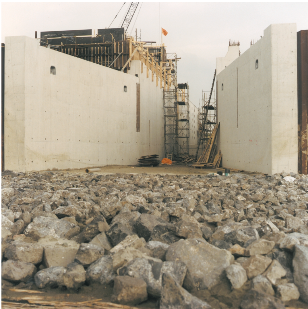
Foto 16.1 Bodembescherming in den droge aangebracht voor de Bergse Diepsluis
