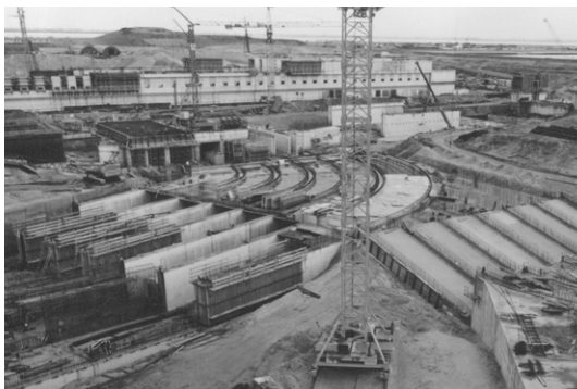
Foto 21.12 Riolensysteem in aanbouw, Krammer duwvaartsluizen
