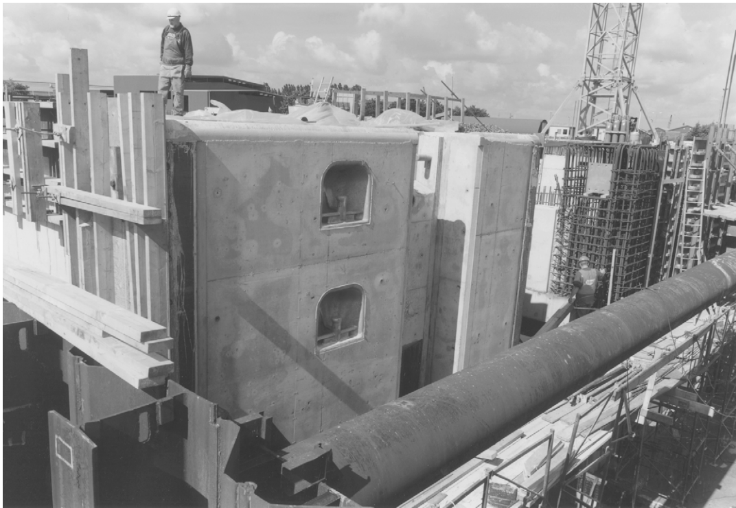
Foto 13.13 Betonconstructies van hoofd van Nieuwe Oranjesluis te Amsterdam
