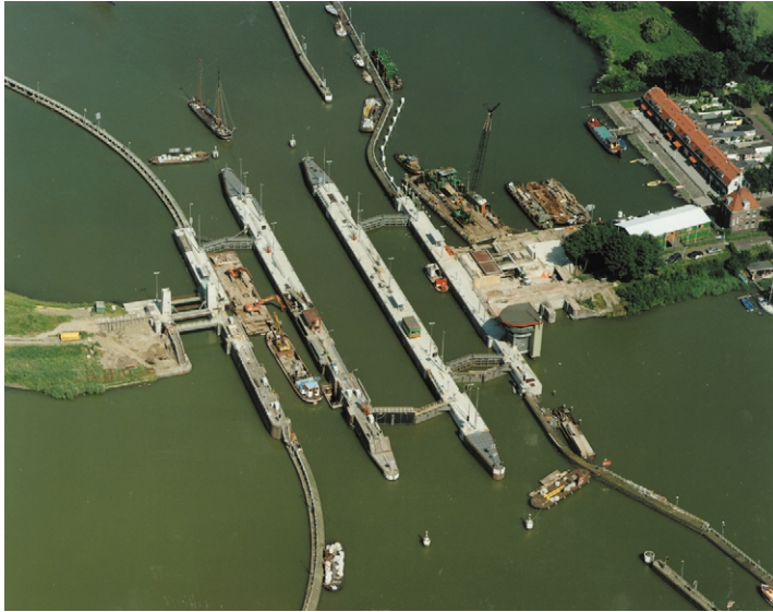
Foto 23.25 Het Oranjesluizencomplex tijdens de reconstructie (1999)
