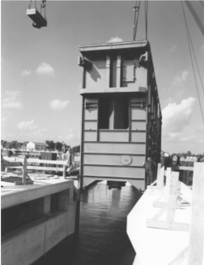
Foto 7.6 Glijdeur van Nieuwe Oranjesluis te Amsterdam tijdens plaatsing (1994)
