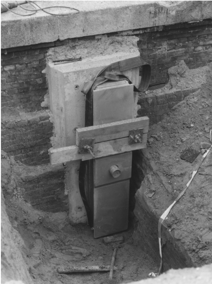
Foto 20.13 Verankering halsbeugel aan grondzijde, Middensluis te IJmuiden
