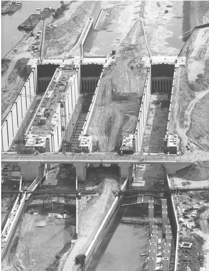
Foto 13.2 U-vormige betonbakken van sluiscomplex te Maasbracht
