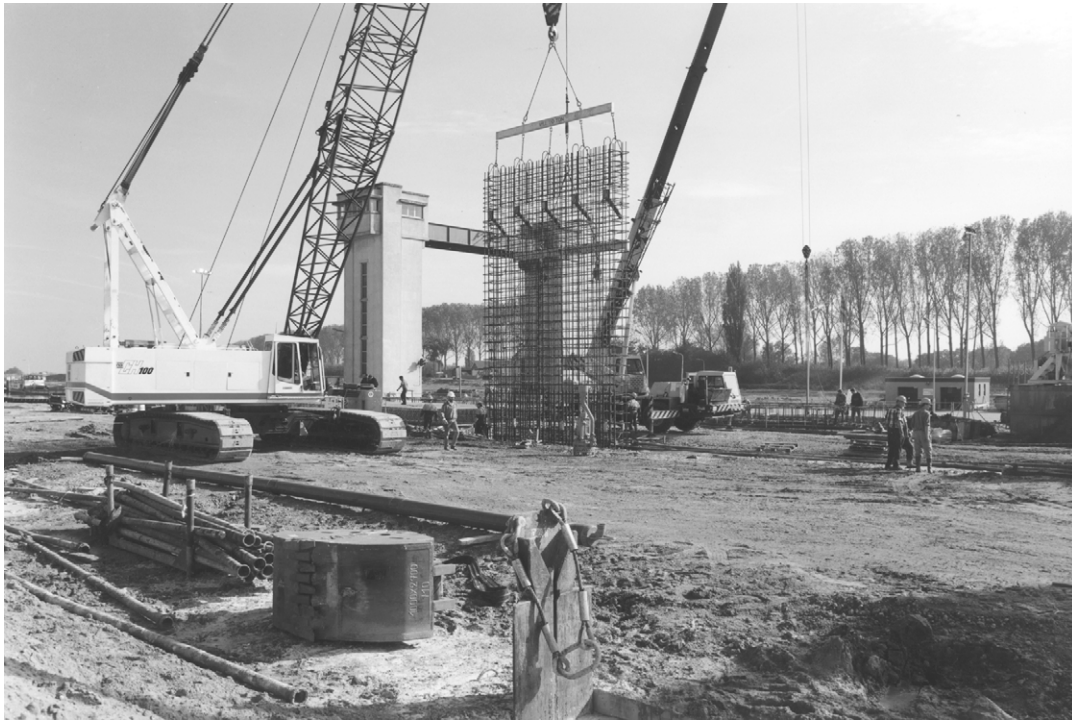
Foto 14.5 Aanbrengen wapening voor diepwanden van kolk van Tweede sluis te Lith
