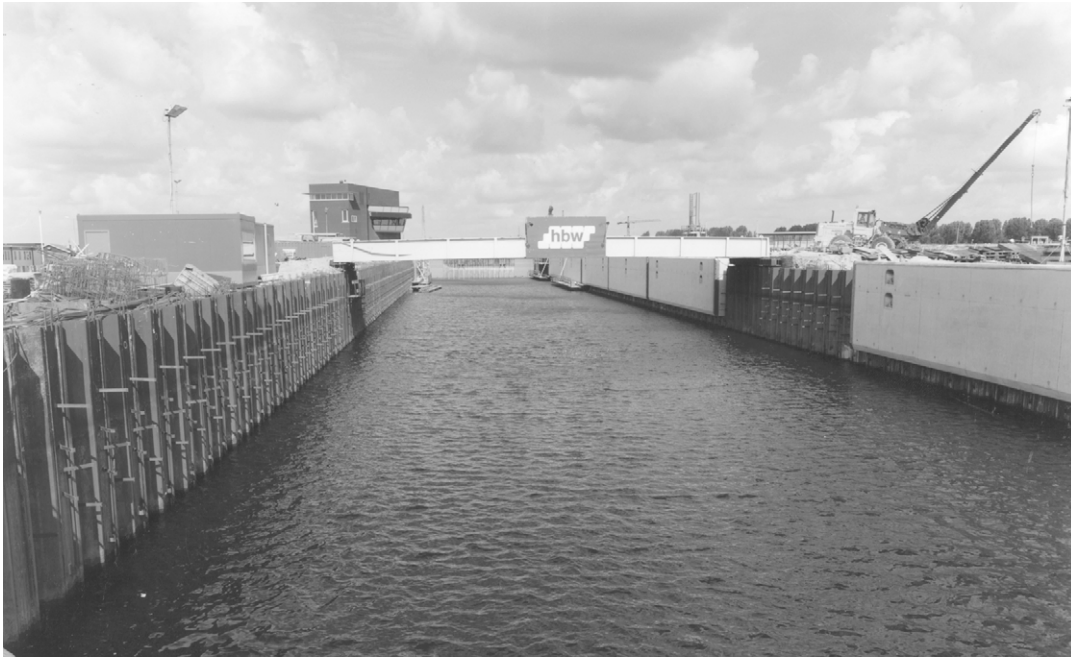
Foto 13.8 Sluiskolk van damwanden met betonnen voorwand en bodembescherming van Nieuwe Oranjesluis te Amsterdam
