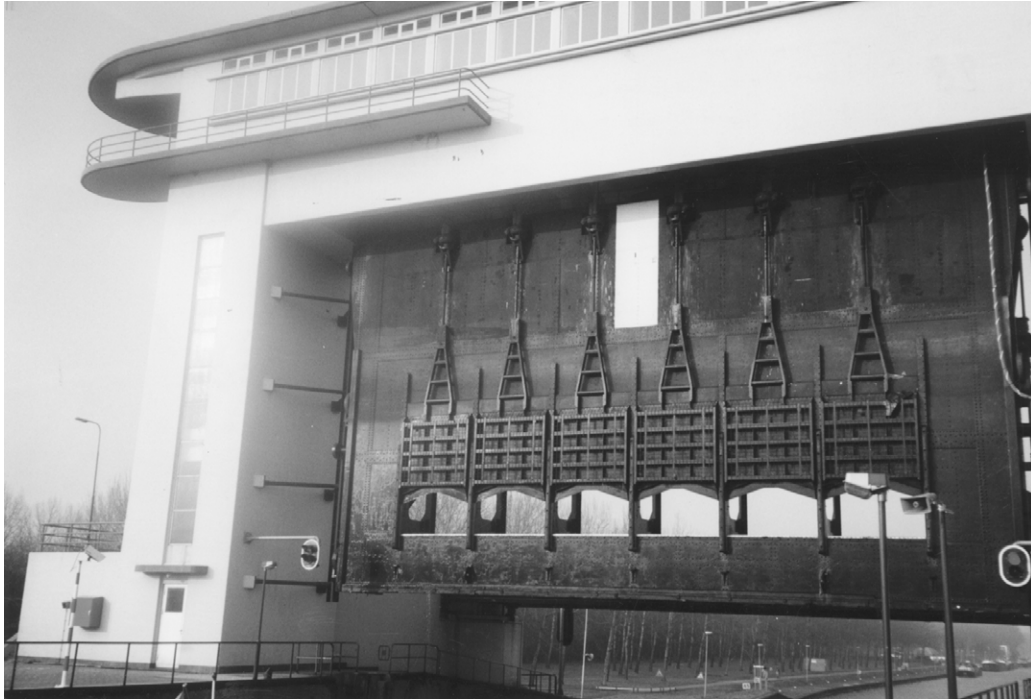
Foto 6.7 Deuropeningen in de hefdeur van Prinses Beatrixsluizen te Nieuwegein
