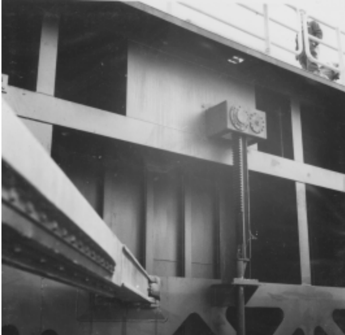
Foto 7.15 Rechte heugelstangen voor deur- en schuifbeweging van Koopvaardersschutsluis te Den Helder
