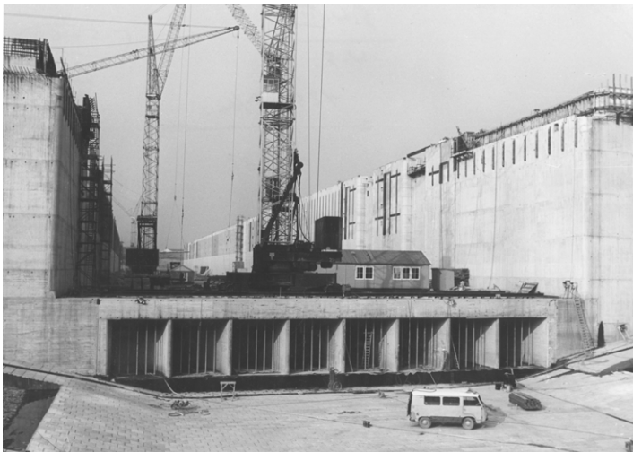
Foto 21.7 Laaggelegen zuigmond bij binnenhoofd, Zeesluis Terneuzen
