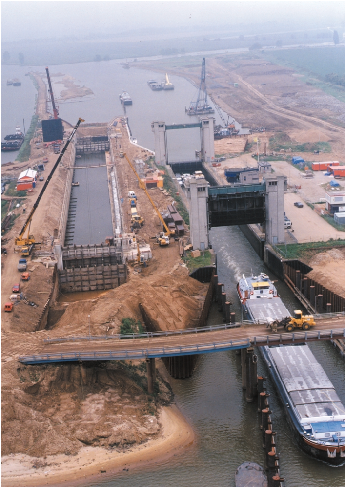
Foto 23.14 Situatie tijdens de bouw Tweede sluis te Lith tijdens inhangen deur
