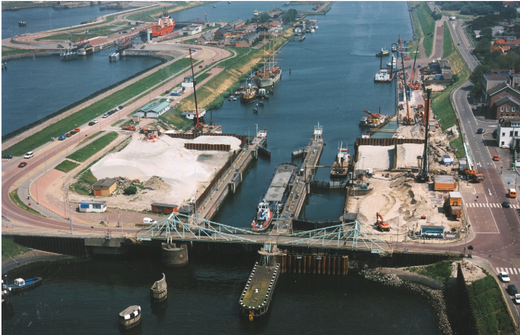
Foto 23.2 Situatie bij Zuidersluis (links) en Kleine Sluis (rechts) te IJmuiden kort na aanvang werkzaamheden (1997); links-achteraan is de Middensluis zichtbaar.
