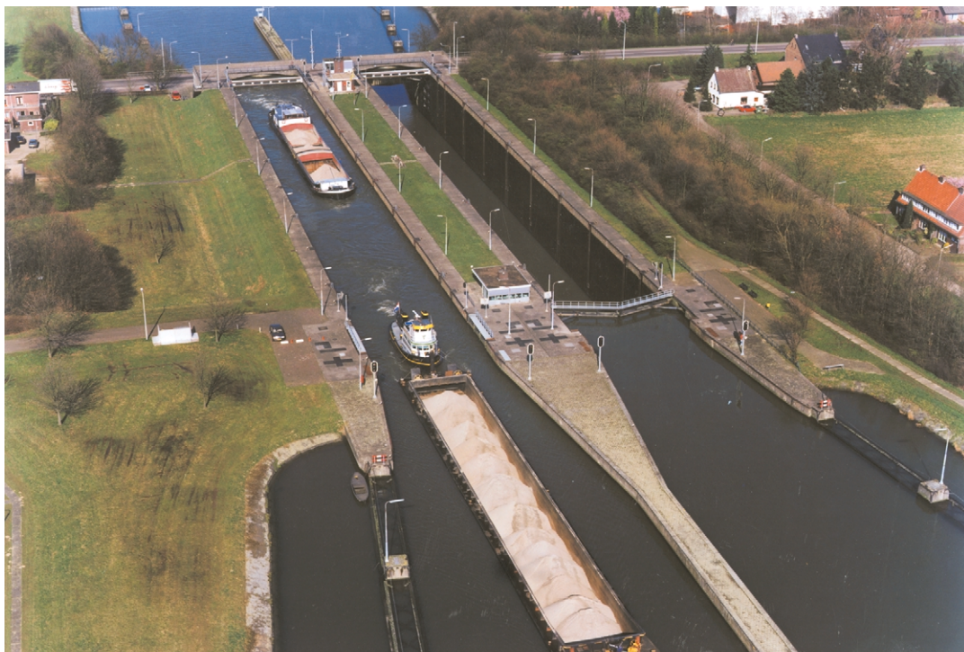
Sluiscomplex Born in het Julianakanaal (maart 1999)
