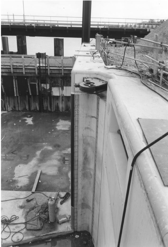
Foto 13.14 Betonnen deurkas van Kleine Sluis te IJmuiden
