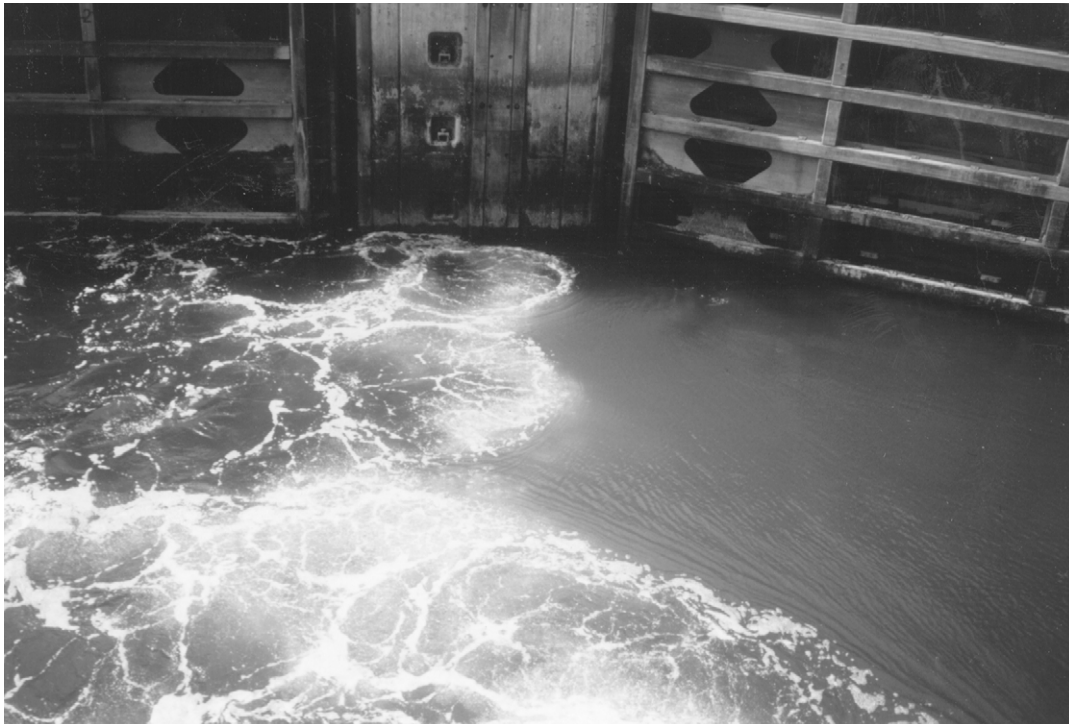
Foto 21.4 Luchtbellenscherm tijdens openen deuren, Jachtensluis Volkerak
