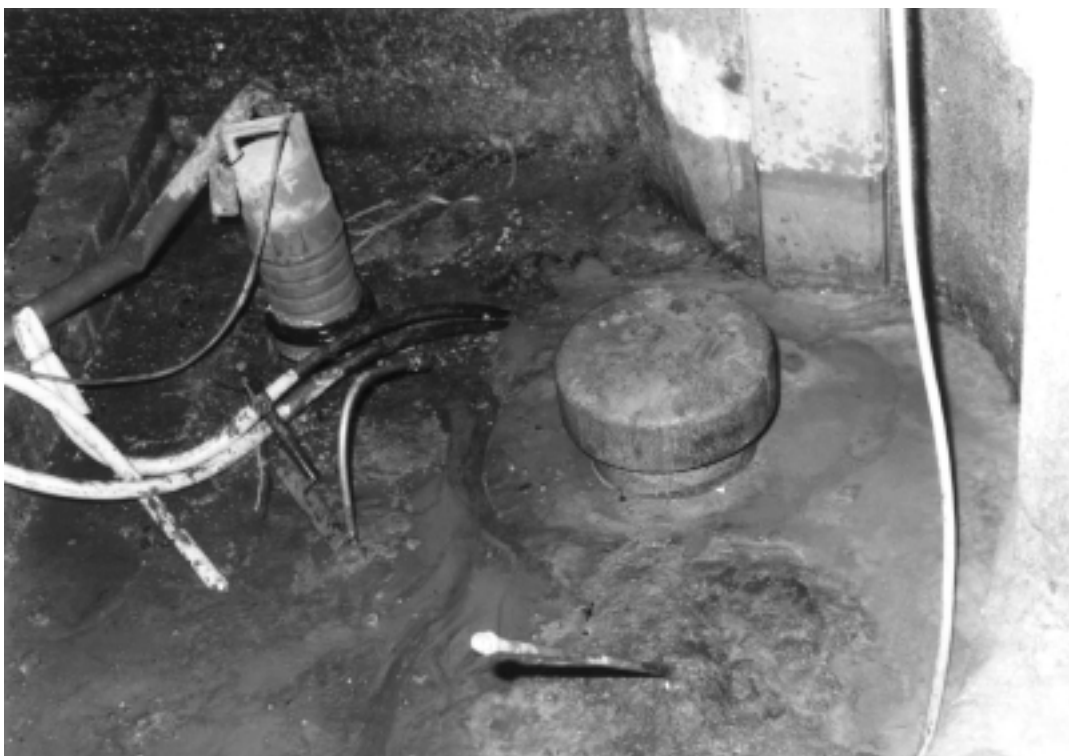
Foto 7.8 Taats van de puntdeur van Middensluis IJmuiden
