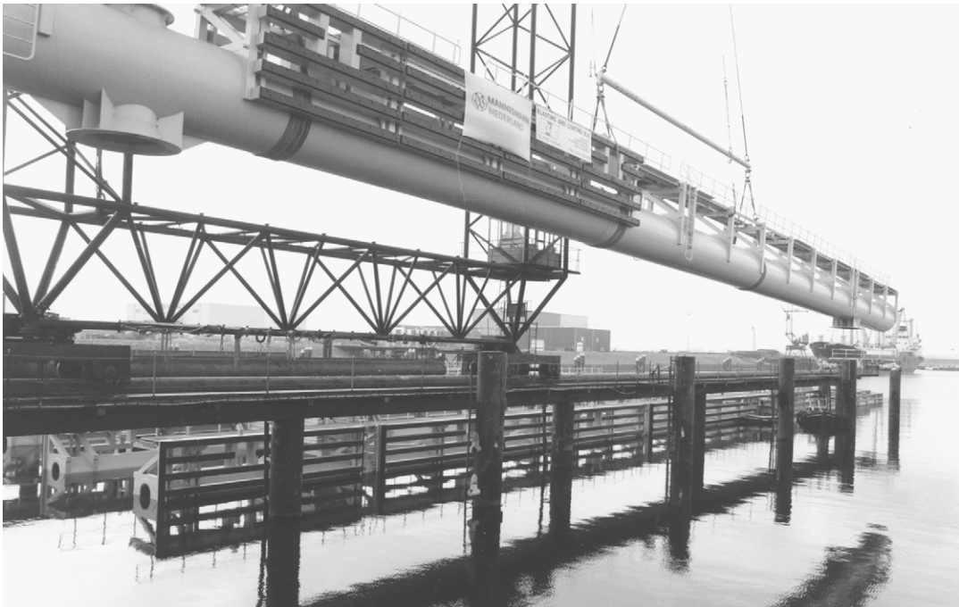
Foto 15.11 Buisligger voor tweezijdig remmingwerk met dobberpalen op montageplaats (Let op constructie aan buis voor verbinding met dobberpaal)
