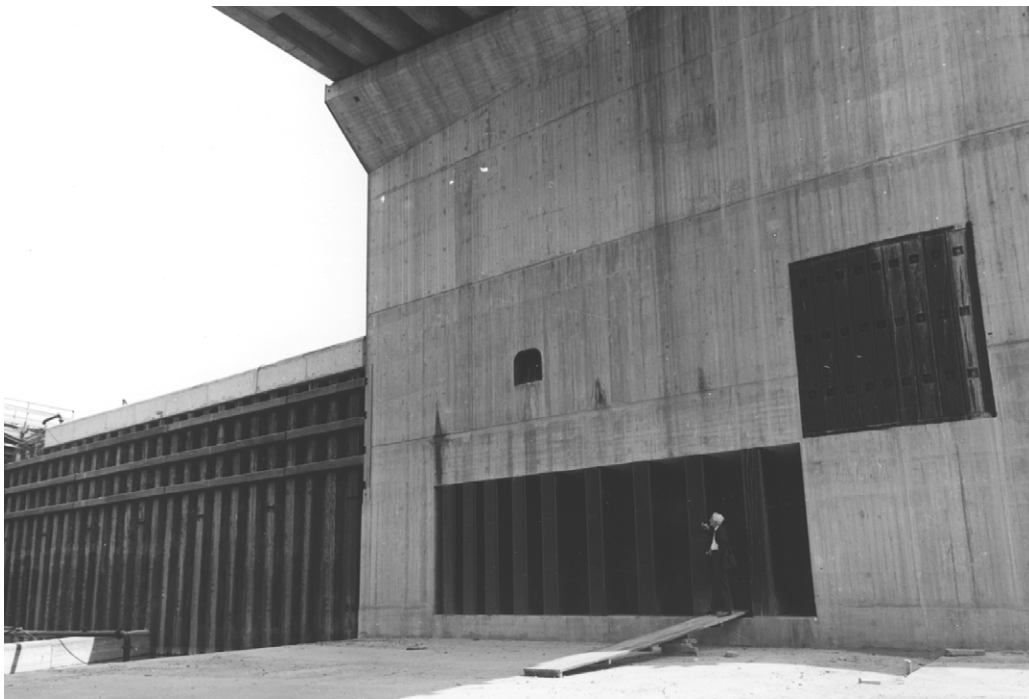
Foto 6.19 Uitstroomopening omloopriool van benedenhoofd van sluizen te Maasbracht
