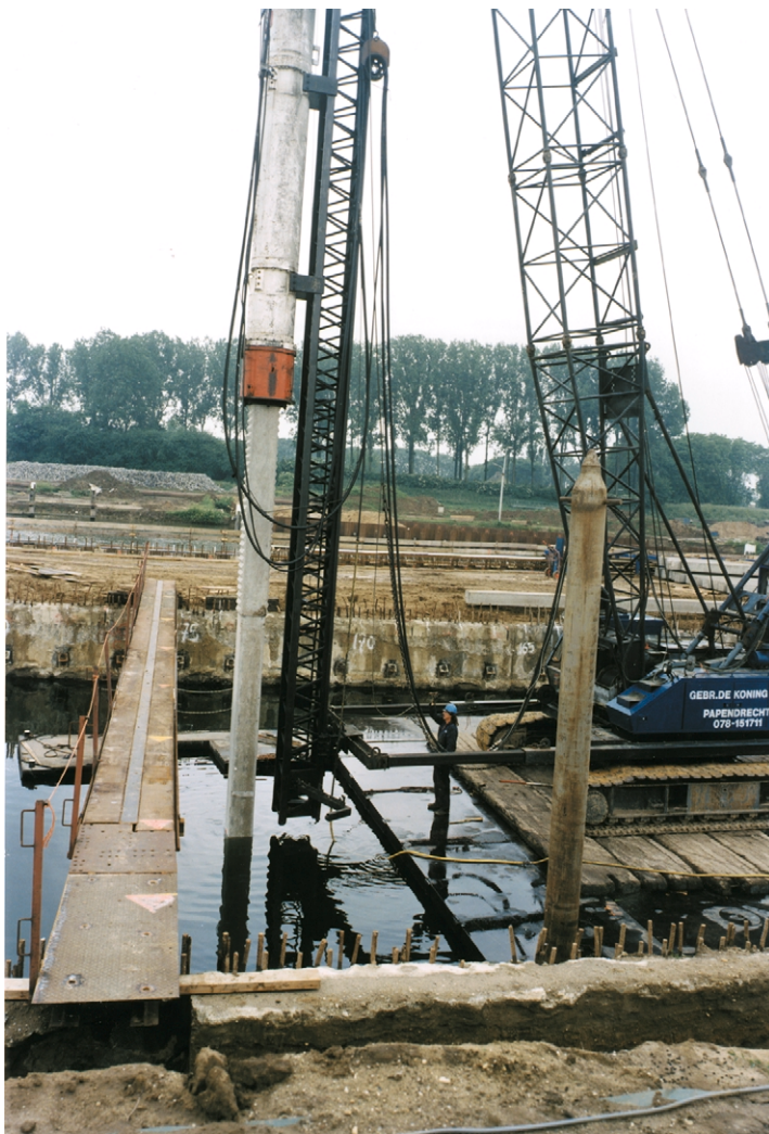
Foto 23.23 Heien trekpalen in kolk Tweede sluis Lith
