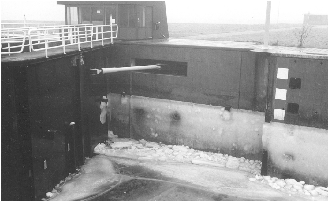
Foto 17.6 Ijs in puntdeurkassen van jachtensluis Volkerak
