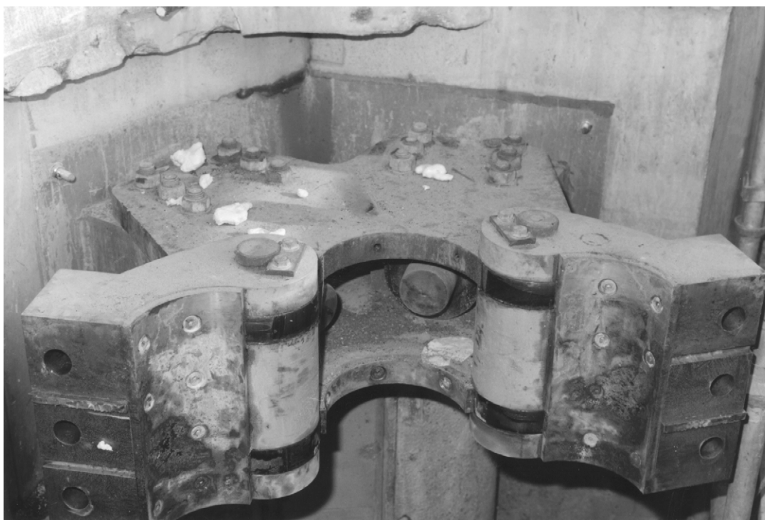
Foto 20.15 Halsbeugel opengeklaapt, Middelensluis te IJmuiden
