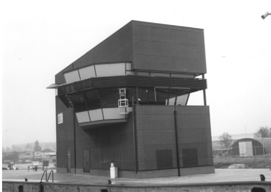
Foto 18.12 Bedieningsgebouw van Prins Willem-Alexandersluis
