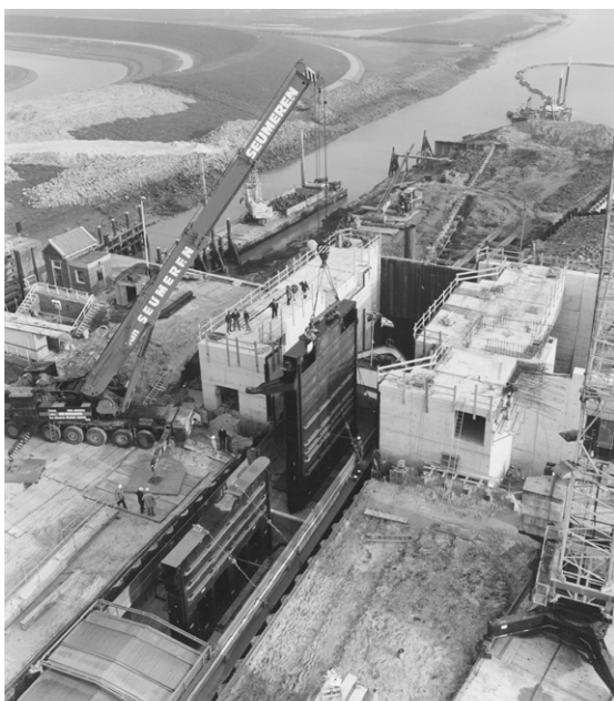
Foto 8.3 Buitenhoofd met enkele draaideuren van schutsluis te Nieuwe Statenzijl
