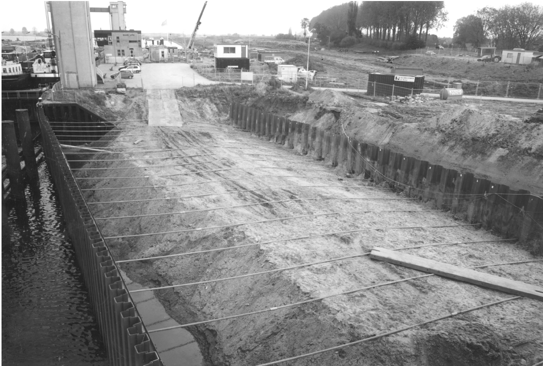
Foto 14.2 Stalen damwand met ankerscherm, sluiscomplex Lith
