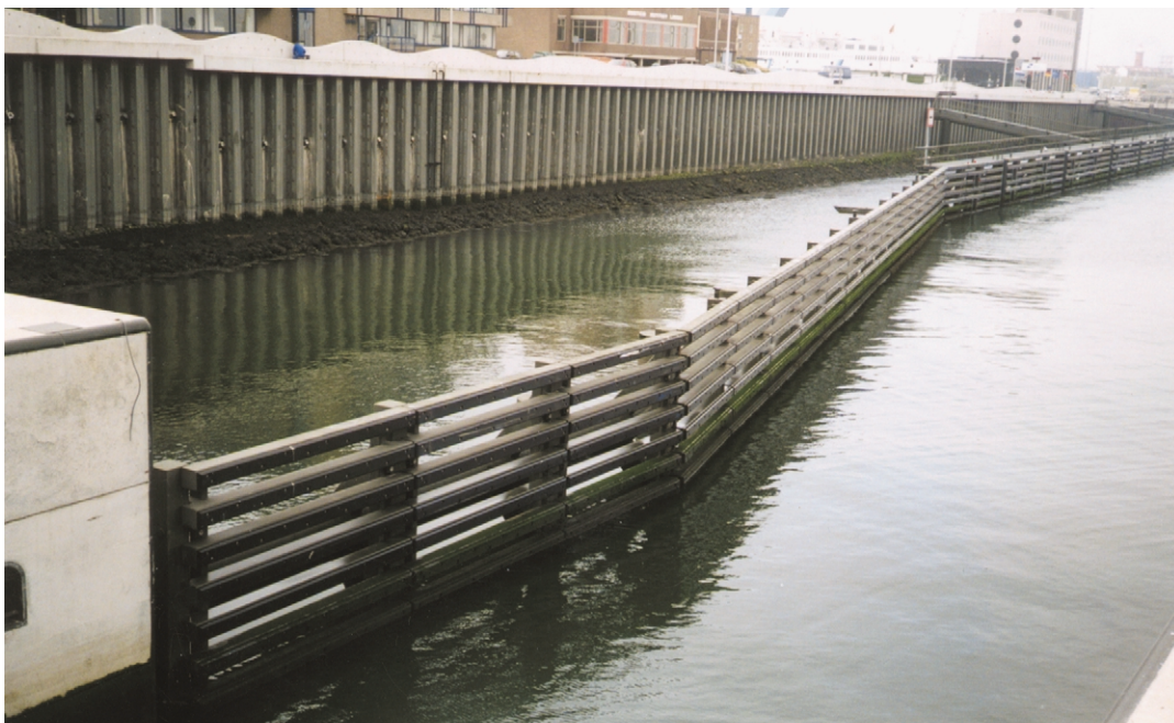
Foto 23.12 Opstelplaats en fuik recreatievaart Kleine Sluis aan zeezijde
