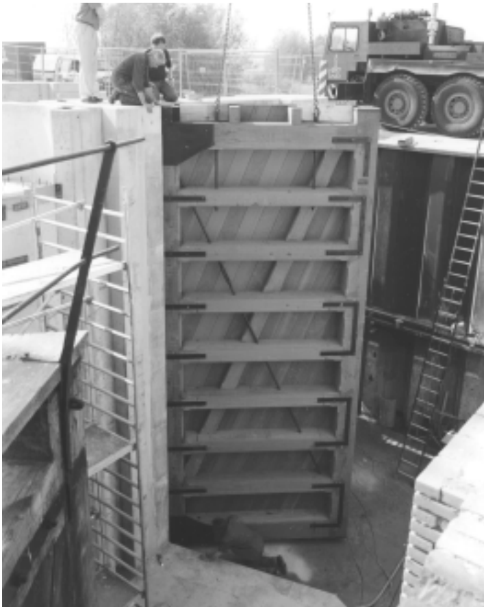
Foto 7.2 Houten puntdeur van sluis te Dalem tijdens plaatsing (1998)
