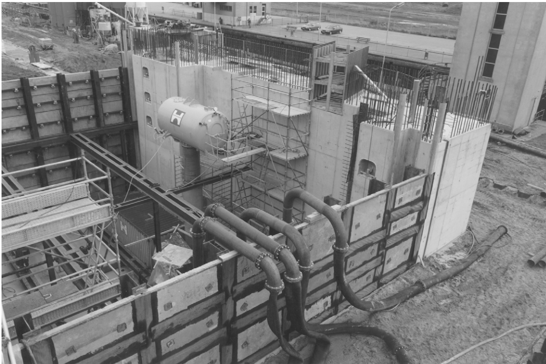
Foto 13.17 Caisson tijdens het afzinken (Tweede sluis Lith)
