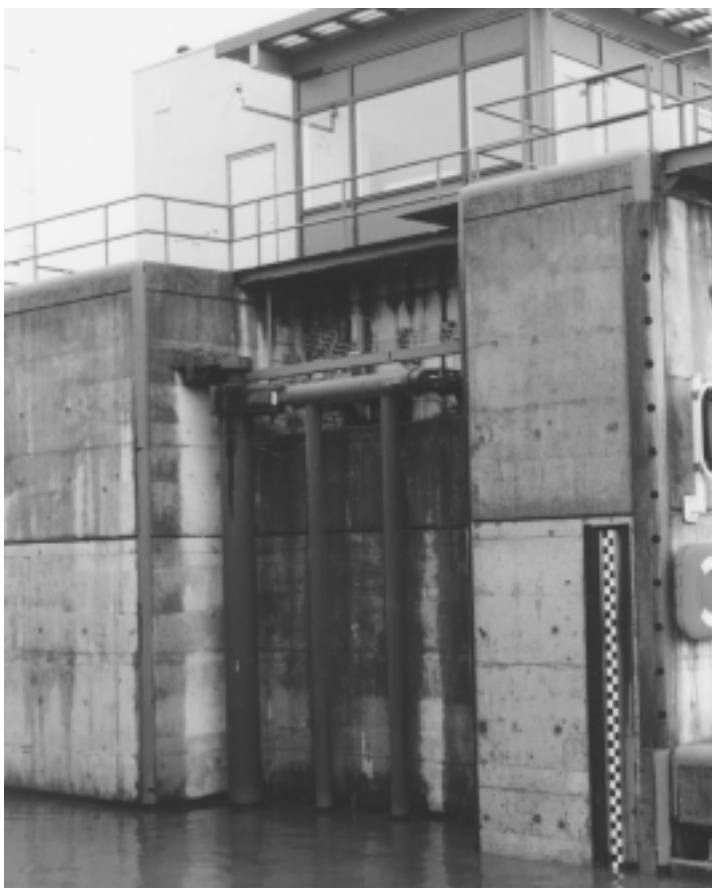
Foto 7.21 Vergrendeling voor enkele draaideur met raamgrendel van schutsluis te Nieuwe Statenzijl
