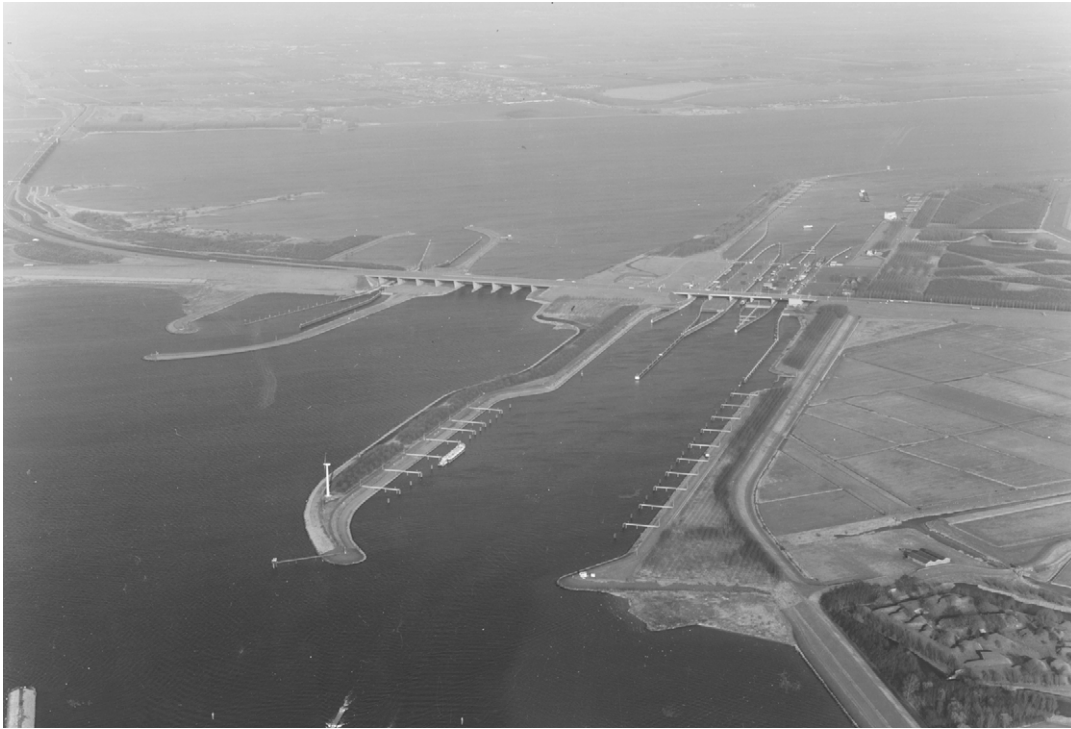
Foto 5.8 Layout van sluiscomplex Volkerak met (v.l.n.r.) jachtensluis, spuisluis en drie duwvaartsluizen als verbinding van Volkerak (onder) met Haringvliet (boven)
