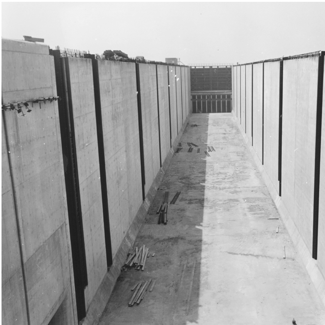
Foto 9.1 Kolk van schutsluizen te Maasbracht
