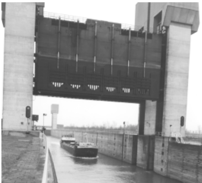
Foto 7.7 Hefdeur van Prins Bernardsluis te Tiel
