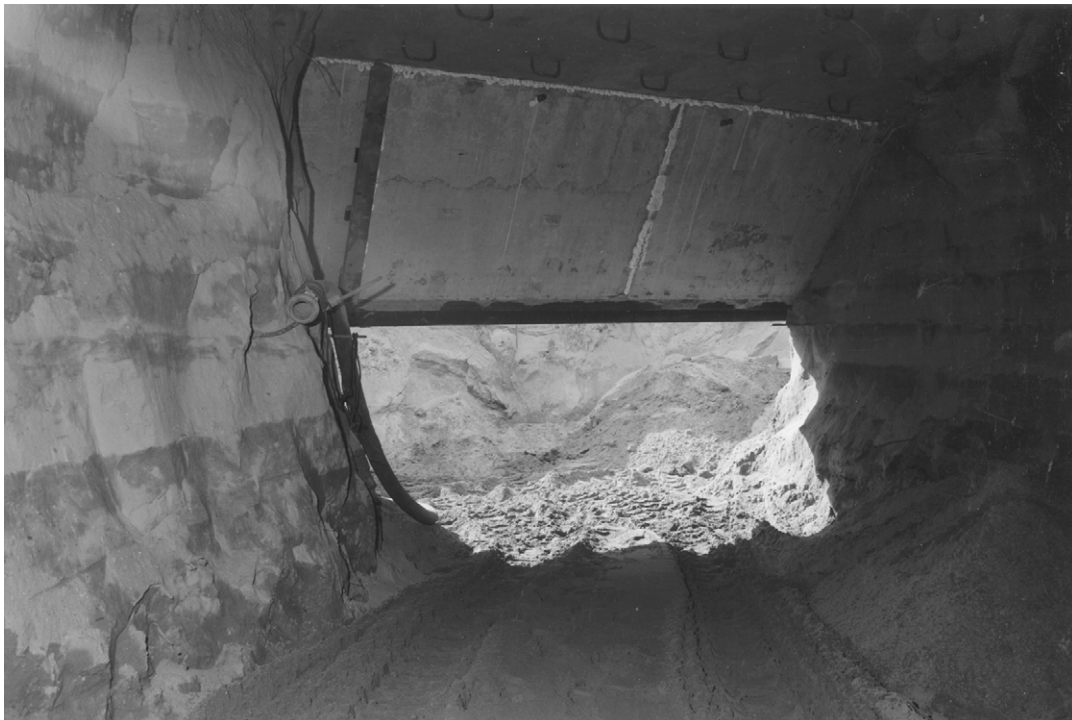
Foto 13.18 Onder atmosferische luchtdruk verwijderen van zand onder de caisson (Tweede sluis Lith)
