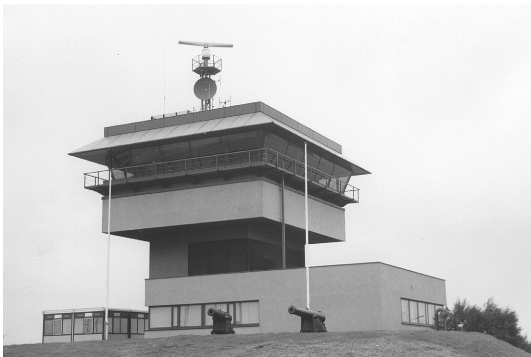
Foto 17.10 Bedieningsgebouw van Noordersluis te IJmuiden
