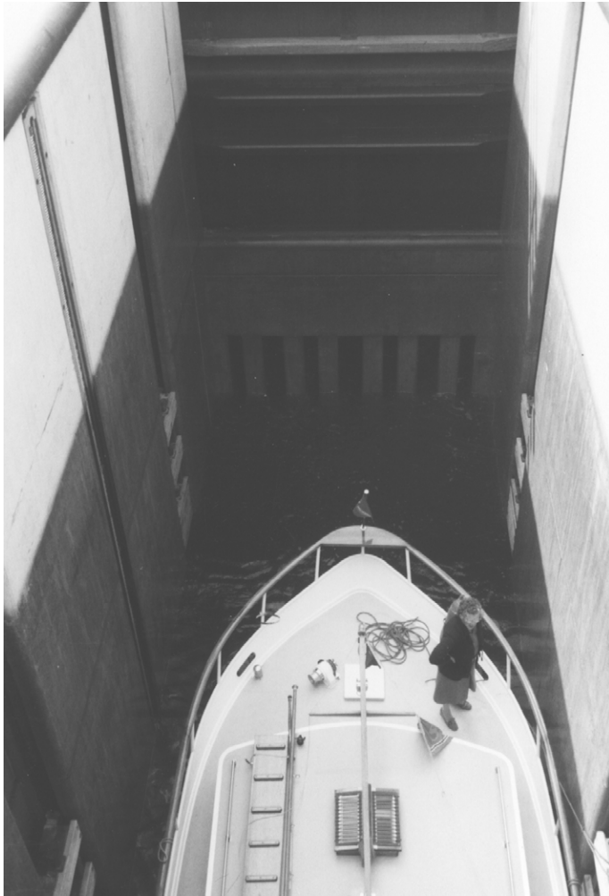
Foto 6.17 Woelkelder van schutsluis te Almere
