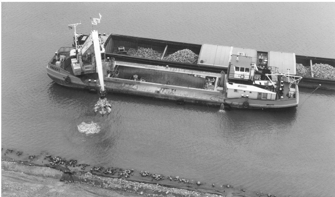
Foto 16.5 Aanbrengen oeverbescherming in den natte bij het sluiscomplex van Lith
