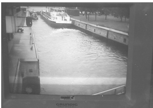
Foto 18.20 CCTV-monitor, Sluis Grave
