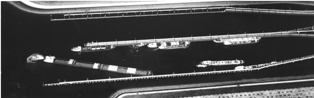
Foto 15.7 Aanvaarmanoeuvere van schip klasse Vb tegen enkelzijdig remmingwerk Volkeraksluizen
