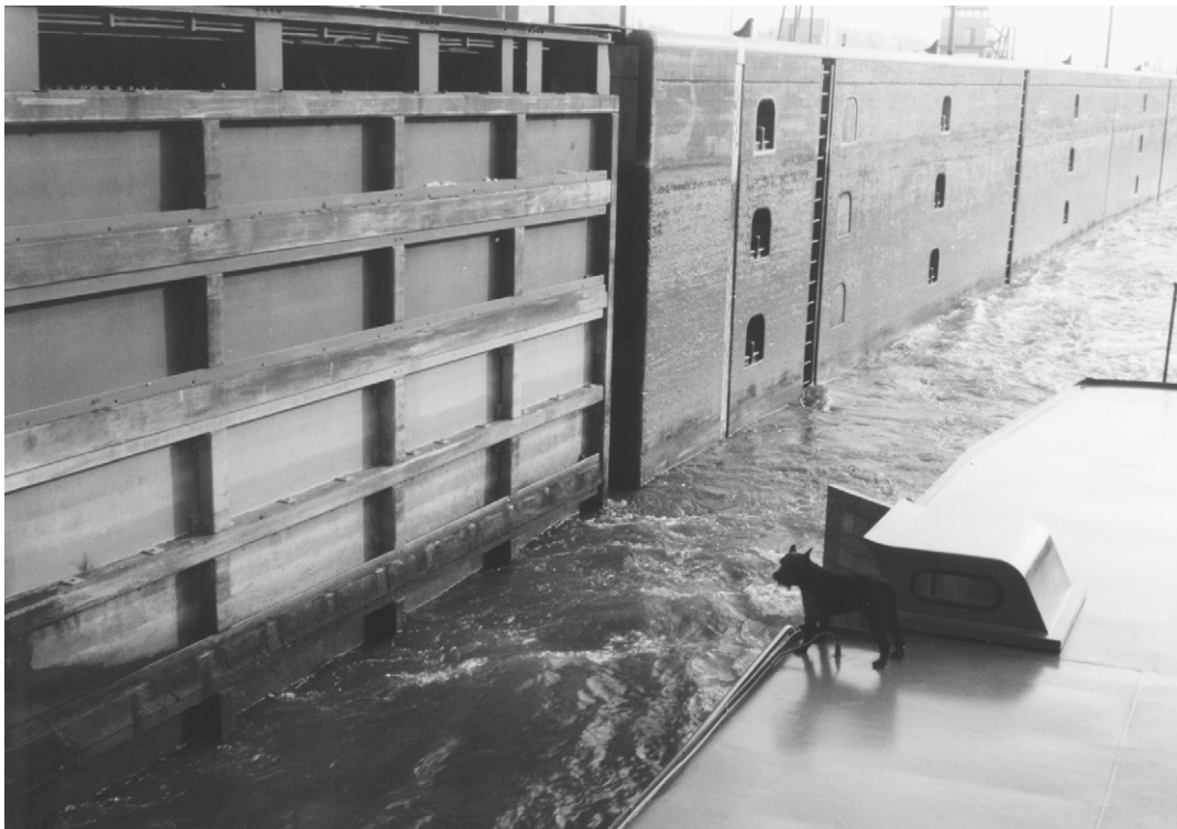
Foto 11.7 Stoming tussen geopende deur en schip als gevolg van het langsvaren
