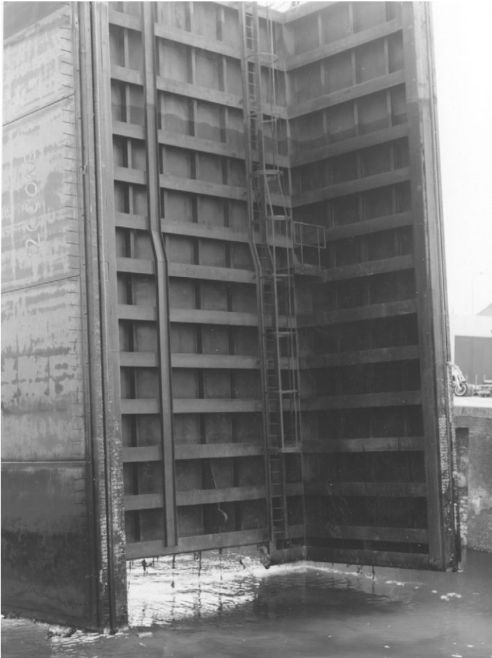
Foto 20.17 Taatskuip boven water, Middensluis te IJmuiden
