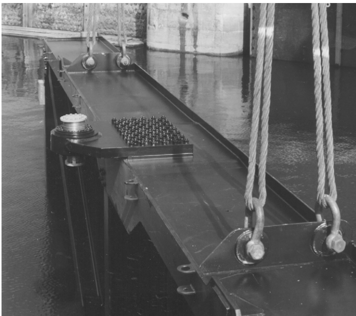
Foto 20.28 Inhangen deur, Middensluis te IJmuiden
