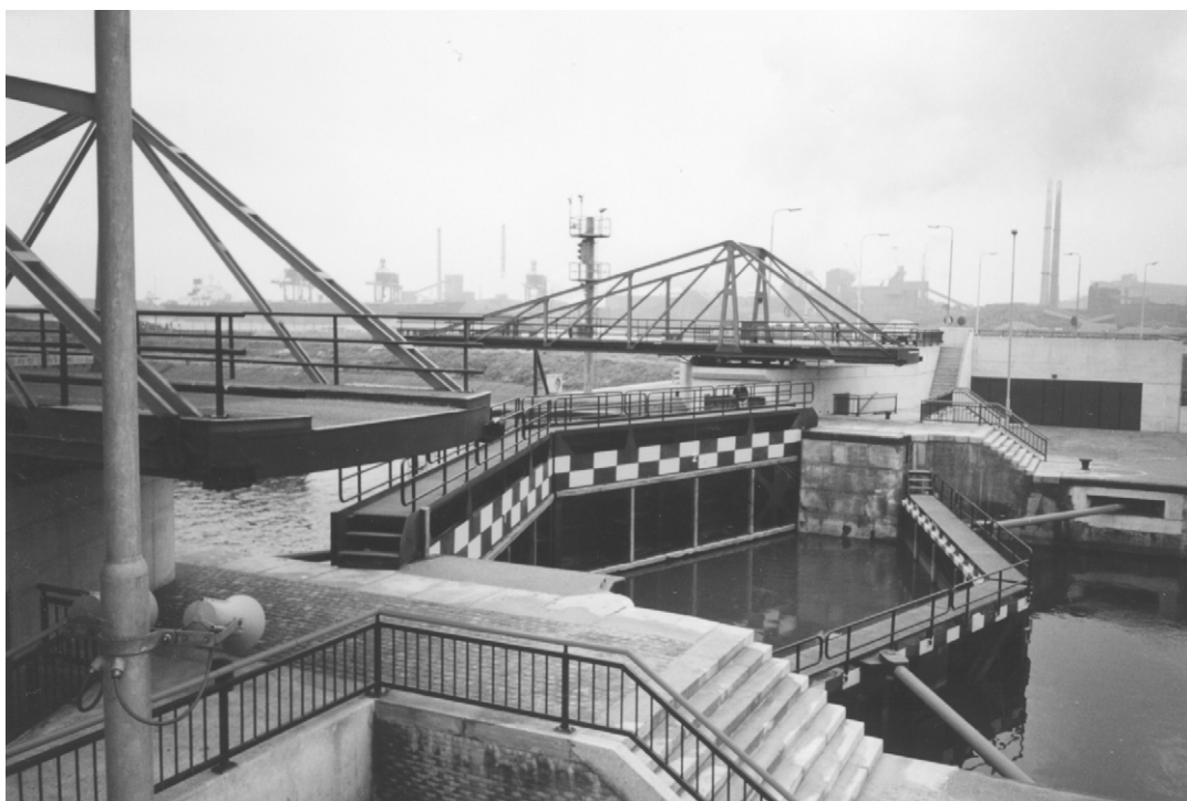
Foto 20.29 Eindsituatie, Middensluis te IJmuiden
