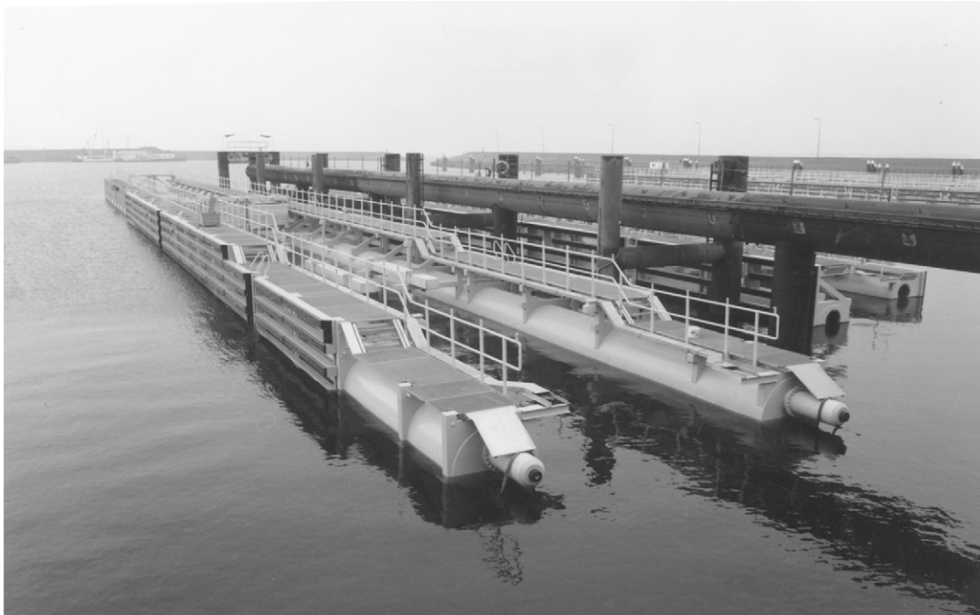
Foto 15.9 Drijvende buisligger met pen- en gatverbindingen op montageplaats
