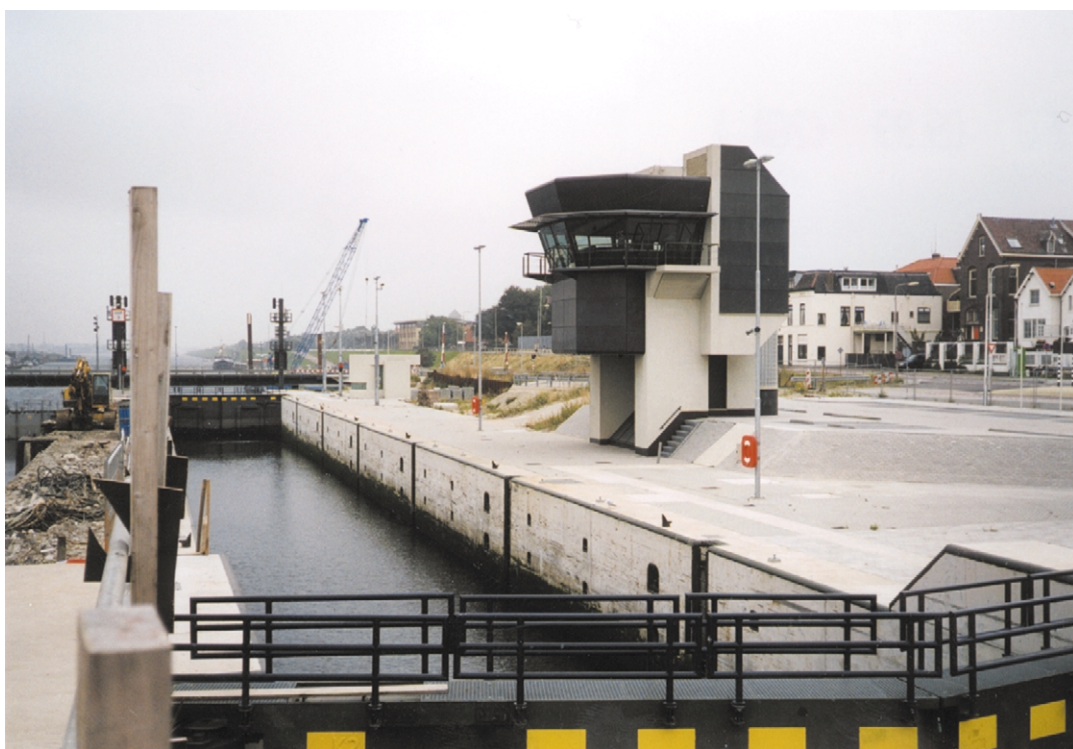
Foto 23.7 Kleine Sluis na voltooiing
