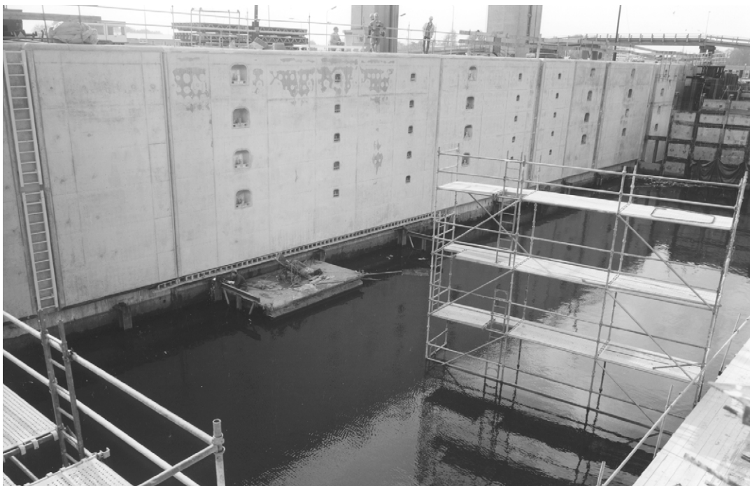
Foto 13.10 Voorwand voor de diepwand van sluiskolk van Tweede sluis te Lith
