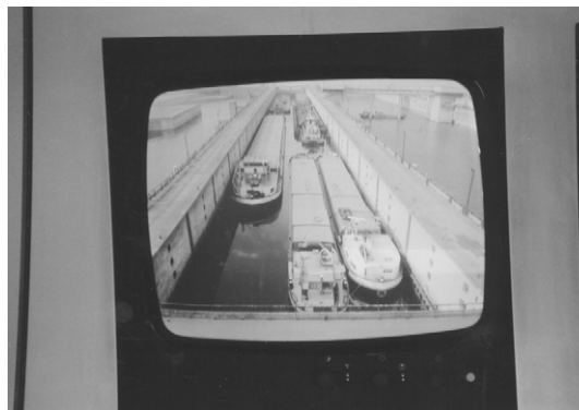
Foto 18.7 Beeld van CCTV-monitor, Krammersluizen
