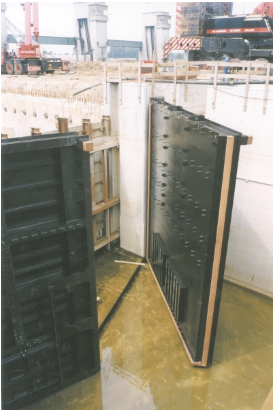
Foto 7.1 Punteuren van Tweede Sluis te Lith tijdens plaatsing (1998)
