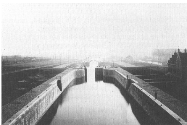
Foto 20.4 De Grote of Nieuwe Schutsluis in het Merwedekanaal te Vianen
