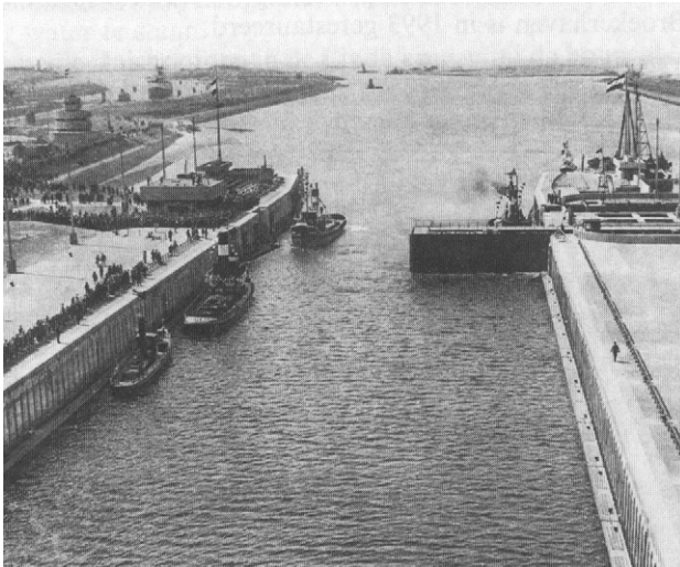
Foto 20.9 Noordersluis te IJmuiden met roldeur (omstreeks 1930)
