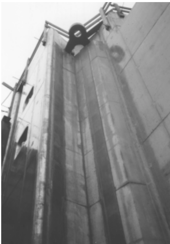
Foto 7.12 Aanslagvlakken van puntdeur van Tweede Sluis te Lith
