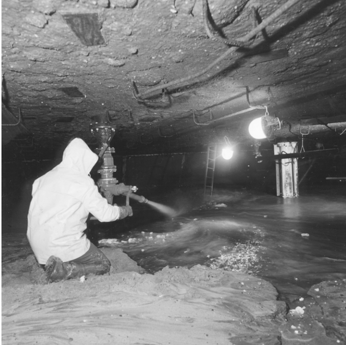
Foto 13.19 Onder verhoogde luchtdruk wegspoelen van grond met spuitkanonnen onder de caisson (Tweede sluis Lith)
