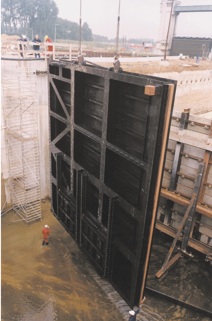
Foto 23.17 Plaatsing van sluisdeur
