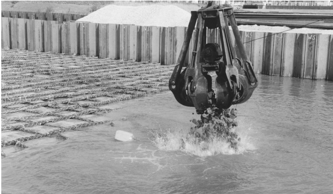
Foto 16.4 Aanbrengen bodembescherming in den natte in de kolk van de Nieuwe Oranjesluis
