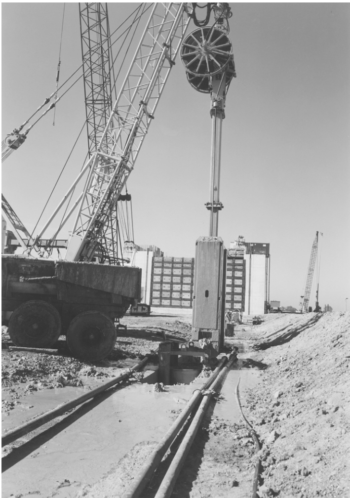
Foto 14.4 Aanleg diepwanden van kolk van Tweede sluis te Lith
