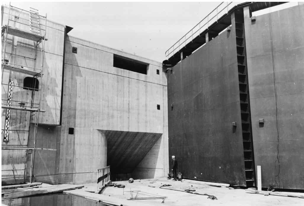
Foto 6.14 Instroomopening omloopriool van bovenhoofd van sluisen te Maasbracht
