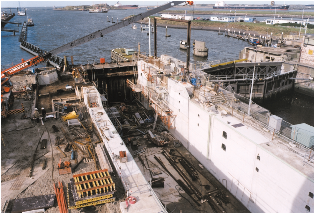
Foto 23.5 Kleine Sluis in afbouwstadium met zicht op buitenhoofd
