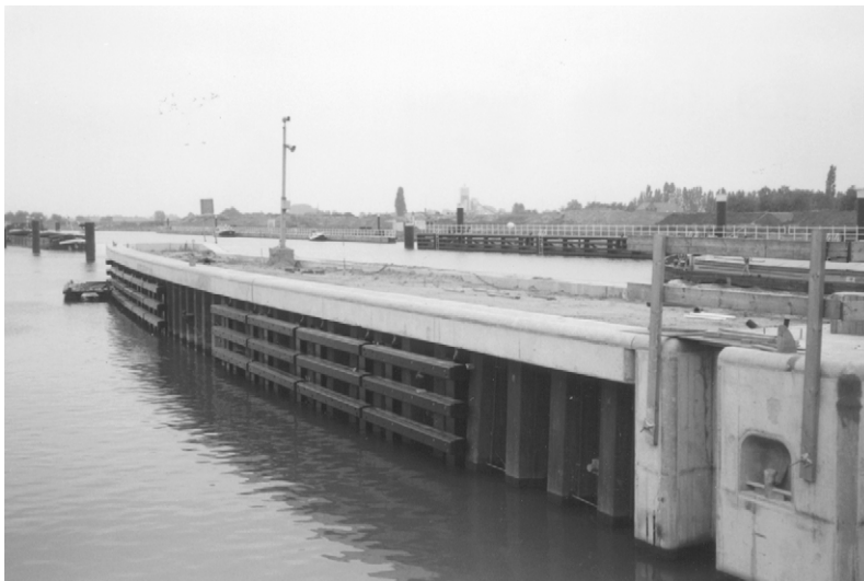
Foto 14.7 Bekleding damwand Tweede sluis Lith
