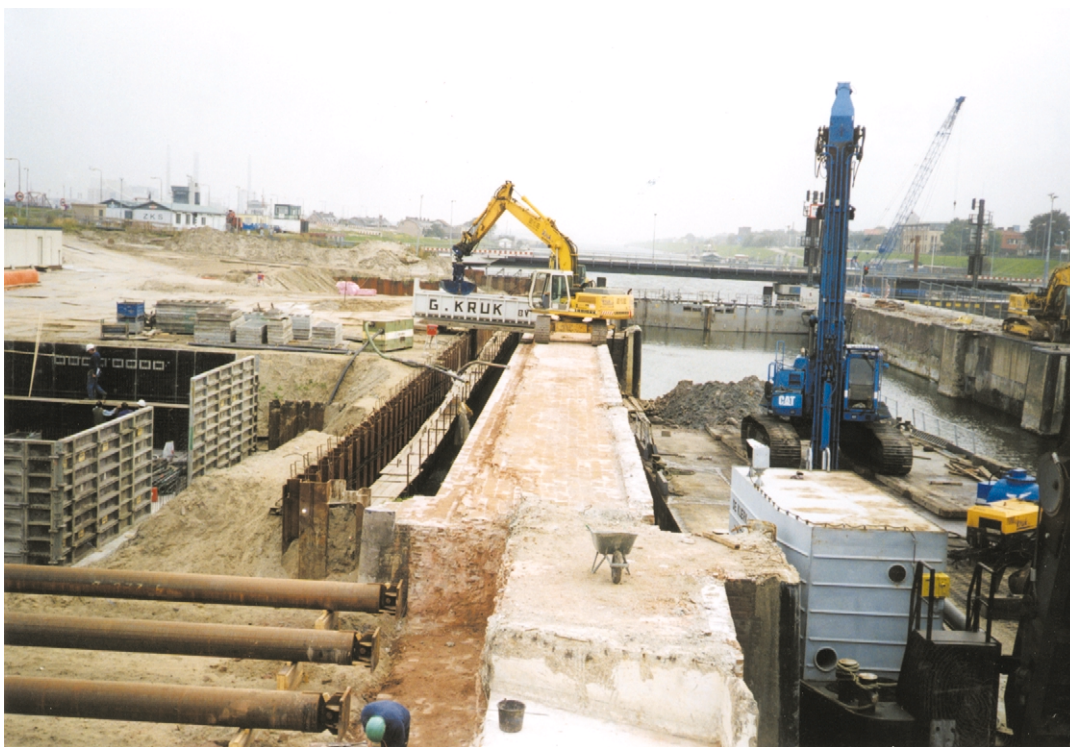
Foto 23.8 Versterking buitenhoofd en kolkwand Zuidersluis aan noordzijde
