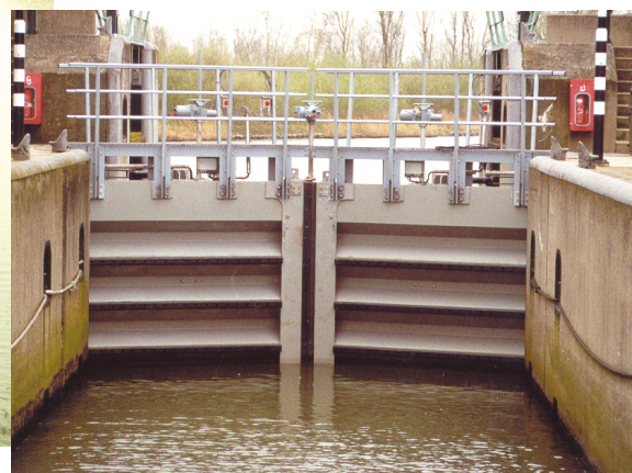
Foto 22.2 Kunststof sluisdeur in kerende stand (Spieringsluis, april 2000)
