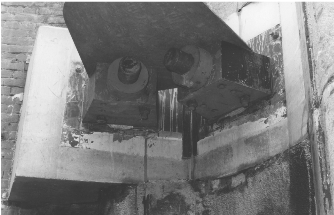
Foto 20.14 Verankering halsbeugel aan deurkaszijde, Middensluis te IJmuiden
