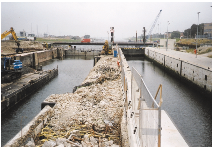
Foto 23.9 Renovatie zuidelijke kolkwand Zuidersluis.
