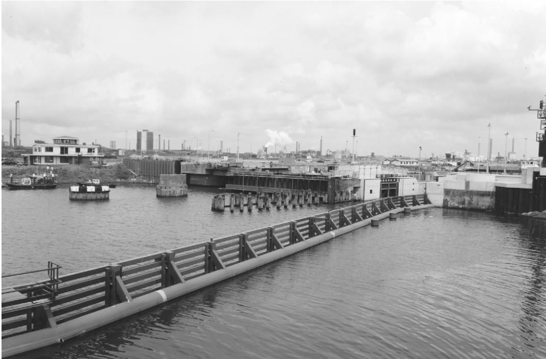
Foto 15.5 Vast remming- en geleidewerk van Kleine Sluis te IJmuiden
