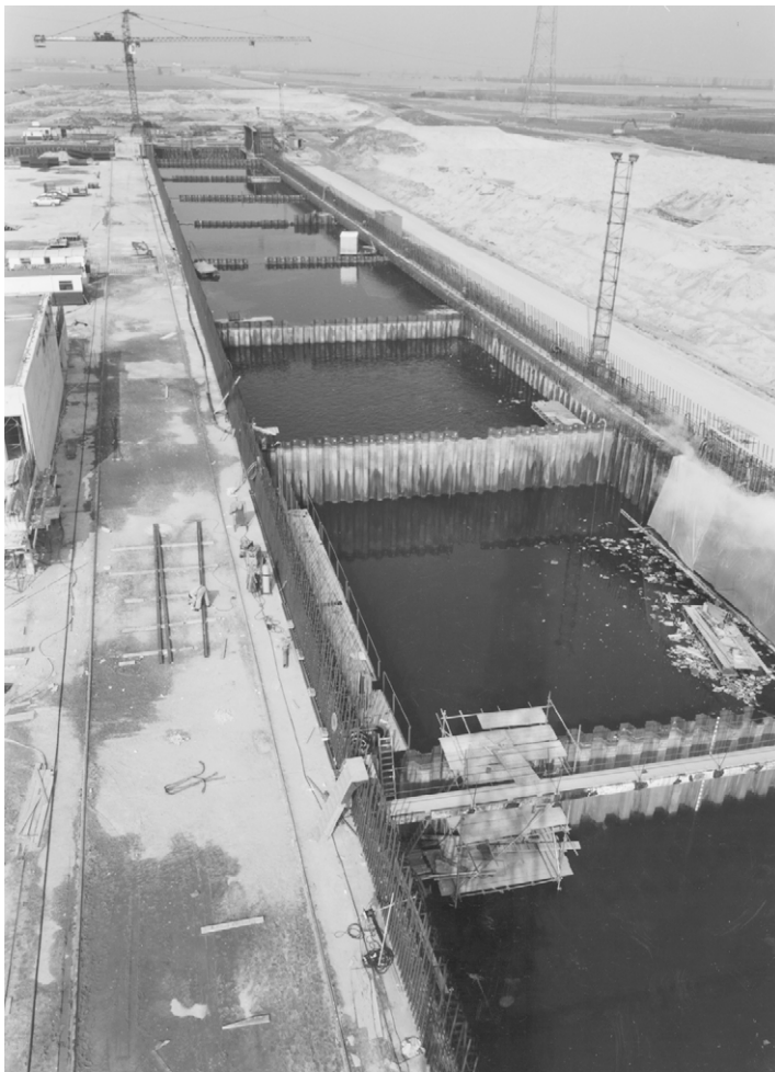
Foto 13.11 Eerste stadium bouw kolkwand door aanbrengen van laaggeplaatste damwanden van schutsluizen te Hansweert (met compartimenteringswanden)
