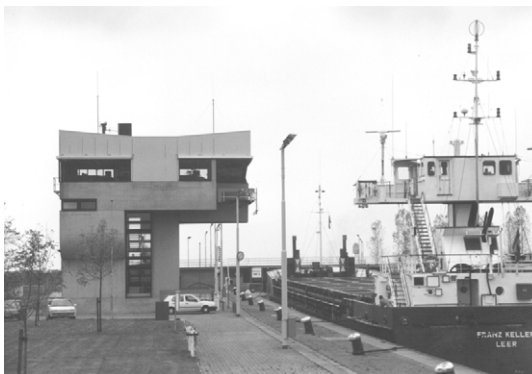
Foto 18.8 Bedieningsgebouw van Middensluis Terneuzen
