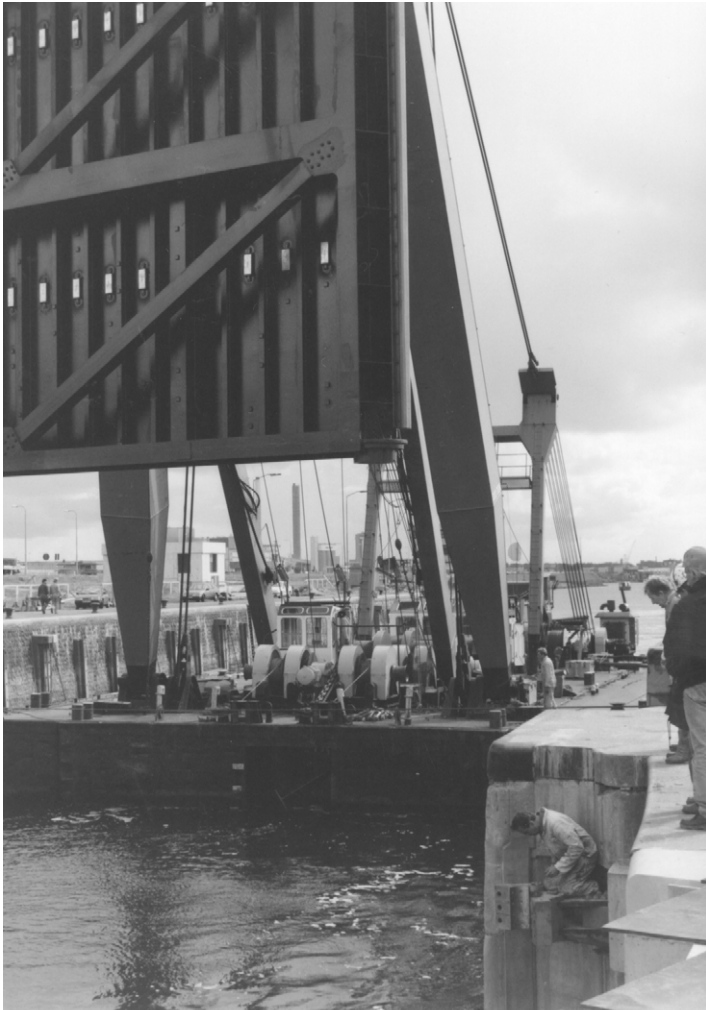
Foto 20.27 Inhangen deur, Middensluis te IJmuiden
