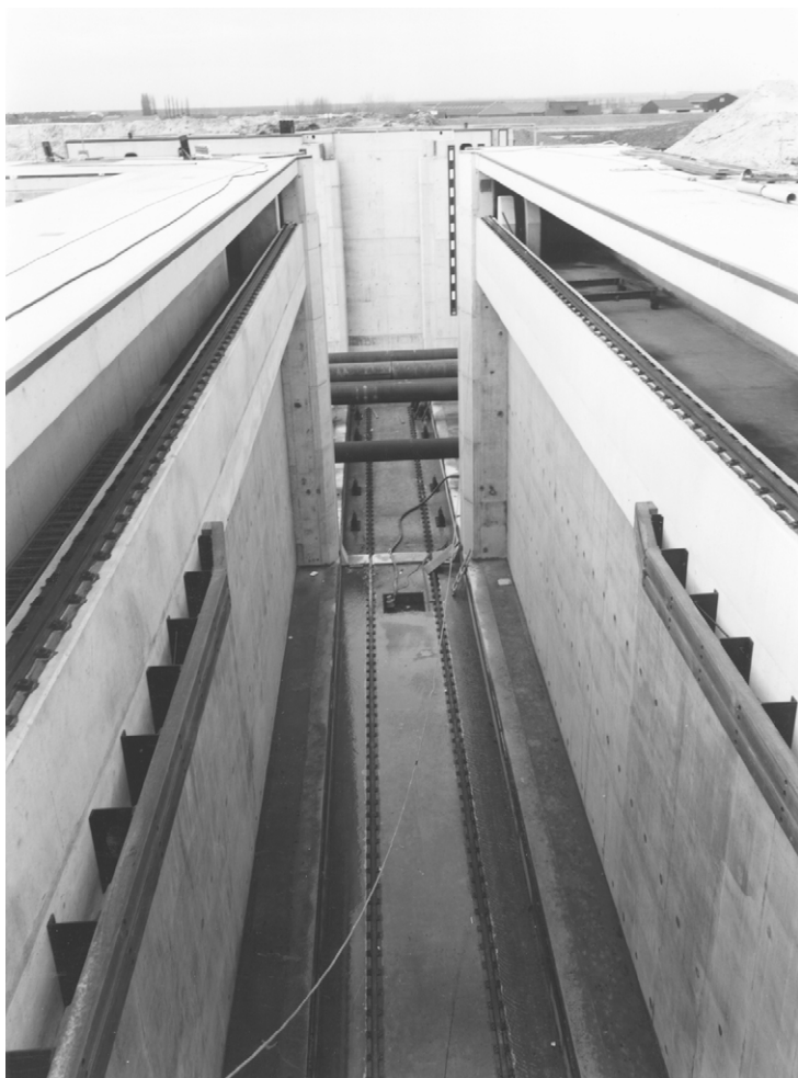
Foto 8.5 Deurkas van roldeur van duwvaartsluizen te Hansweert
