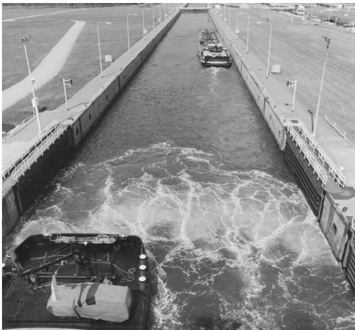
Foto 21.5 Luchtbellenscherm na openen deuren, Duwvaartsluizen Volkerak
