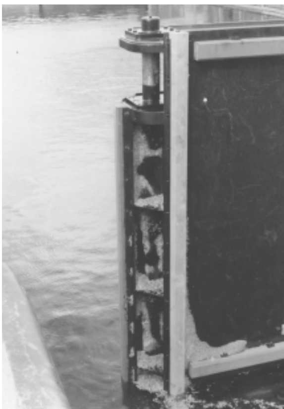
Foto 7.11 Halspen van de puntdeur van Middensluis IJmuiden
