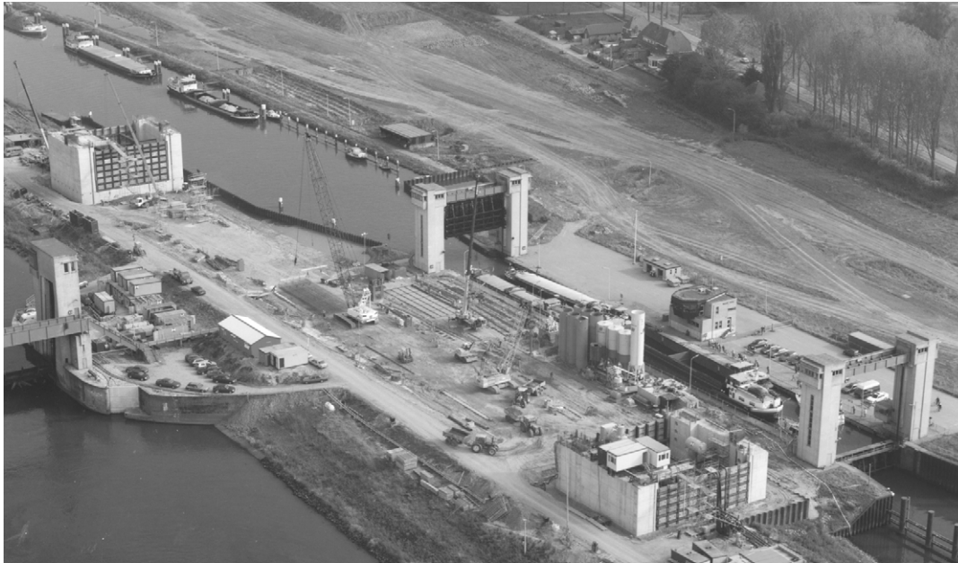
Foto 13.16 Tweede schutsluis Lith in aanbouw met caissons voor beide sluishoofden; op achtergrond eerste schutsluis
