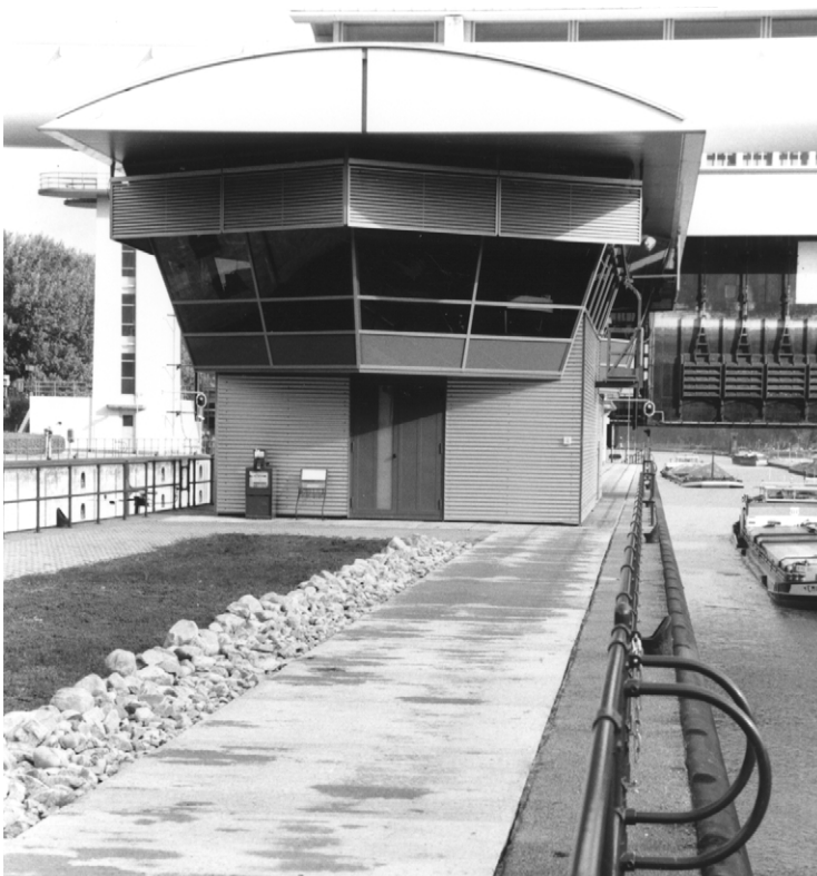
Foto 17.12 Bedieningsgebouw op middenwand van Prinses Beatrixsluizen te Nieuwegein
