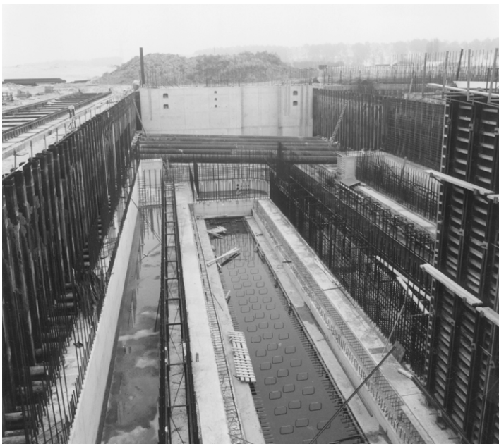
Foto 13.6 Damwandkuip voor roldeurkassen van schutsluizen te Hansweert
