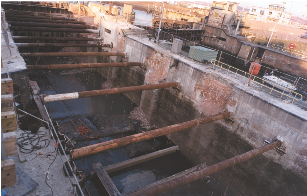
Foto 23.3 Stempeling wanden, onderwaterbetonvloer met groutankers, Kleine Sluis
