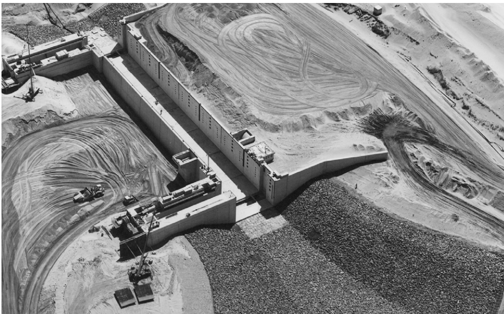
Foto 16.2 Bodem- en oeverbescherming Roompotsluis (Oosterscheldekering), aangebracht in den droge
