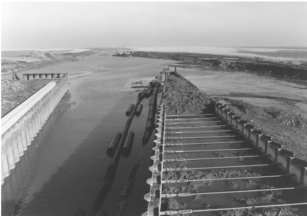
Foto 14.3 Stalen damwand als kistdam, sluis Nieuwe Statenzijl
