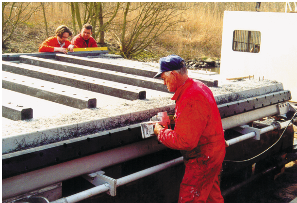
Schaven van kunststof sluisdeur
