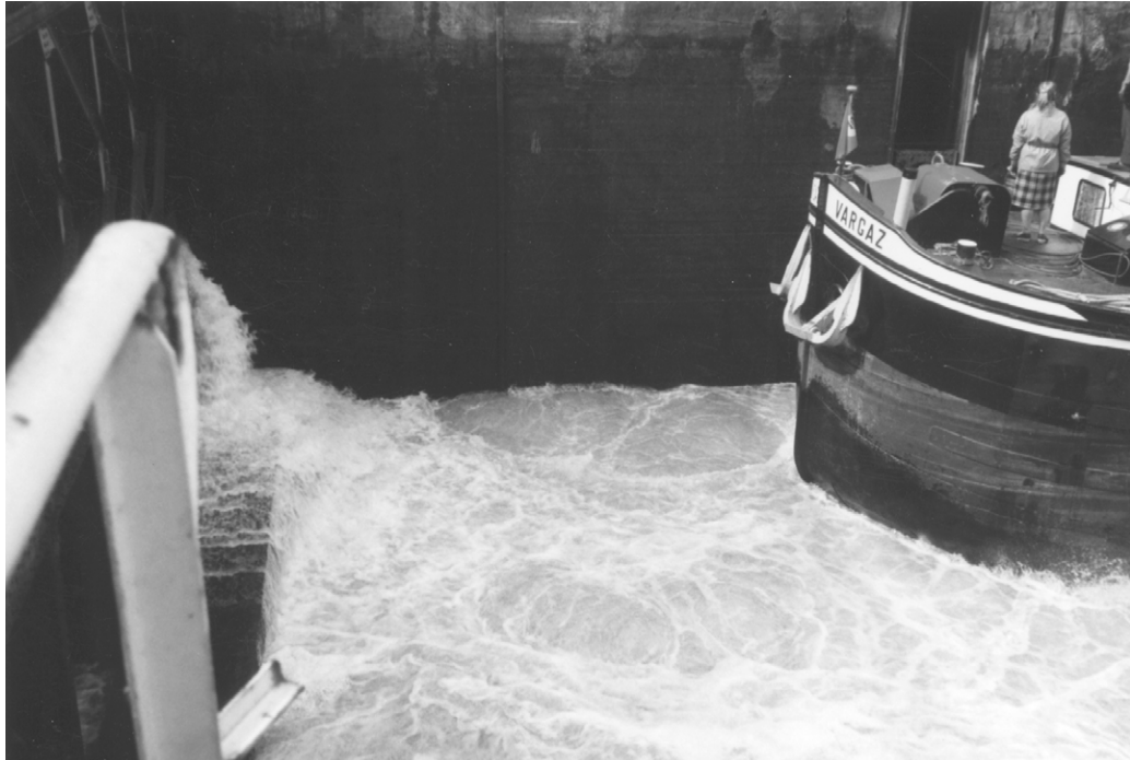
Foto 6.2 Stroombeeld tijdens vullen d.m.v. heffen bovendeur van oude sluis te Born
