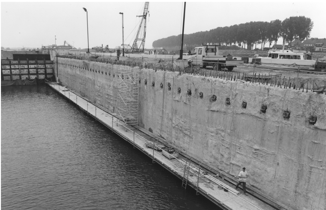
Foto 13.9 Sluiskolk van diepwanden met (nog aan te brengen) betonnen voorwanden en onderwaterbetonvloer van Tweede sluis te Lith
