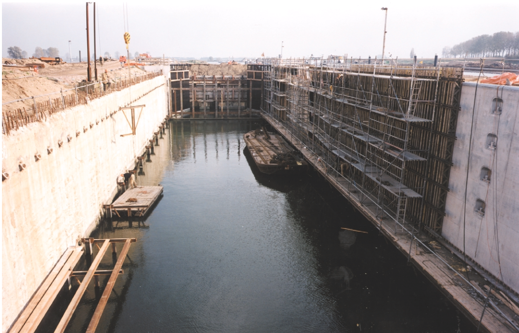
Foto 23.16 Aanbrengen betonnen schorten aan diepwandpanelen
