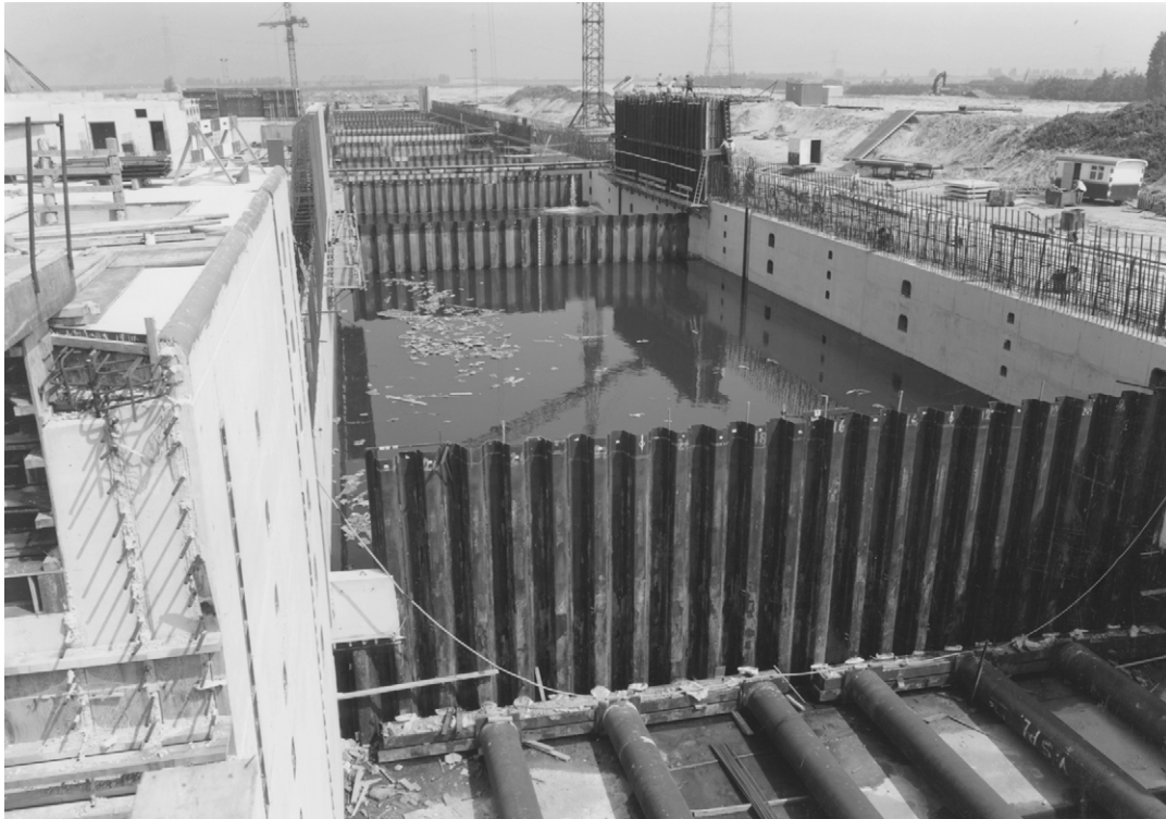
Foto 13.12 Verdere afbouw kolkwand door aanbrengen van hooggefundeerde L-muren van schutsluizen te Hansweert
