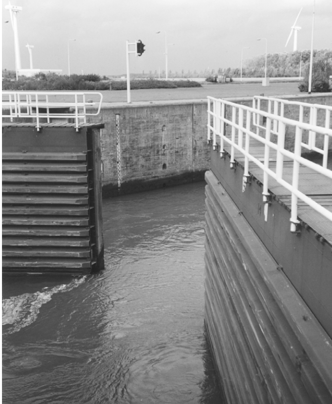
Foto 11.2 Stroming door deurbeweging en door restverval tijdens openen puntdeuren (Volkeraksluizen)
