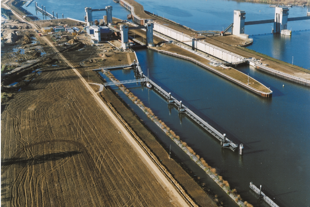
Foto 23.20 Bovenstroomse voorhaven sluiscomplex te Lith met recreatiesteiger en opstelplaats beroepsvaart
