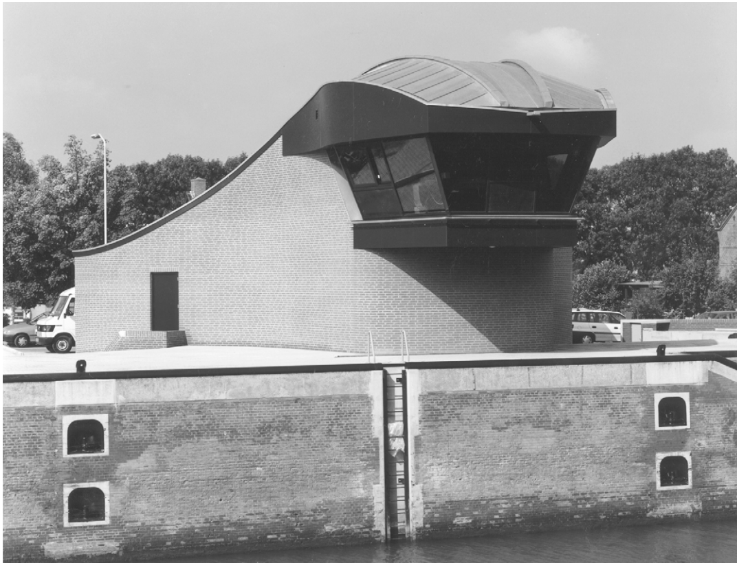
Foto 17.8 Bedieningsgebouw van sluis te Gorinchem
