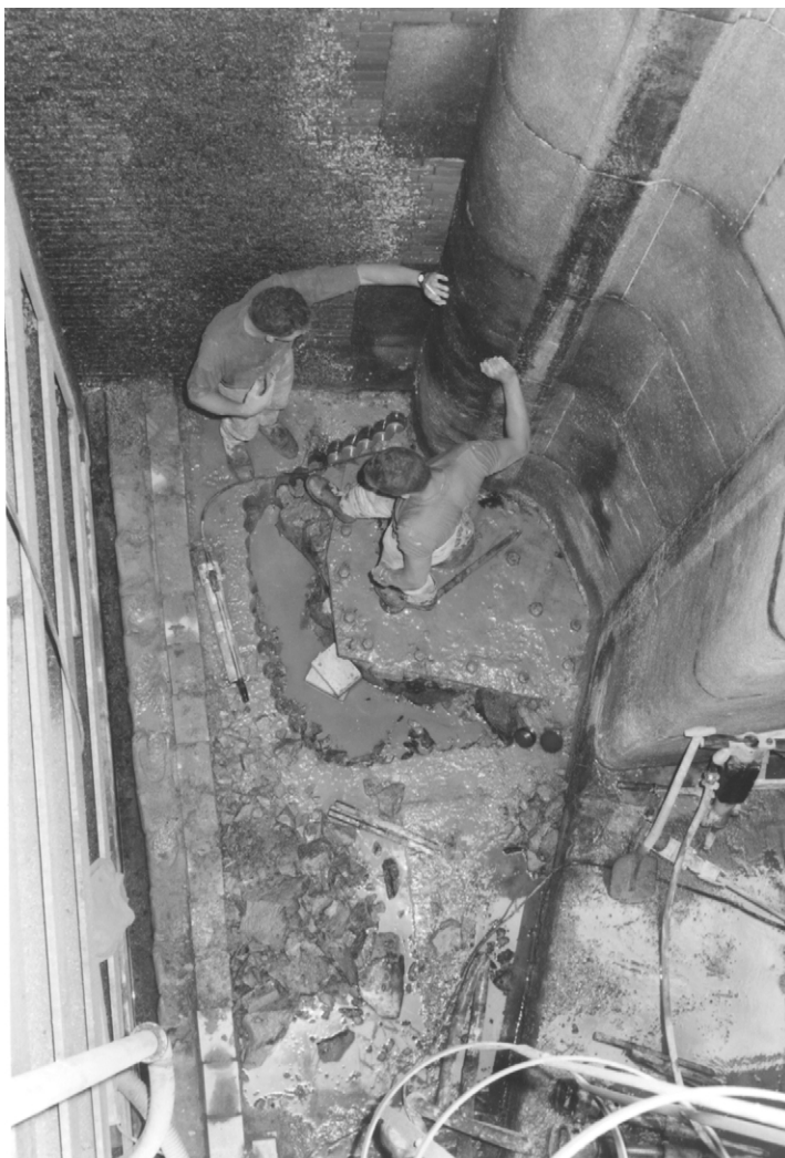
Foto 20.19 Werken binnen de taatskuip, verwijderen oude taats, Middensluis te IJmuiden
