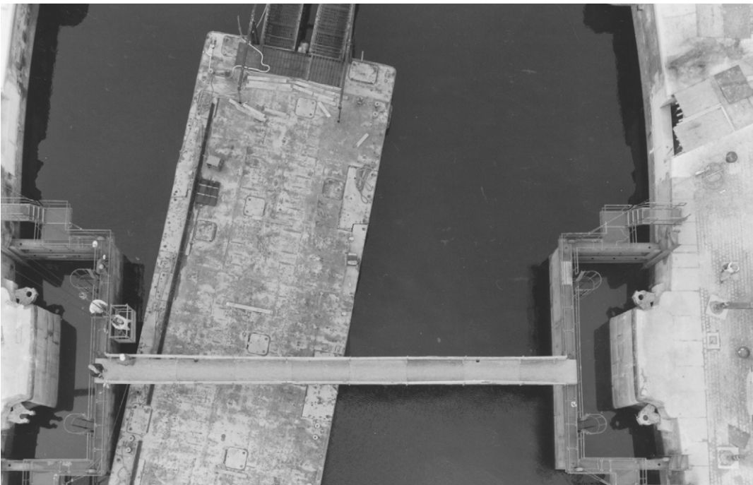
Foto 20.18 Overzicht taatskuipen tijdens reconstructie, Middensluis te IJmuiden
