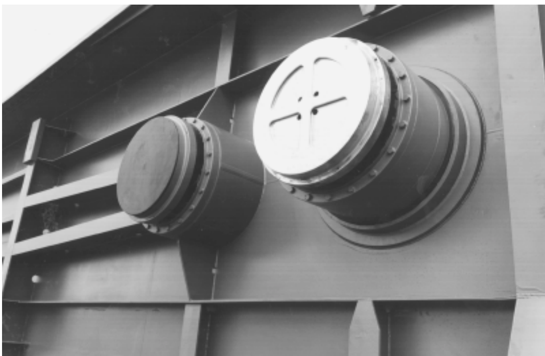
Foto 7.28 Vaste draagvoet en hydrostatisch lager van glijdeur van Nieuwe Oranjesluis te Amsterdam
