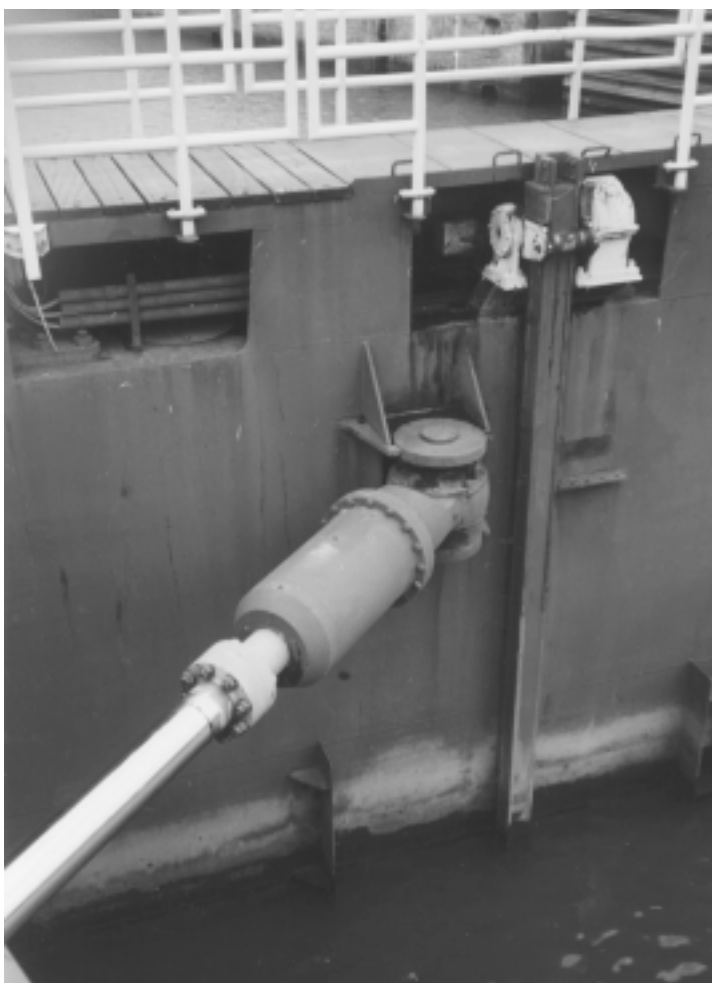
Foto 7.19 Hydraulische cilinder deurbewegingswerk en rechte heugelstang schuifbewegingswerk van duwvaartsluizen in de Volkerak
