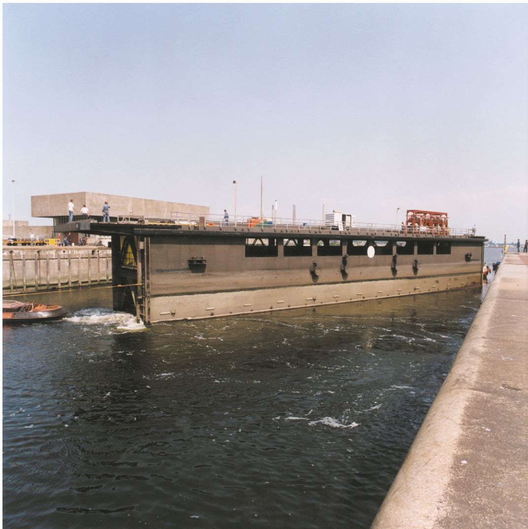
Foto 19.1 Verwisselen roldeur van de Noordersluis te IJmuiden
