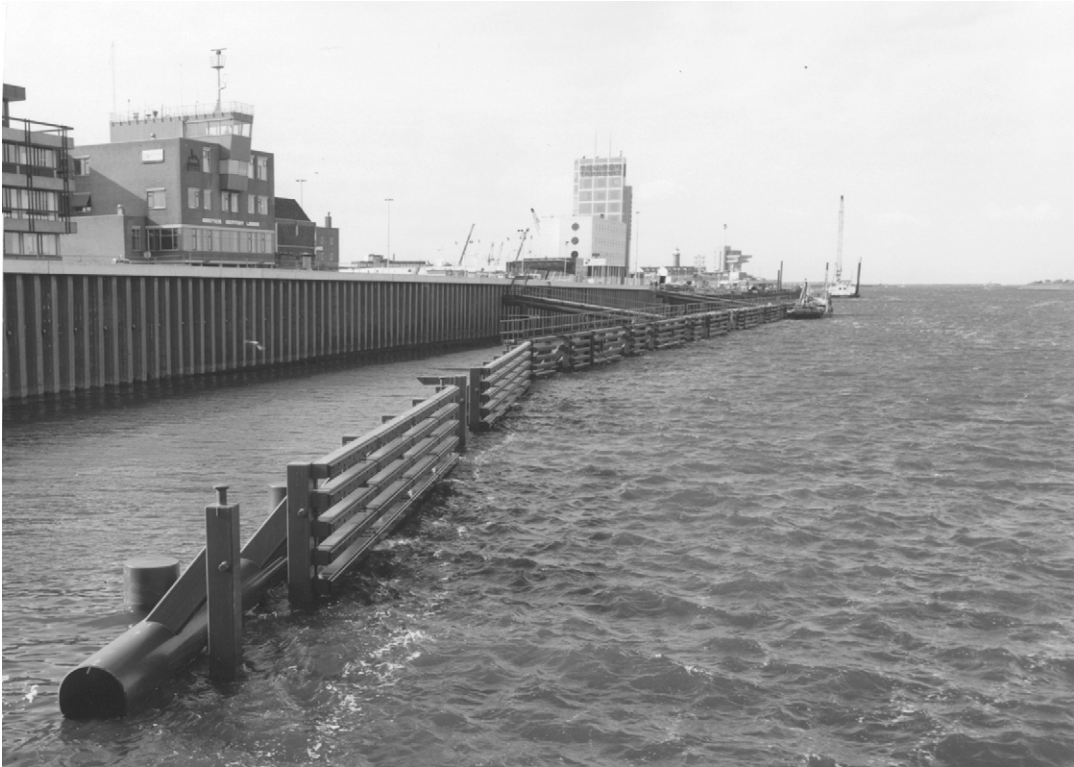
Foto 15.13 Spanten en schorten aan buisligger van vast geleide- en remmingwerk van Kleine Sluis te IJmuiden tijdens de bouw
