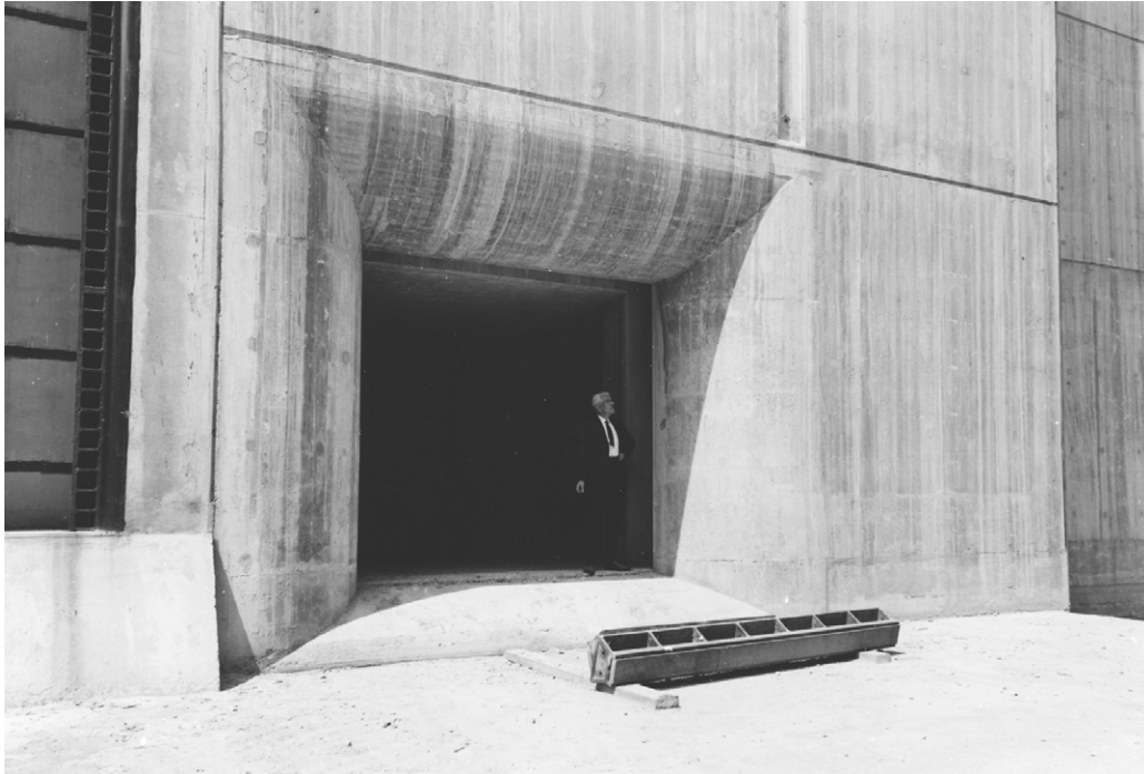
Foto 6.18 Instroomopening omloopriool van benedenhoofd van sluizen te Maasbracht
