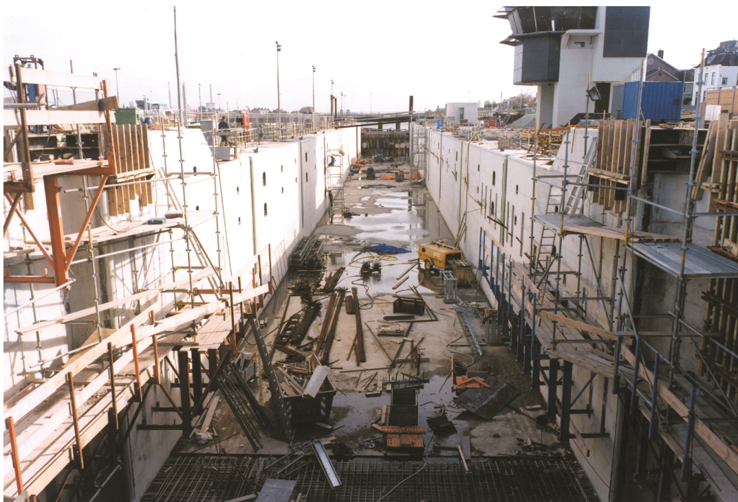
Foto 23.6 Kleine Sluis in afbouwstadium met zicht op kolk en binnenhoofd
