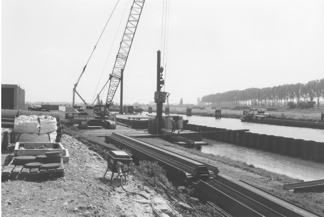
Foto 14.8 Trillen van damplanken voor sluiscomplex te Lith
