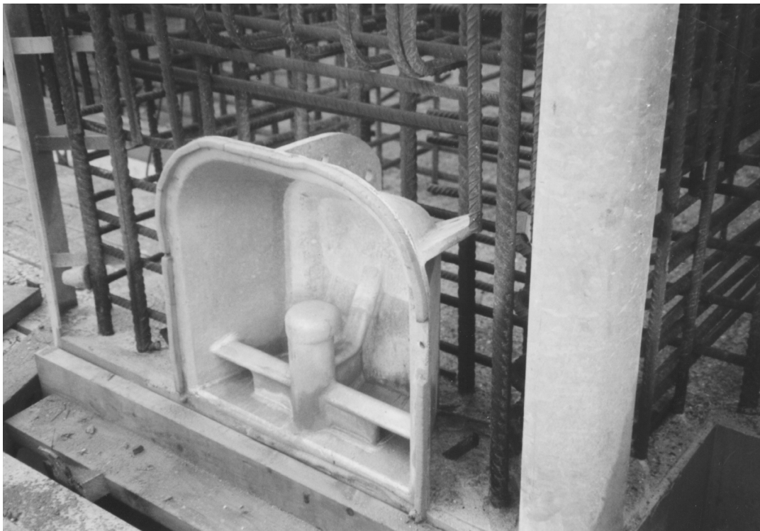
Foto 13.15 Haalkom voor hoofd van Tweede schutsluis te Lith (ankers moeten nog aangebracht worden)
