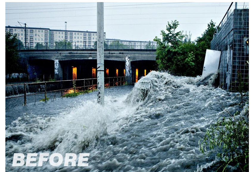
Waterlogging in Copenhagen Source: Atelier Dreiseitl
