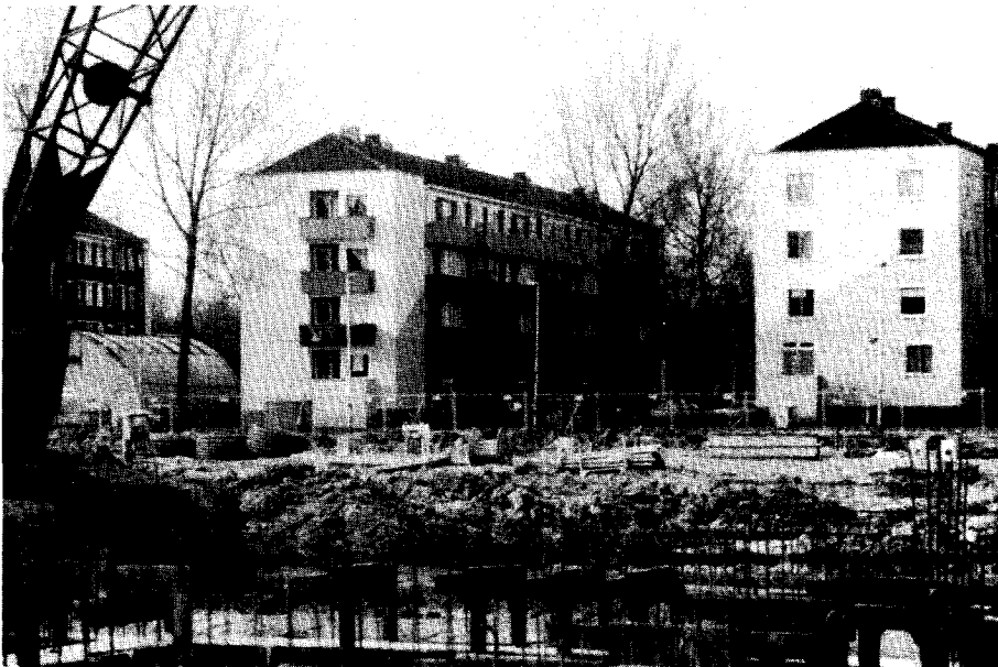
Vervangende nieuwbouw in wording
