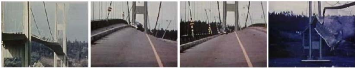
Figuur 53 – Het resoneren met de wind van de Tacoma Narrows Bridge.
